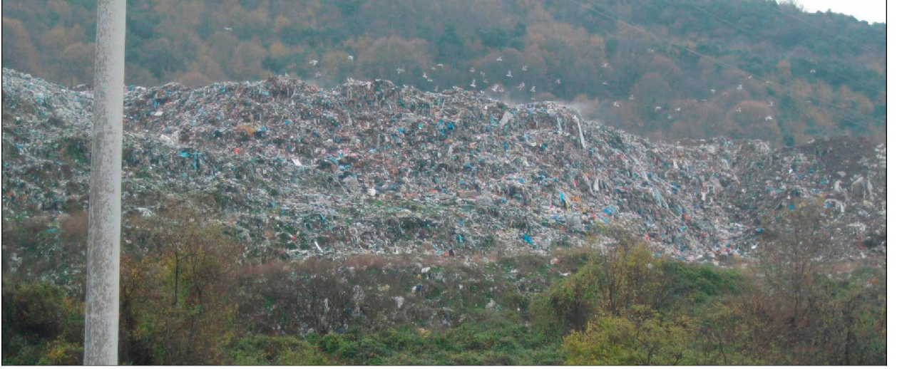
Şekil 3.3 Düzensiz (vahşi) depolama sahası görüntüsü.
