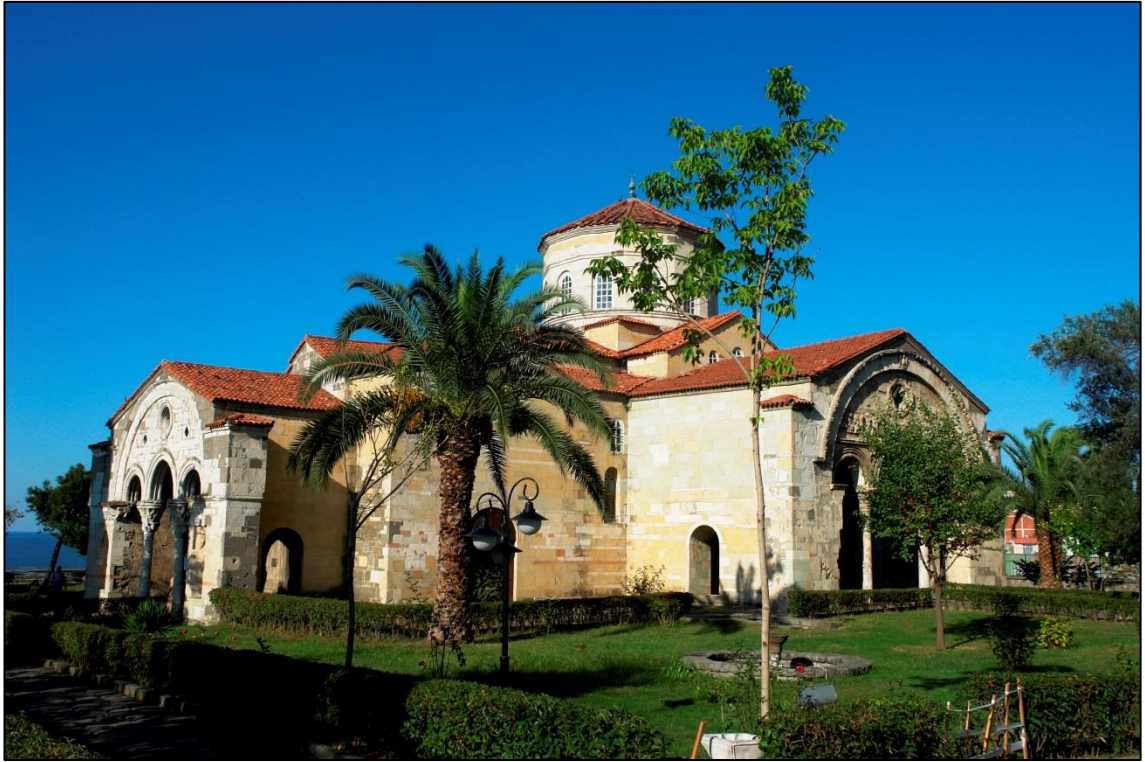
Şekil 45: Ayasofya Kilisesi Genel Görünüm, Trabzon, 13. Yüzyıl (Koch Arşivi, 2011).
