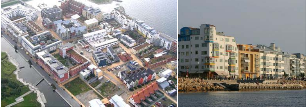
Şekil 4.4: Kıyı bölgesinde konumlanmış yüksek katlı yapılar ( http://www.ekostaden.com )
