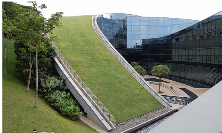
Şekil 3.13: Singapur-Nanyang Teknik Üniversitesi çatı bahçesi ( http://www.arkitera.com )
