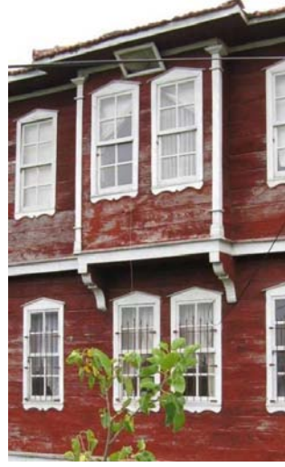
Şekil B.122 : Göğüslemeli çıkmanın 'eliböğünde' hali
