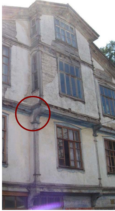
Şekil B.126 : Basit konsol çıkma ve eliböğründenin dekoratif kullanımı
