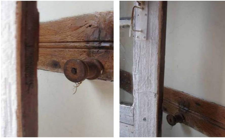
Şekil B.165 : Kapı stoperi ve sandalyelik detayı
