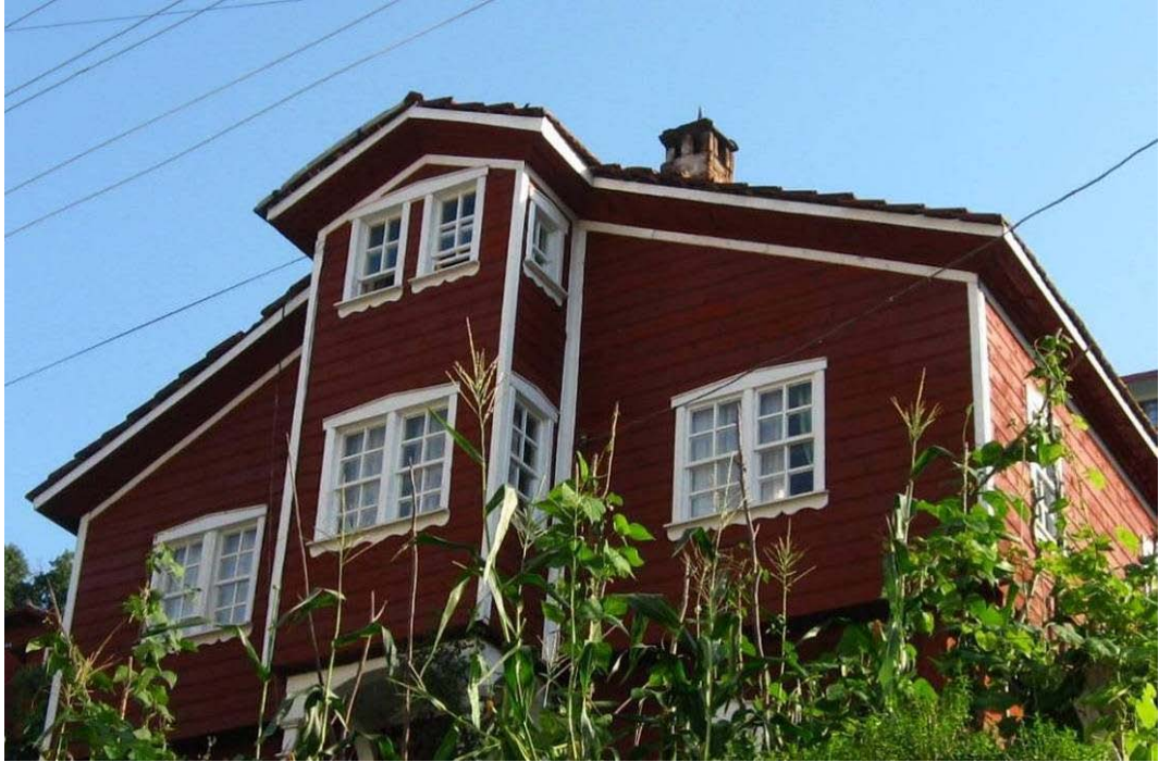
Şekil B.146 : Bitişik giyotin pencereler
