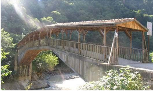
Şekil B.61 : Hapsiyaş Köprüsü, Uzungöl / Trabzon
