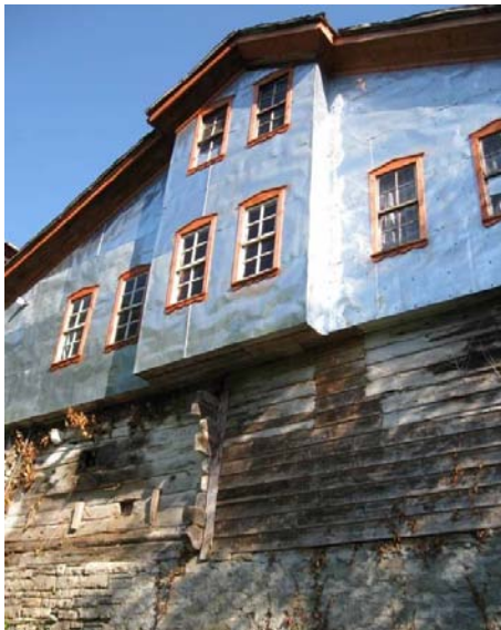
Şekil B.121 : Basit konsol çıkmalar
