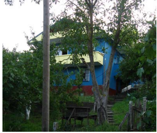
Şekil B.228 : Yeni yapı cephelerinde uygulanan renkler
