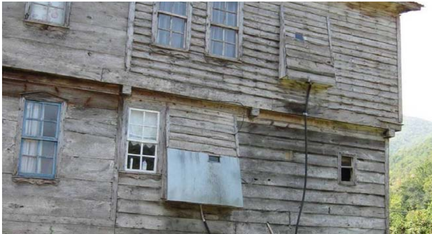
Şekil B.157 : Cephe yüzeyinden görülen lavabo nişleri
