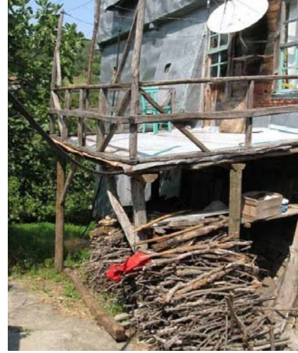
Şekil B.124 : Dikmelere taşıtılan çardaklar
