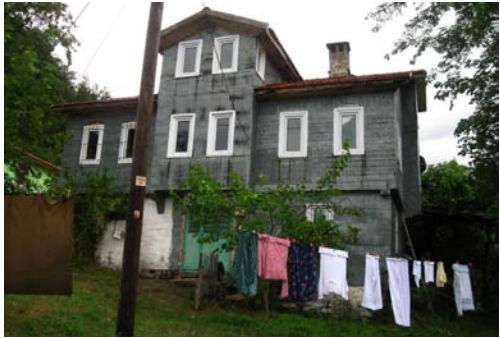
Şekil B.213 : Kapı, pencere ve kaplamasıyla kimliği değişmiş bir cephe
