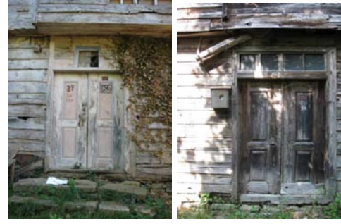
Şekil B.131 : Birbirinden farklı tepe pencereli, çift kanatlı kapılar
