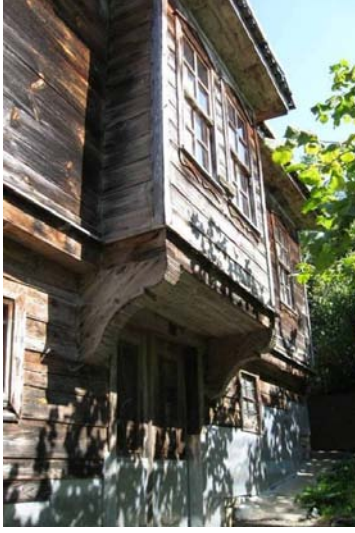
Şekil B.122 : Göğüslemeli çıkmanın 'eliböğünde' hali
