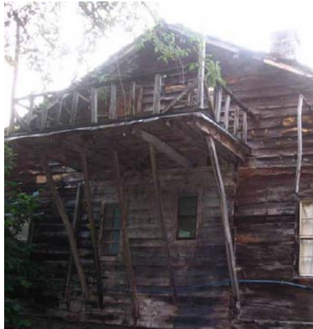
Şekil B.125 : Göğüslemeli çardak örnekleri
