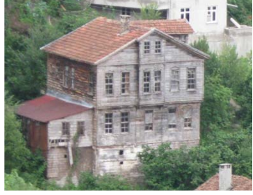
Şekil B.218 : Konuta birleştirilmiş ek yapı örneği
