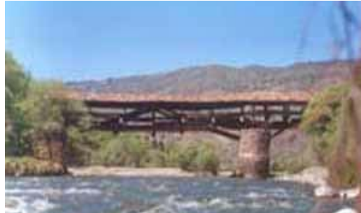
Şekil B.62 : Çaylı Köyü (Melen) Köprüsü, Çerkeş / Çankırı
