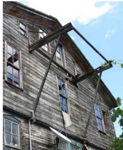
Şekil B.125 : Göğüslemeli çardak örnekleri
