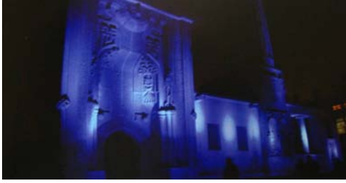
Şekil B.248 : LED sistemle aydınlatılan tarihi bir yapı (raf dergisi)
