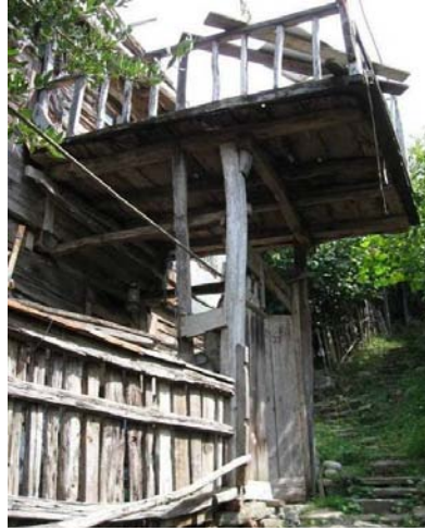
Şekil B.124 : Dikmelere taşıtılan çardaklar
