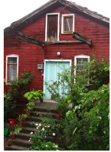
Şekil B.123 : Konsol çardağın kirişlerinin görüldüğü bir örnek
