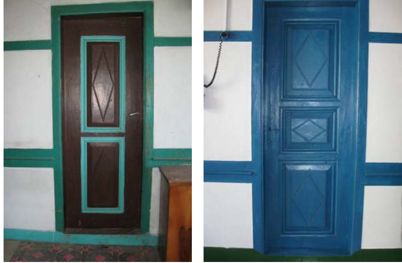
Şekil B.140 : Yağlı boya ile boyanmış iç mekan kapıları ve yatay silmeler
