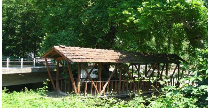
Şekil B.55 : Yeni köprü ve yanında tarihi köprü (güney yönünden)
