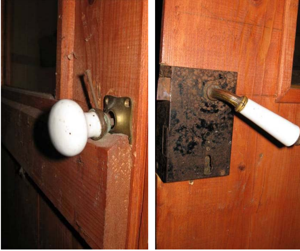
Şekil B.166 : Bir oda kapısının dış ve iç mekana yüzeylerindeki kapı kolları
