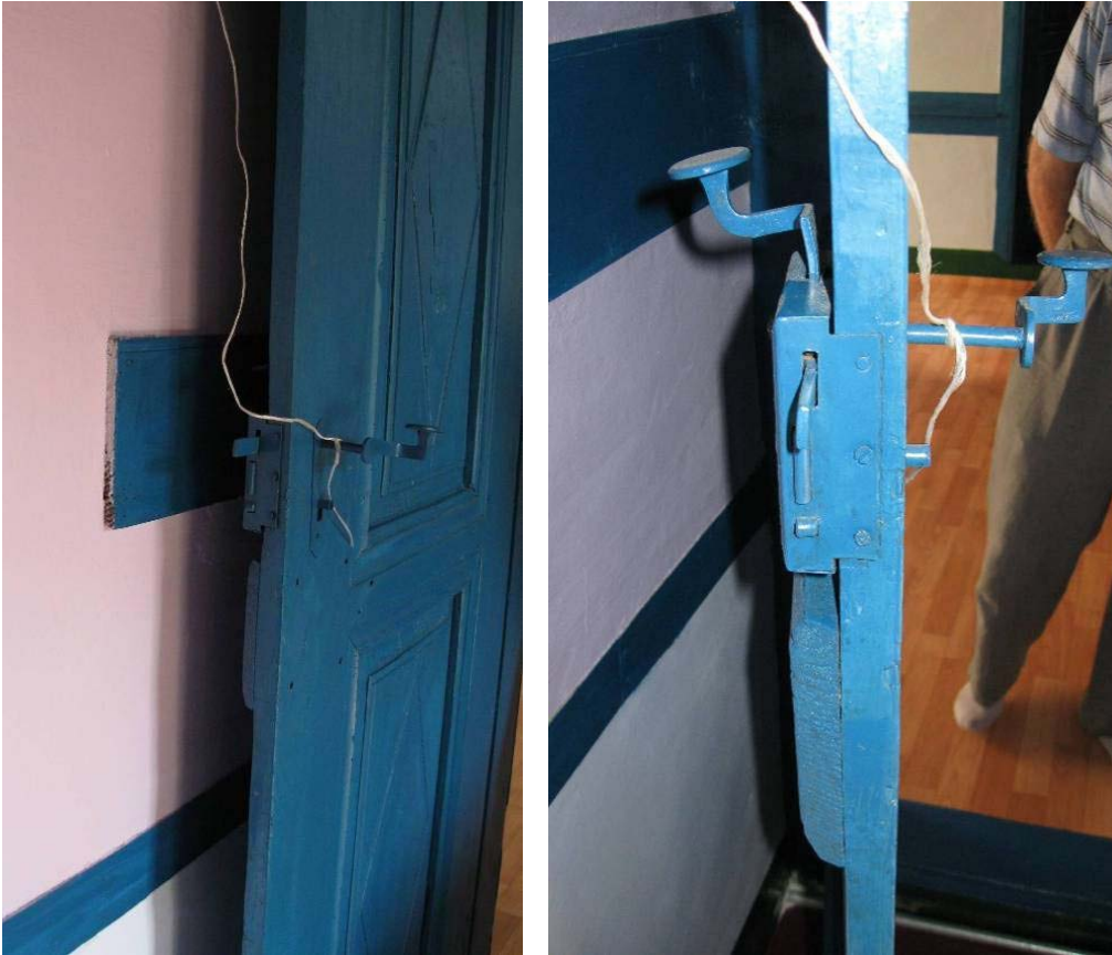
Şekil B.167 : Bir iç kapının kapı kolları ve kilit sistemi
