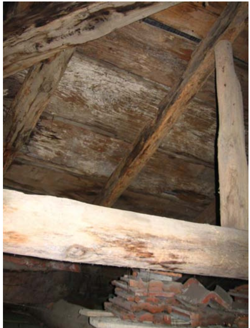
Şekil B.44 : Cumayanı Cami'nin çatı strüktürü
