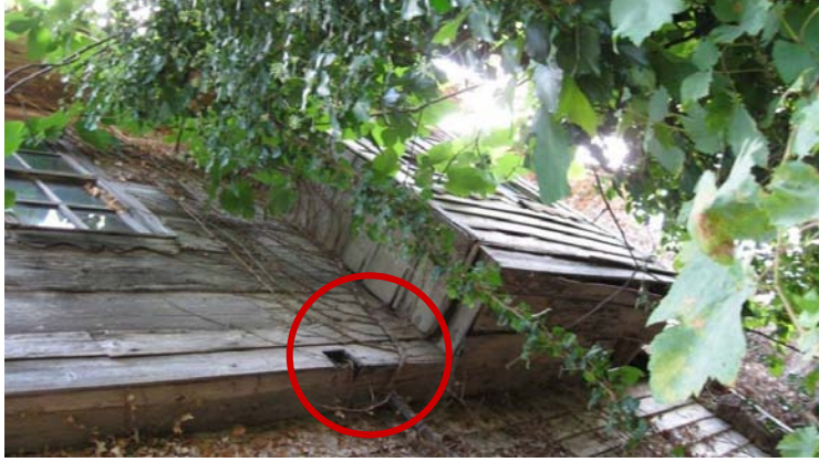
Şekil B.110 : Tercenin dış cepheye verilen pis su giderine örnek
