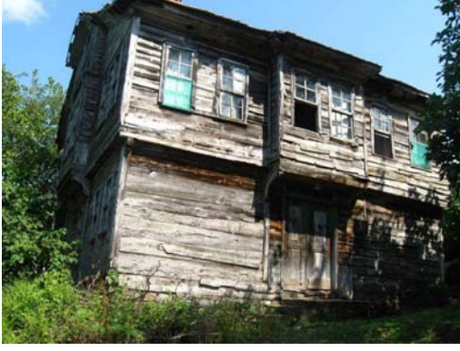
Şekil B.118 : Cephenin orta aksında yer alan düz çıkma
