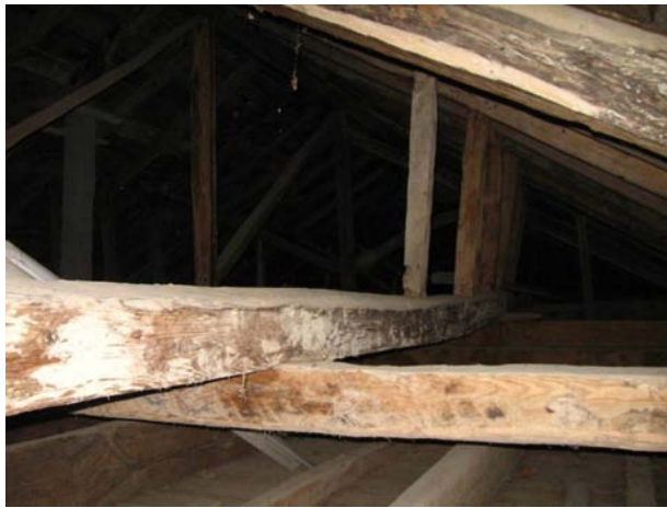
Şekil B.45 : Çatı strüktüründe kullanılan, özgün ahşap elemanlar
