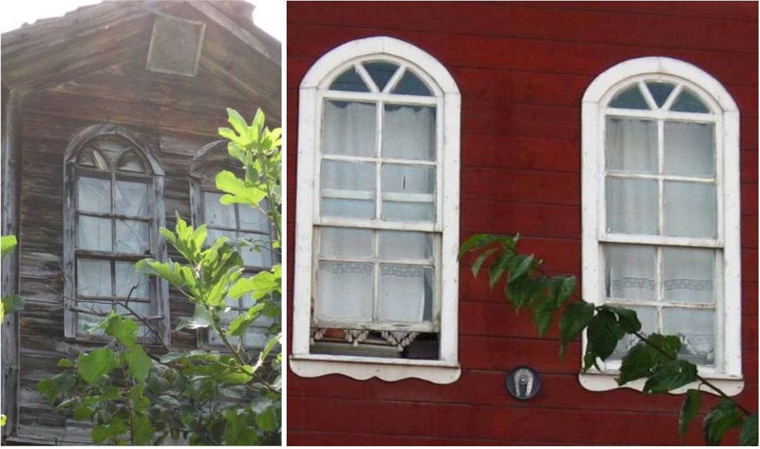
Şekil B.150 : Çıkmalarda görülen kemerli pencere düzeni
