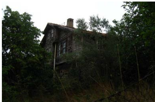
Şekil B.216 : Kullanıcının çözümlendiği tesisatın cephede görünümü
