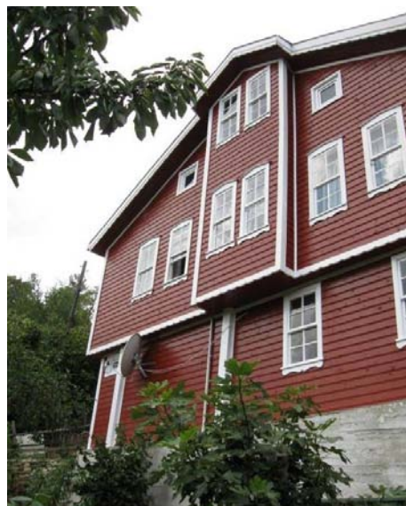
Şekil B.121 : Basit konsol çıkmalar
