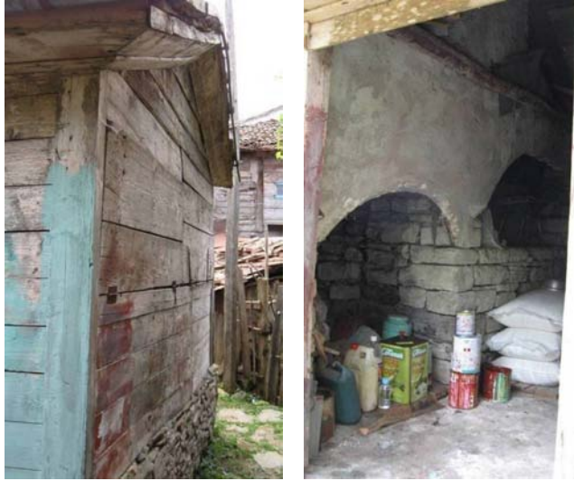
Şekil B.111 : Konutlarda ekme  pişirilen taş fırının iç ve dış görünüşü
