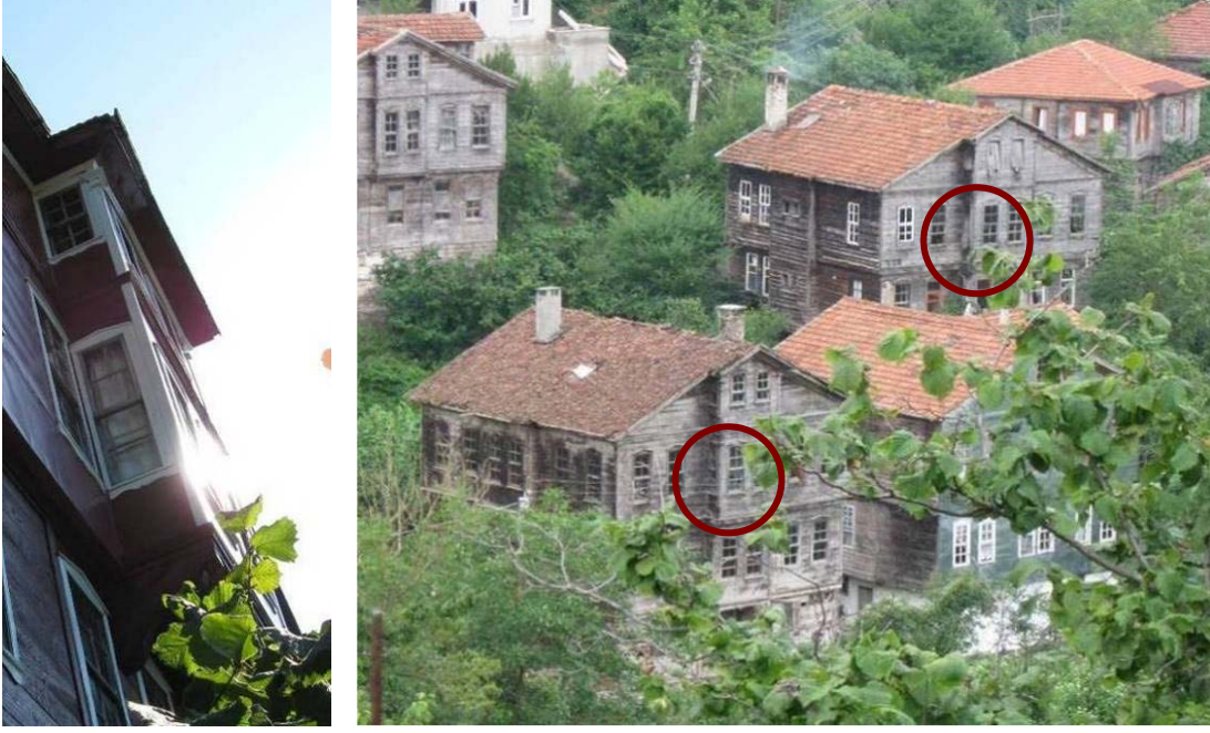
Şekil B.143 : Çıkmaların yan yüzlerindeki pencerelerden örnekler
