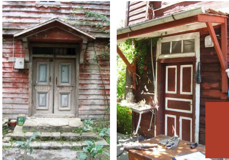
Şekil B.192 : Tek işlevli olarak düzenlenmiş saçaklar
