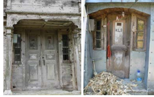
Şekil B.133 : Sadece yan pencereleri bulunan çift kanatlı ve tek kanatlı kapılar
