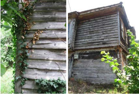
Şekil B.203 : Yalibaskı detayı ve yığma – karkas sistem (karma sistem) ev
