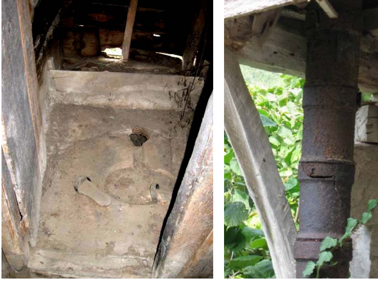
Şekil B.109 : Eski bir hela taşı ve metalden pis su borusu
