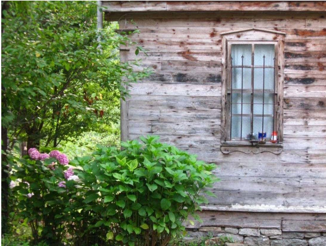
Şekil B.148 : Üçgen alınlıklı 1/2 oranında giyotin pencere
