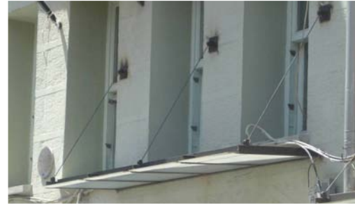
Şekil B.252 : Dükkanların cephelerinde kullanılan saçak örneği (Fener-Balat)
