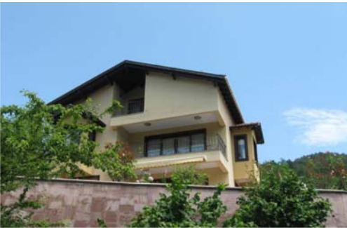
Şekil B.238 : Çalışma alanı içinden yeni yapı örneği
