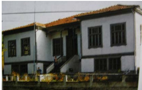
Şekil B.52 : Okulun kullanımda olduğu 90'lı yıllara ait görünüm
