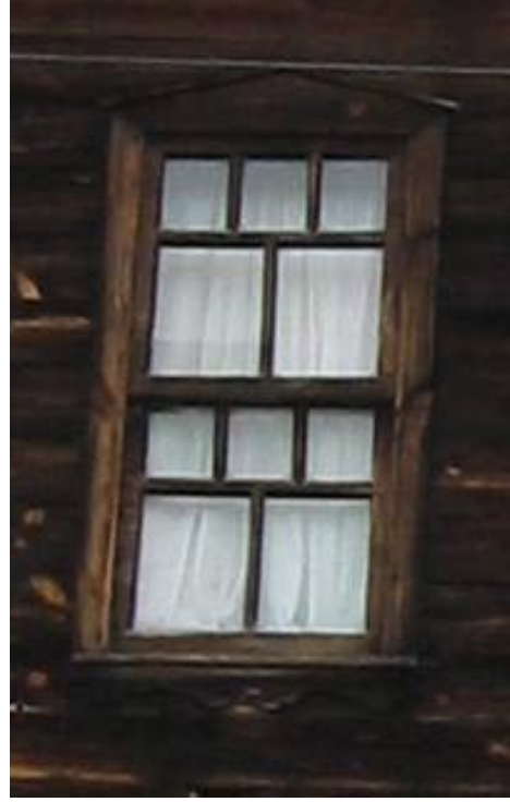
Şekil B.145 : 1/2 oranında farklı düzende giyotin pencereler
