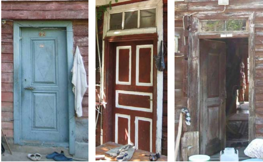
Şekil B.136 : Tek kanatlı pencere ve penceresiz kapılar
