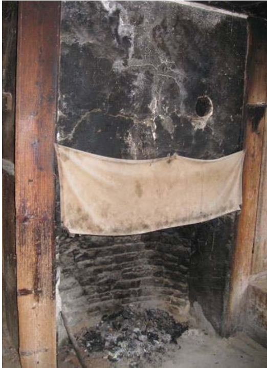
Şekil B.183 : Aynı konutun mutfak ocağı ve oda ocağı
