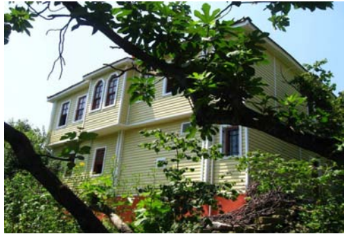
Şekil B.214 : Cephesi plastik esaslı malzemeyle kaplanmış bir konut örneği
