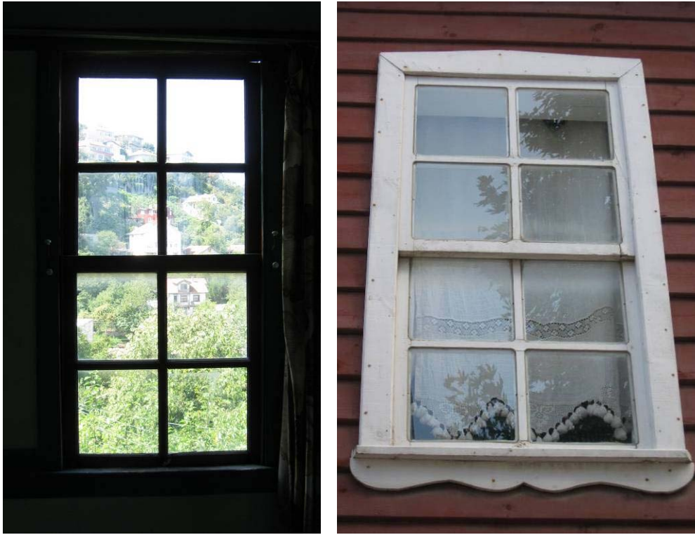
Şekil B.144 : Özgün, giyotin pencerenin iç ve dış görünüşü
