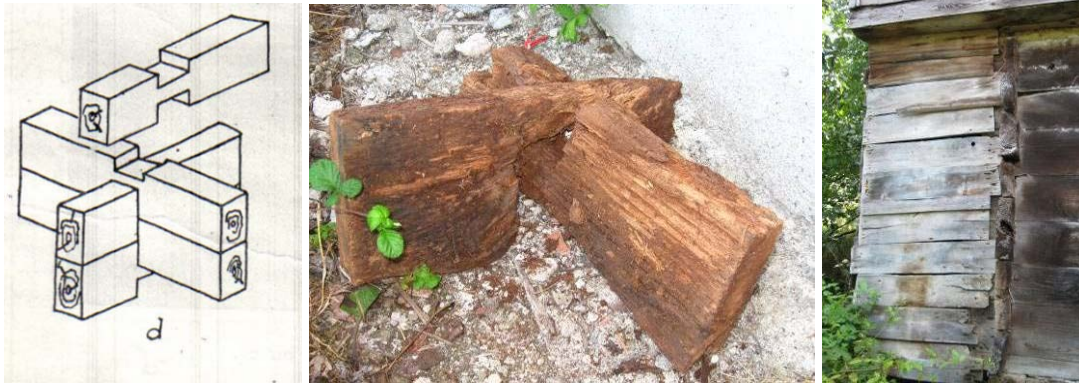
Şekil 3.3 : Ahşap yığma sistem çizimi 12 ve köydeki evlerden sisteme dair örnekler
