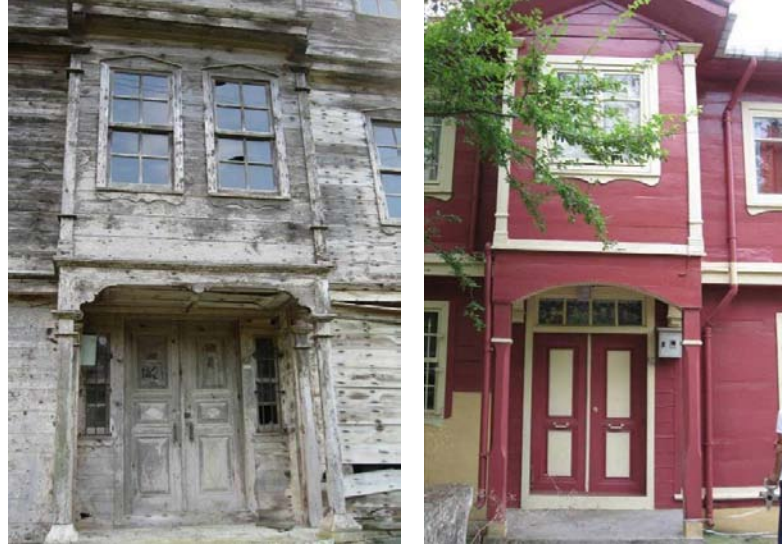
Şekil B.190 : Saçak görevi yapan sütunlu çıkmalar
