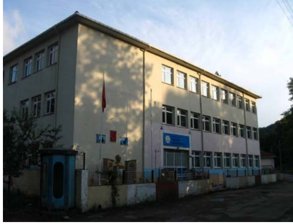
Şekil B.48 : Sağlık evi yanındaki yeni okul binası
