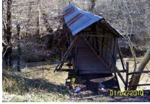
Şekil B.58 : Azdavay Köprüsü, Azdavay / Kastamonu
