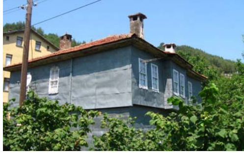
Şekil B.212 : Cephe kaplamasında kullanıcı müdahalesi
