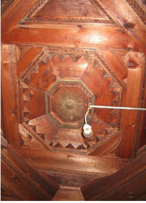
Şekil B.172 : Ahşap tavan göbek ve köşe detayı (E155)
