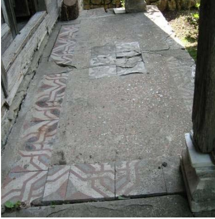
Şekil B.174 : Dış sahanlık üzerinde uygulanmış terazzo kaplama
