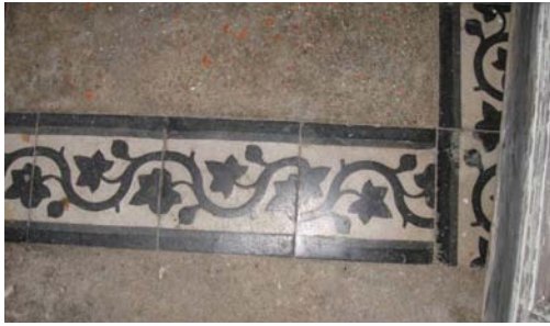
Şekil B.176 : İç mekanda zemine kaplanmış terazzo bordürler
