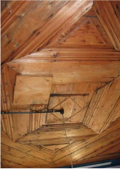
Şekil B.173 : Yalın bir anlayışla düzenlenmiş ahşap tavan örneği (E274)
