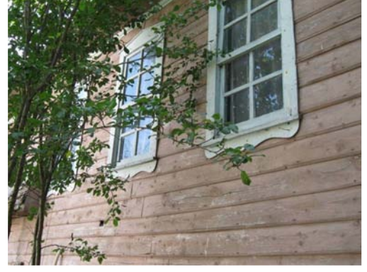
Şekil B.204 : Cephe kaplamasında ahşap yalibaskı uygulaması
