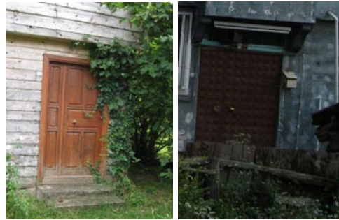
Şekil B.135 : Özgünlerinin yerine kullanılan ahşap ve metal kapılar
