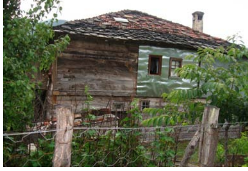
Şekil B.210 : Ahşap cepheyi korumak sacla kaplanmış bir cephe
