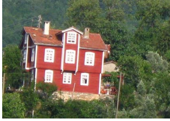
Şekil B.119 : Her iki cephede çıkma uygulaması
