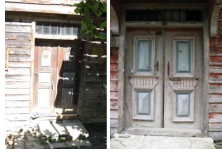
Şekil B.129 : Çift kanatlı ve düz atkılı kapılardan örnekler
