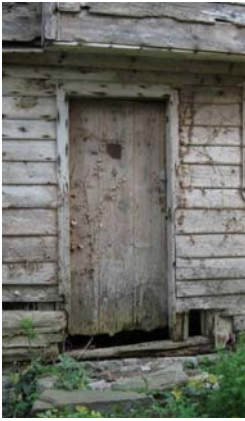
Şekil B.137 : Tek kanatlı servis katı kapıları
