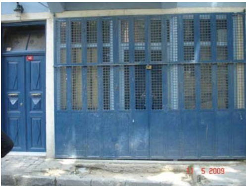
Şekil B.251 : Dükkan cepheleri için uygulanan kepenk örneği (Fener-Balat)
