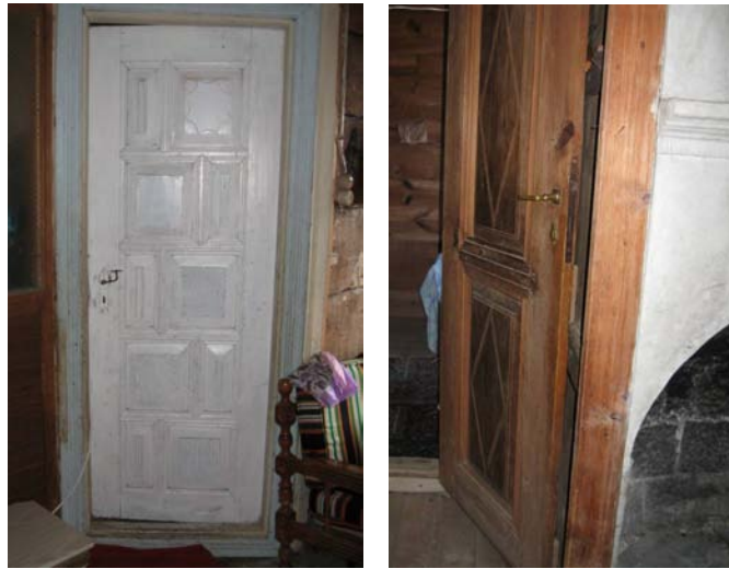
Şekil B.142 : Odalara açılan kapıların sofaya bakan yüzeyleri
