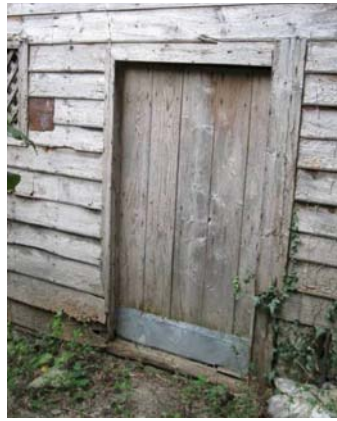
Şekil B.137 : Tek kanatlı servis katı kapıları
