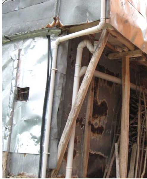
Şekil B.127 : Göğüslemeli çıkma örnekleri
