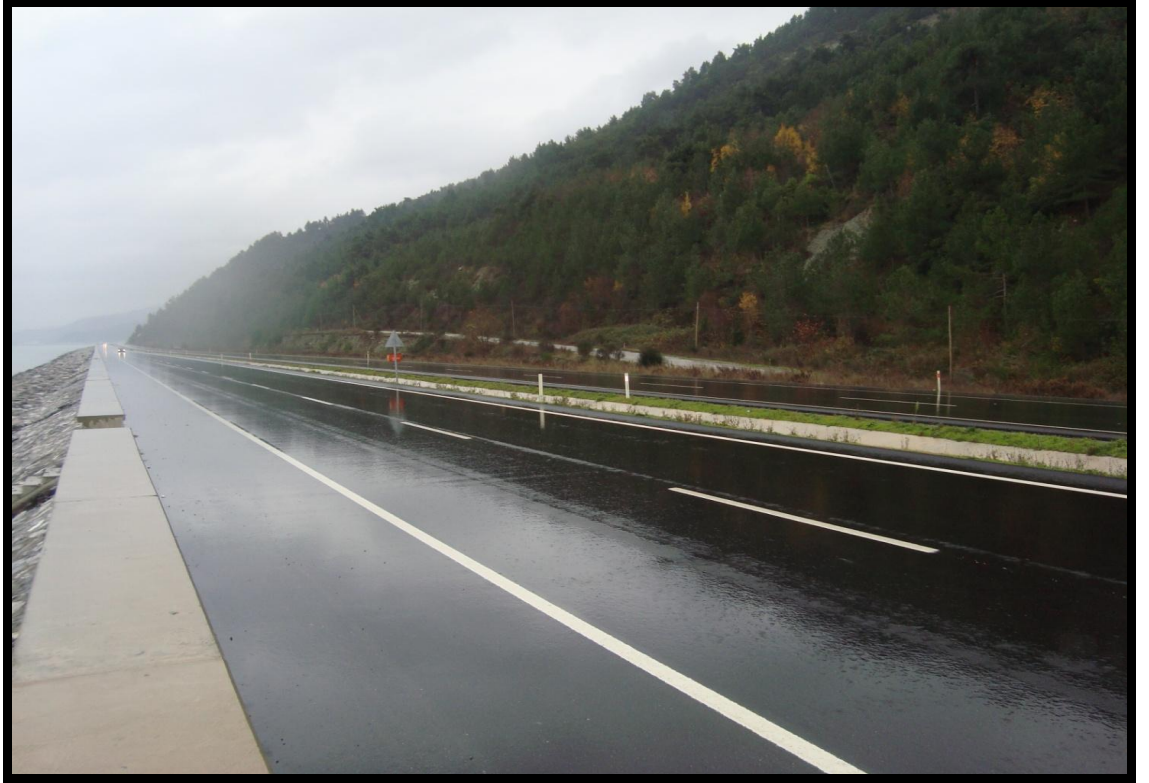
Foto 32. Karadeniz Sahil Yolu Projesi'ne dâhil olan Samsun-Sinop karayolunun bir bölümü araştırma sahasında bulunmaktadır.
