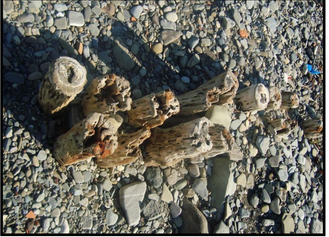
Foto 39. Yakakent Bahelievler Mahallesi sahilinde kazıklı mahmuz kalıntıları
