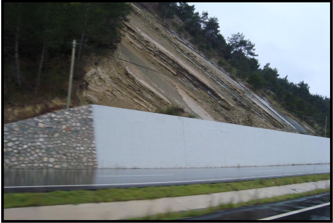
Foto 6. Çamgölü mevkiinde yol yapım çalışmaları ile ölü falez konumu alan aktüel falezler
