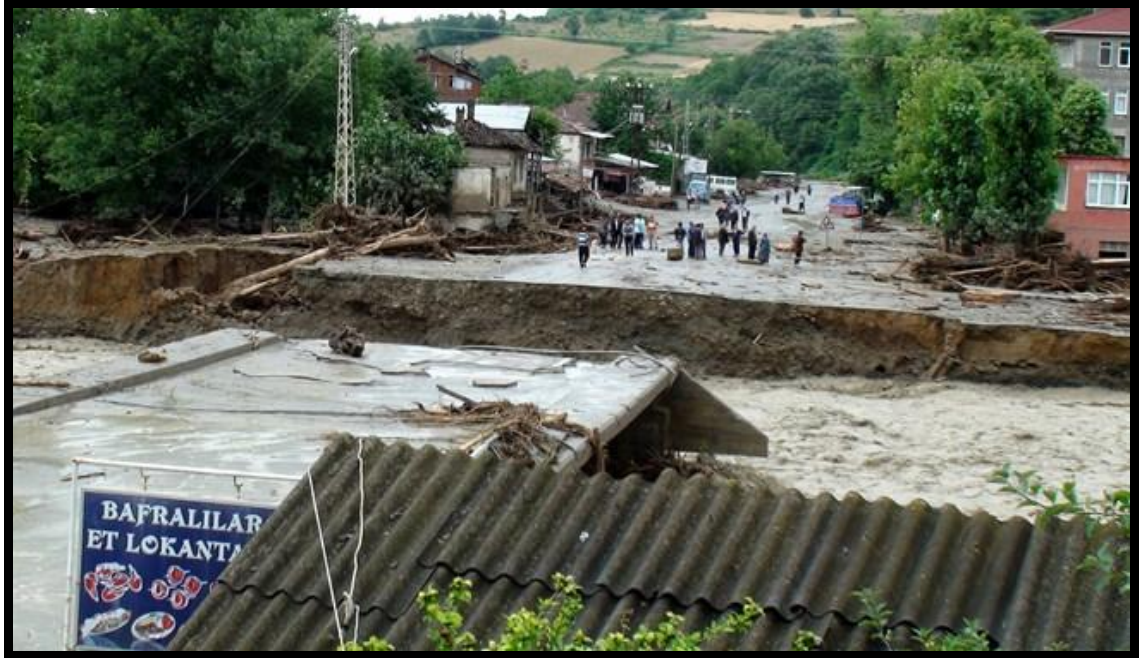
Foto 13. Güzelceçay'da meydana gelen sel sonrası yıkılan köprü (Anonim)
