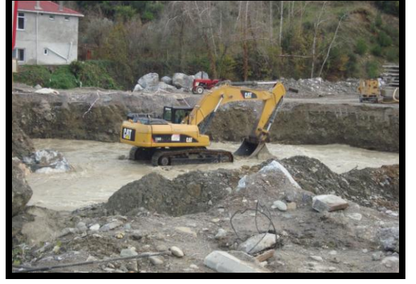
Foto 47. Küplüağzı Çayı'nda yatak genişletme çalışmaları
