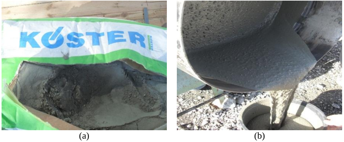
Şekil 2.27 : (a) KÖSTER-VGM5. (b) Dolgu malzemesin hazırlanması.
