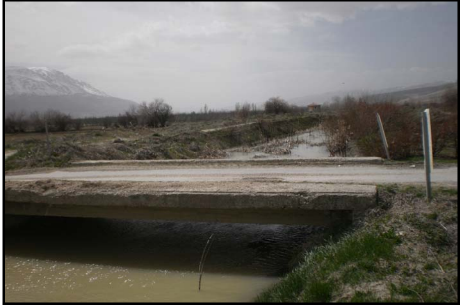
Şekil 3.3. 2. Örnekleme noktası: Ortayazı Köprüsü
