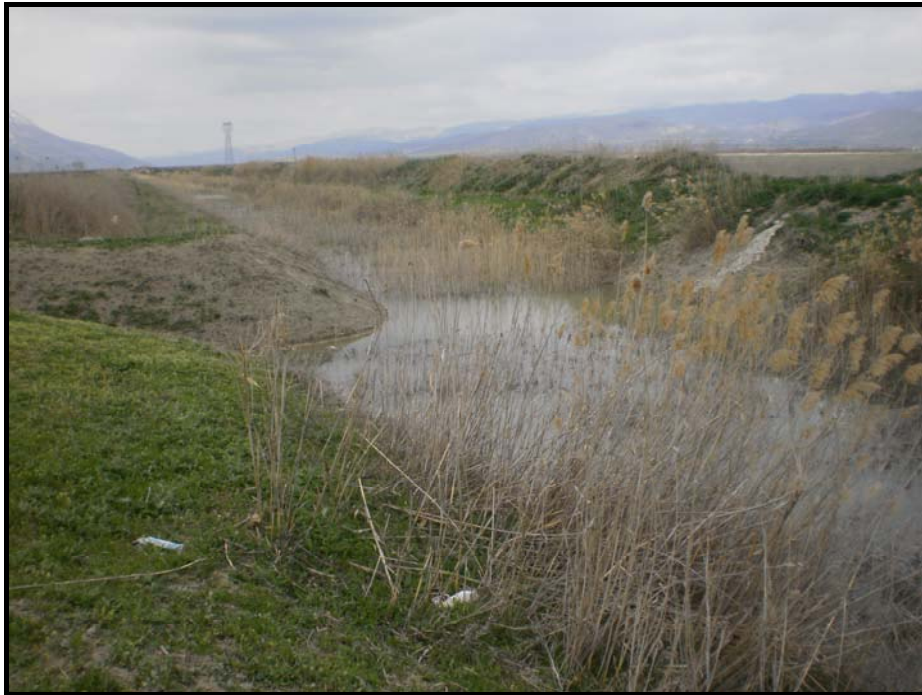
Şekil 4.5. V. İstasyon Kanal Köprü 1 noktası
