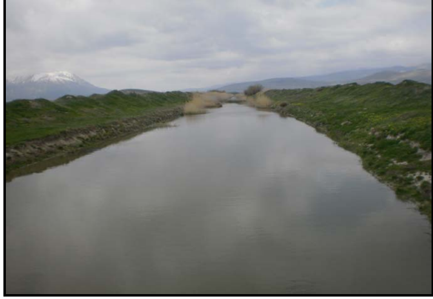
Şekil 3.7. 6. örnekleme noktası: Kanal Köprü 2
