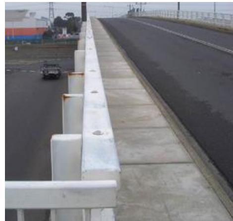
Şekil 3.12 Jeopolimer malzemelerin kaldırım (solda) ve köprü paneli (sağda) uygulamaları (Deventer, et al., 2012)
