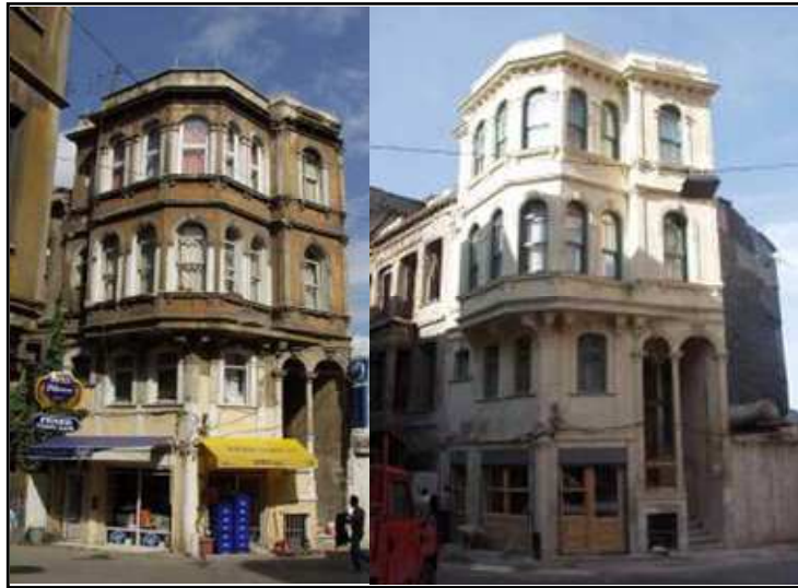
Şekil 4.7 : Tevkii Cafer Mahallesi restorasyon öncesi ve sonrası (Tuncer,2010).
