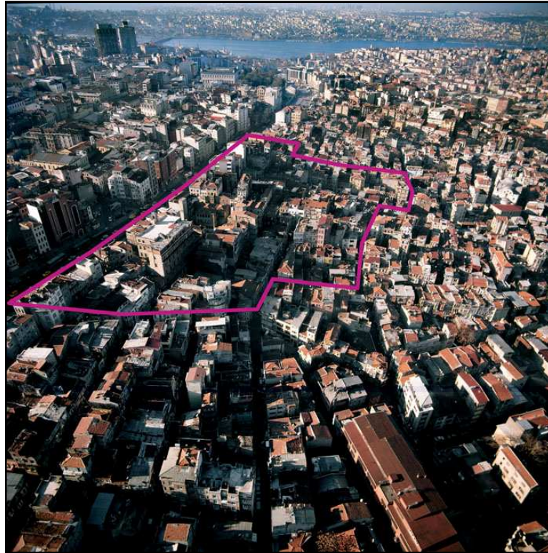
Şekil 4.13 : Tarlabaşı yenileme projesi, proje alanı ( GAP İnşaat).
