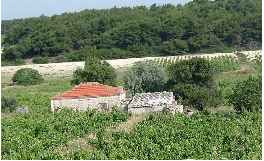
Foto 97: Sındırgı’da taş malzeme kullanılarak yapılmış geleneksel bir bahçe evi
