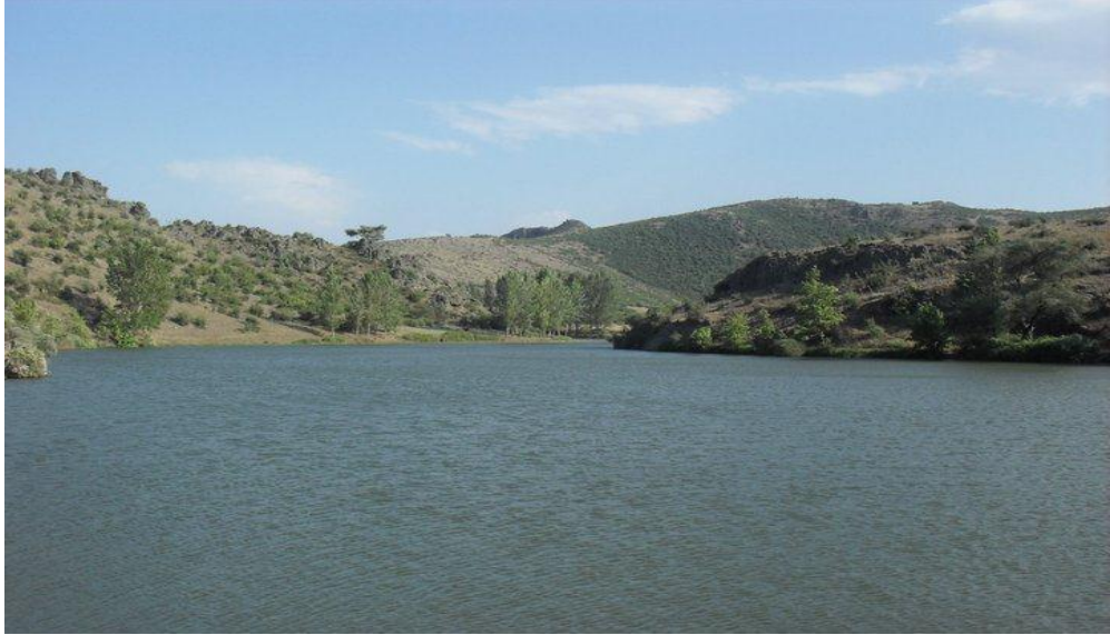
Foto 2: Bigadiç – Yörücekler Barajı
