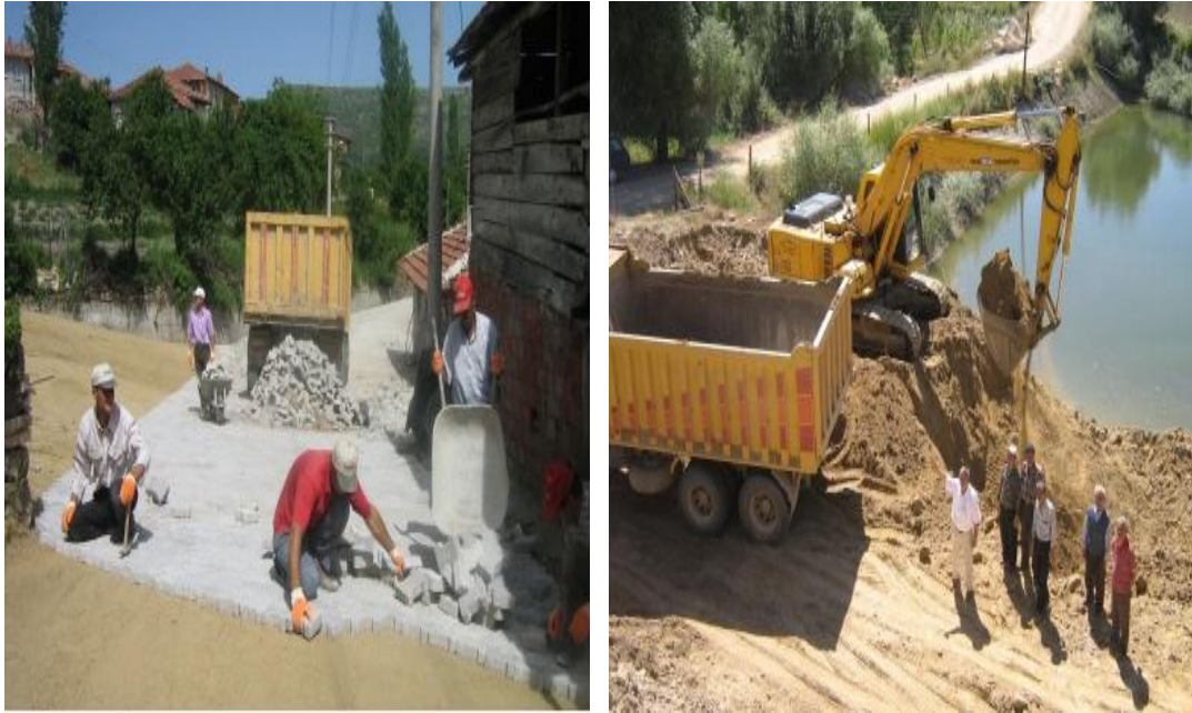
Foto 64: Yüreğil’de alt yapı çalışmaları
