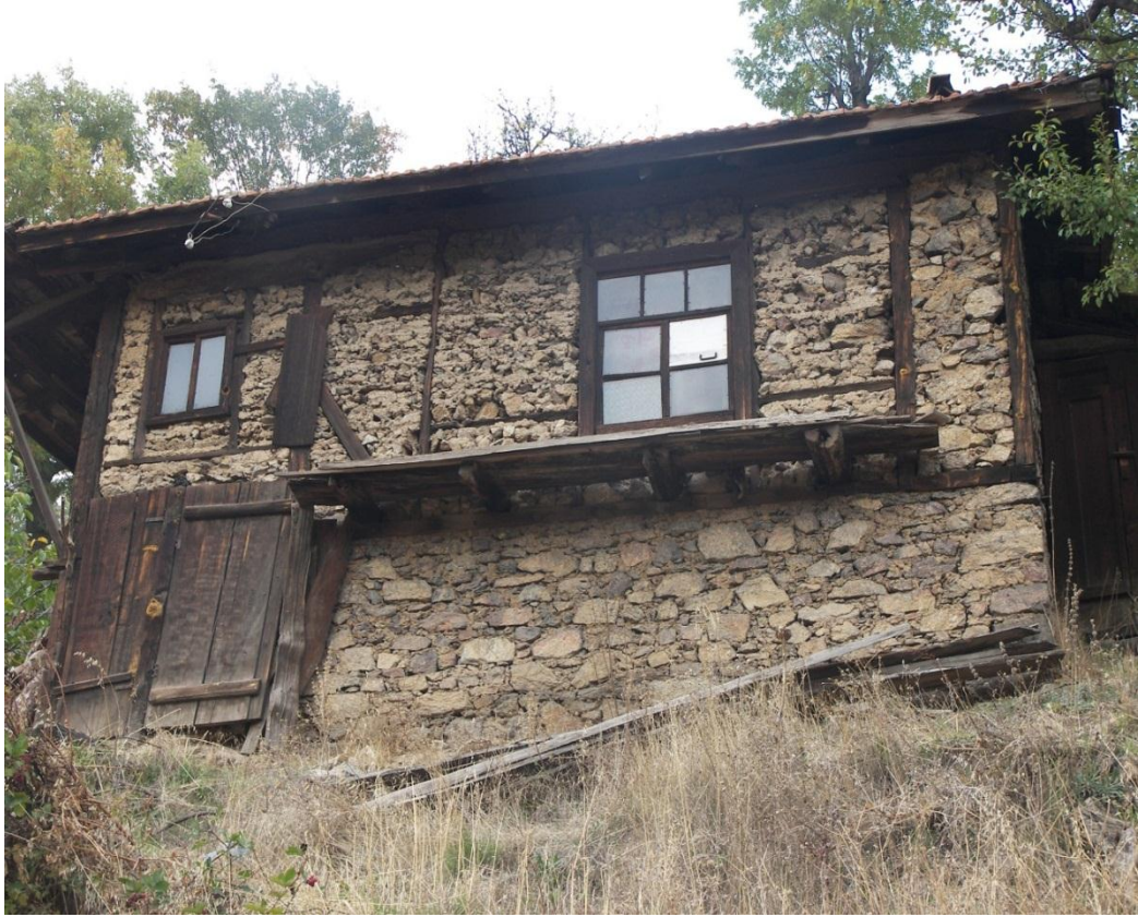
Foto 82: Karkas sistemle yapılmış ve altı depo olarak kullanılan kırsal bir mesken (Bigadiç – Okçularyeri).
