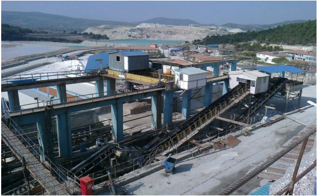
Foto 22: Bigadiç – İskele Etibor Maden İşleme Tesisi
