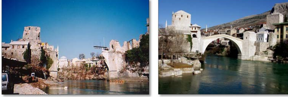
Şekil 3.9 : Tarihi Mostar köprüsünün koruma öncesi ve sonrası (Yapı, 2004).
