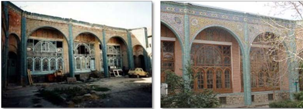
Şekil 4.38 : Urmiye tarihi dokusu, Hidayet Medresesi restorasyon öncesi ve sonrası.
