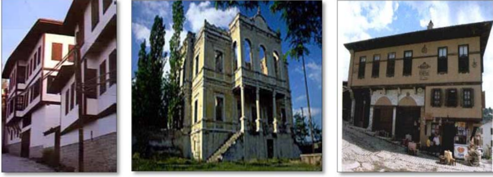
Şekil 3.15 : K lt r bakanlıđınca restore edilen evler ve H k met Konađı ve Kileciler Evi ( www.baglarsaray.com.tr ).
