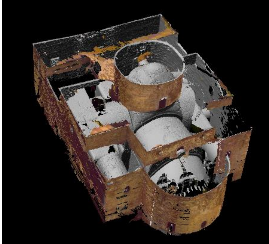
Şekil 4.23. Silles Aya-i Eleni Kilisesinin iç ve dış kısmının birleştirilmiş nokta bulutları
