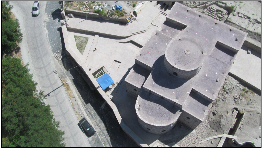
Şekil 4.54. Yer kontrol noktası olarak kullanılacak plakaların kilise üzerine yerleştirilmiş hali
