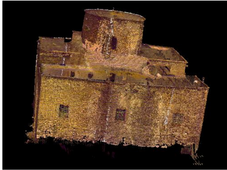
Şekil 4.13. Sille Aya-i Eleni Kilisesinin 3 Boyutlu görüntüsü (Güney-Batı)
