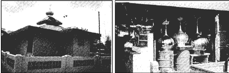
Resim 2.14. Piramit biçimli cami çatılarına eklenen küçük kubbeler [15]
