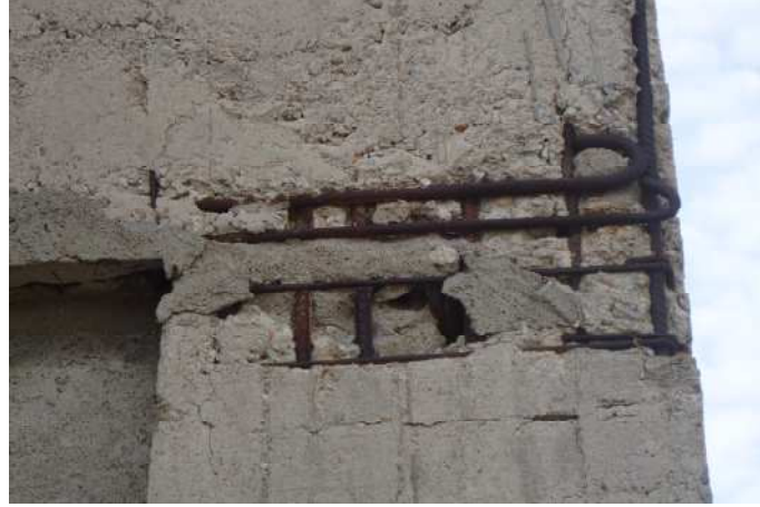
Şekil 4.28. Düşey taşıyıcı elemanlardaki donatı sıklığı.
