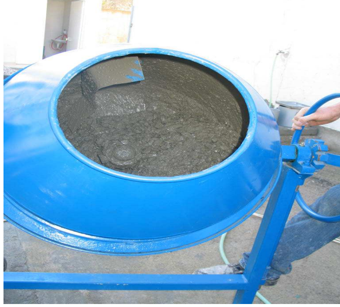
Şekil 4.9. Taze betonun mikserde hazırlanması.
