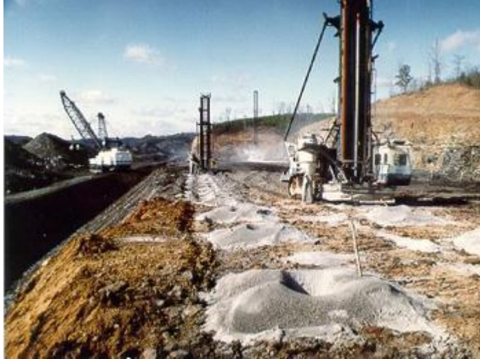
Şekil 2.3: Kanal patlatma çalışması (URL-2, 2012).
