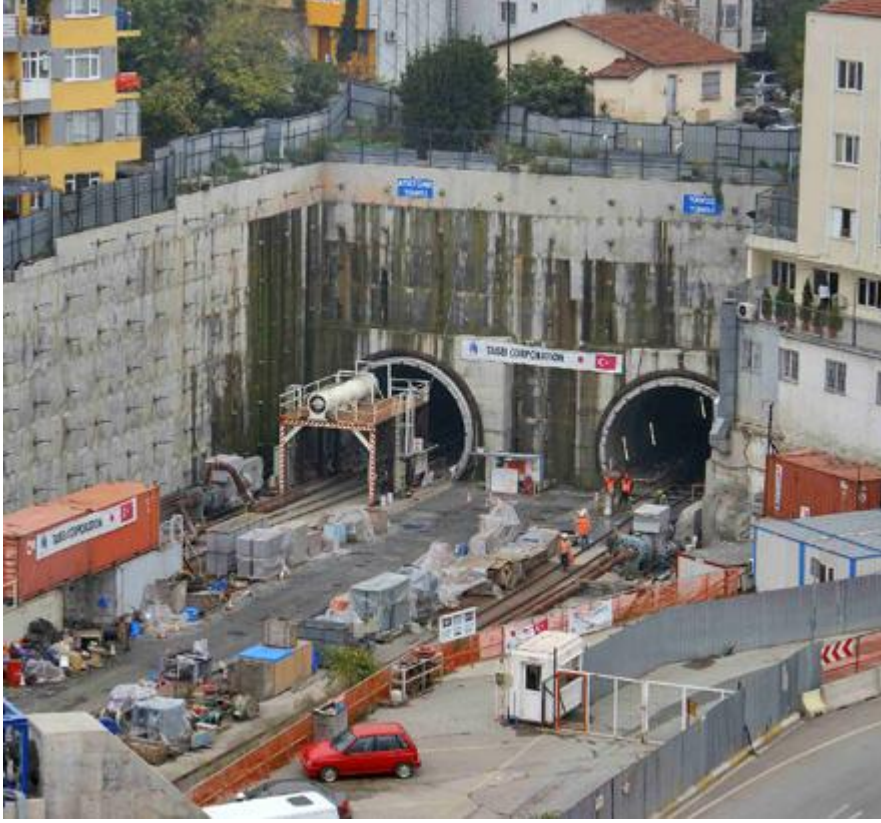
Şekil 2.2: Yer altı patlatma çalışmasının yapıldığı Marmaray Projesi (URL-1, 2012).
