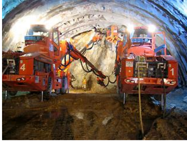
Şekil 1.3. Jumbo aygıtıyla patlayıcıların yerleştirileceği lağım deliklerinin açılış anında bir görünüm
