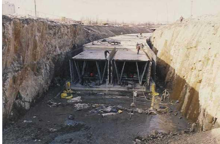
Şekil 1.7. Aç-kapa yöntemiyle inşa edilen bir metro tüneli görünümü
