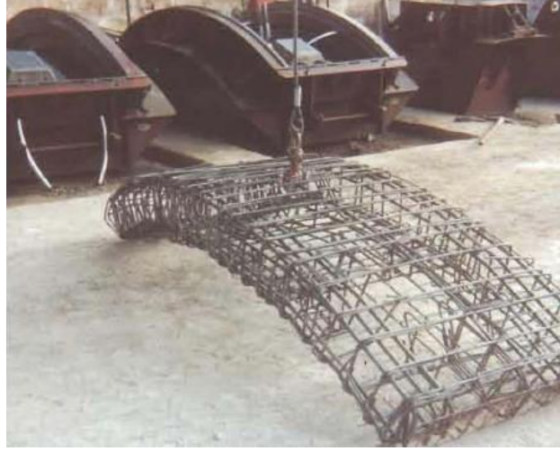
Şekil 1.11. Öndöküm betonarme elemanların donatılarının görünümü
