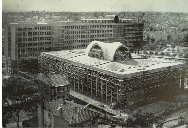
Şekil 4.9 : İstanbul Belediye Sarayı, mimar Nevzat Erol; birbuçuk yıl sonra hizmete girecek olan yapı inşaat halindeyken (İstanbul'un Kitabı, 1957, s.45).
