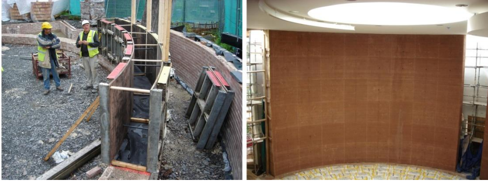
Şekil 3.18 : Rammed-earth tekniği (Url-11).
