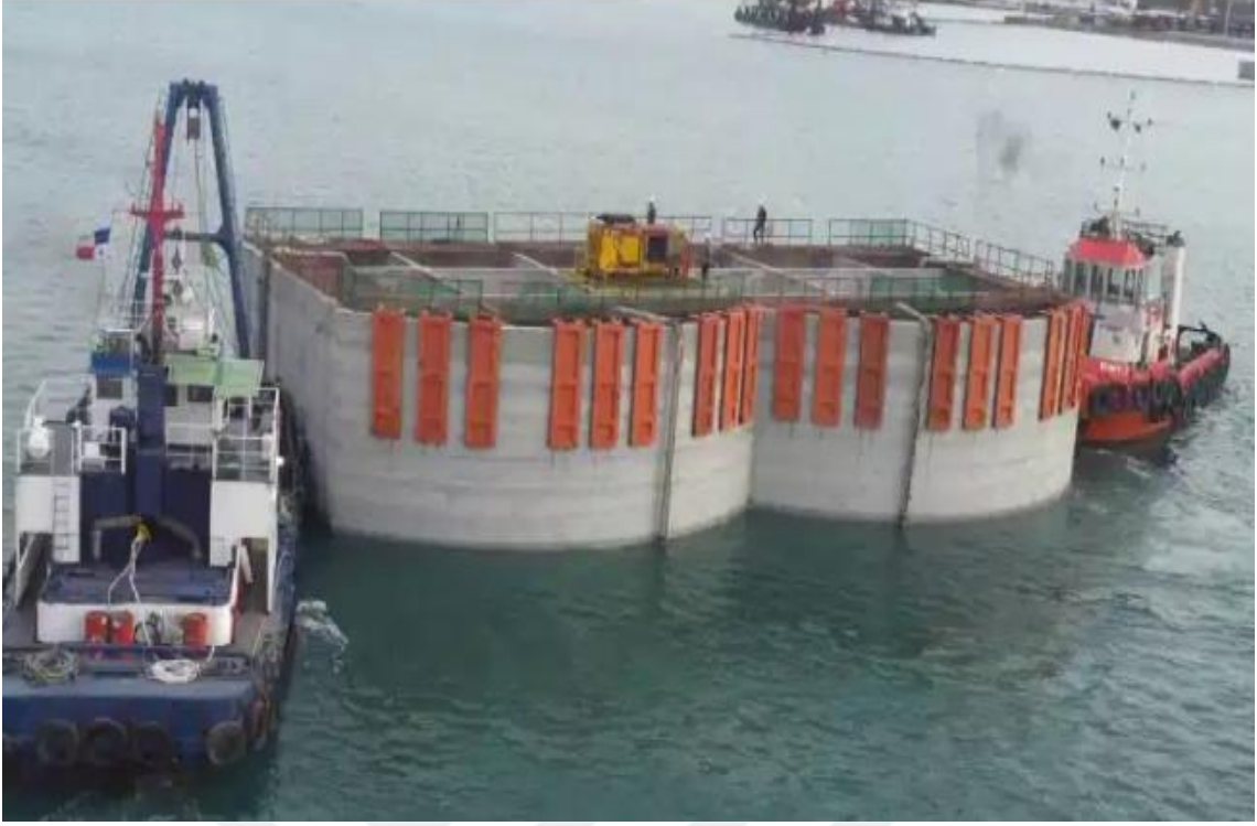
Şekil 2.9 Yüzen keson temel çalışması (URL-4).
