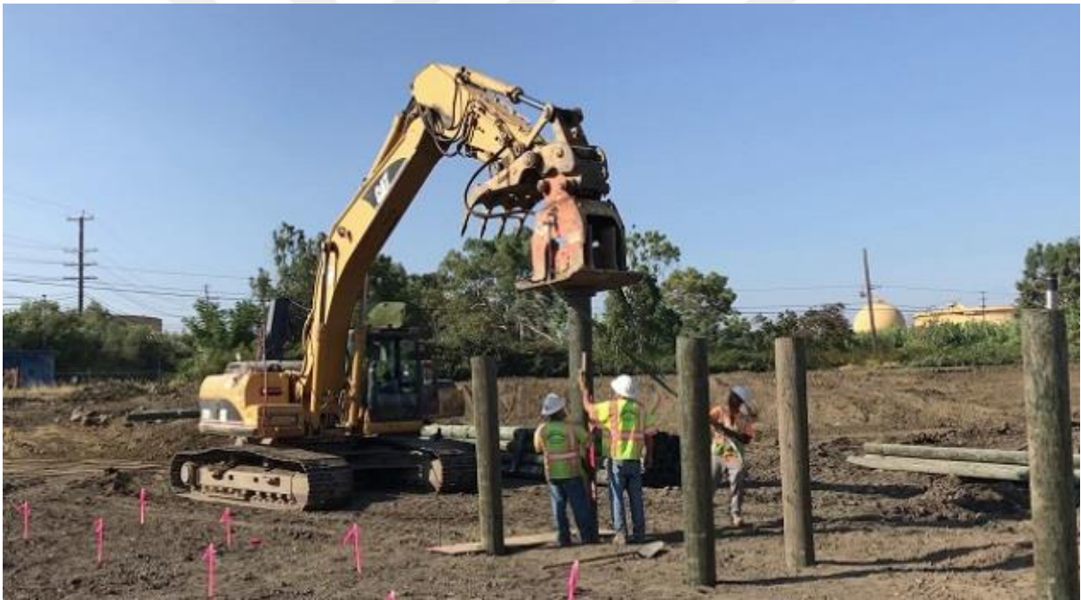
Şekil 2.5 Ahşap çakma kazık uygulama örneği (URL-2 2021).
