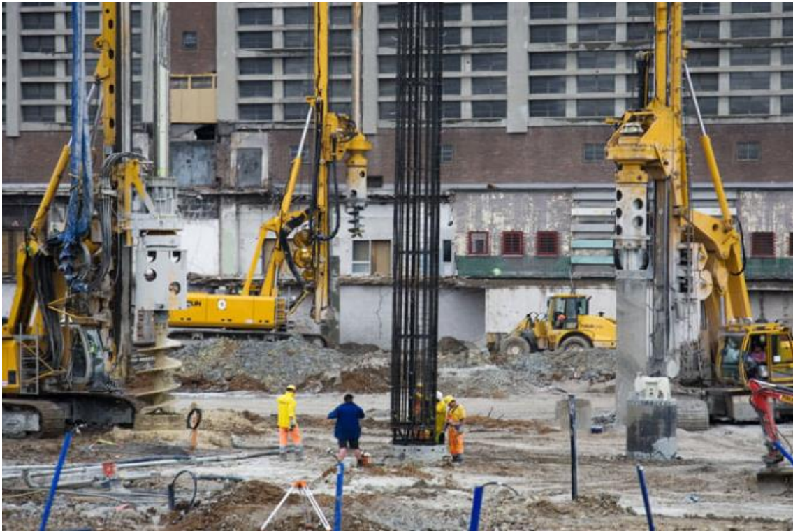
Şekil 2.4 Kazıklara donatı yerleştirilmesi (URL-2).
