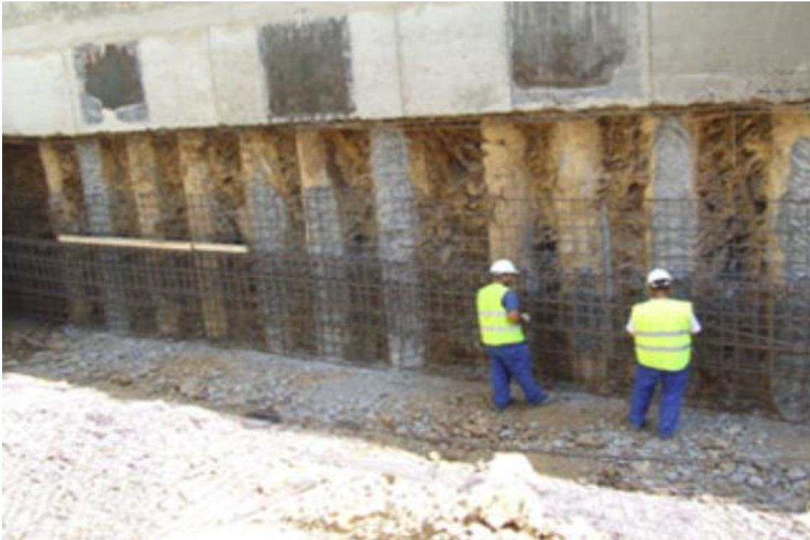
řekil 4.6 Ankrajlı fore kazık uygulaması (URL-7).
