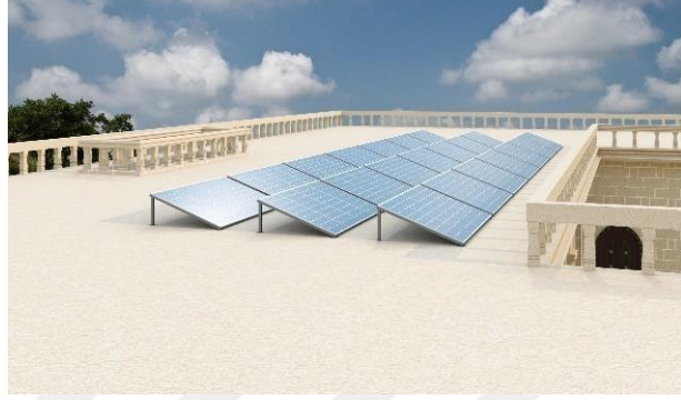
Şekil 108:Yapıda Yer alan PV Panaller
