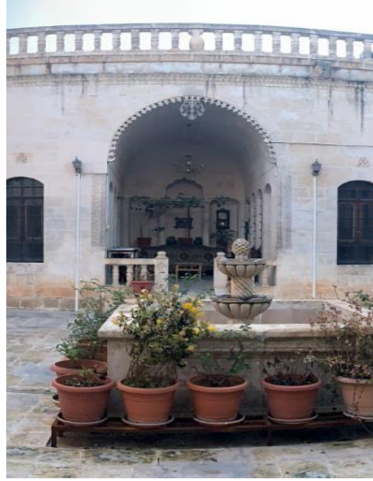
Şekil 76: Demirkol Konağı Eyvan Örneği
