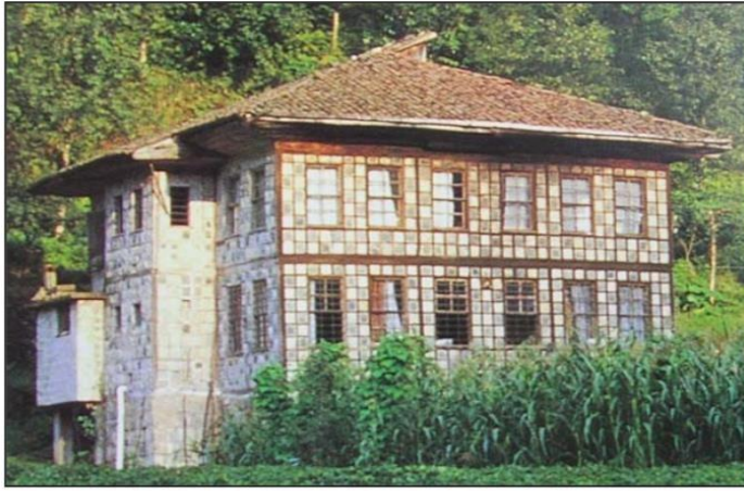
Şekil 18:Rize’ Göz Dolma Uygulanan Yapı Örneği(Aran,2000)
