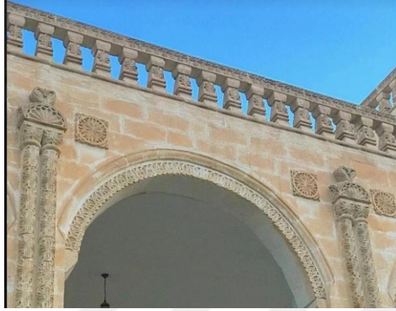
Şekil 78: Yazmacı Konağı Korkuluk Örneği
