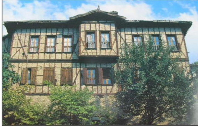
Şekil 17:Şafranbolu’da ki Karkas Yapı Örneği(Küçükerman, Güner,1995)
