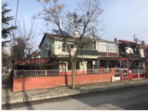
Şekil 5.47. Davraz Evi 2 (Damla Balcı, 2021)
