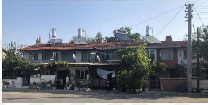
Şekil 5.57. Davraz Evi kapı önü (Damla Balcı, 2021)
