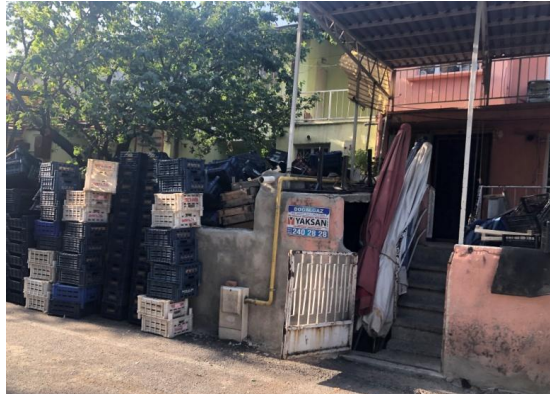
Şekil 5.55. Davraz Evi kapı önü 1 (Damla Balcı, 2021)
