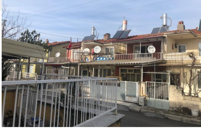
Şekil 5.46. Davraz Evi 1 (Damla Balcı, 2021)
