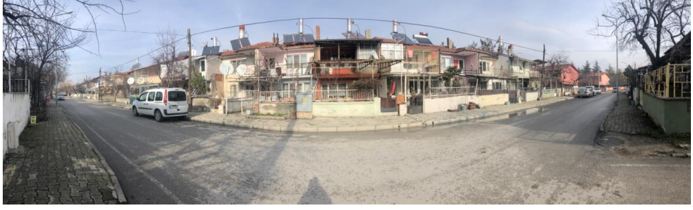
Şekil 5.45. Davraz Evleri görünüm (Damla Balcı, 2021)
