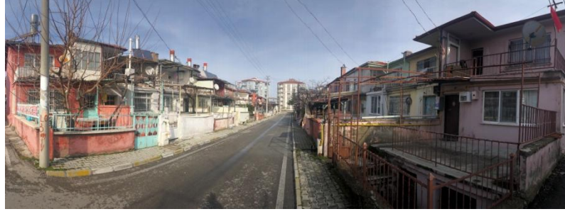
Şekil 5.34. Davraz Evleri ve yeni yapılaşma farkı 2 (Damla Balcı, 2021)
