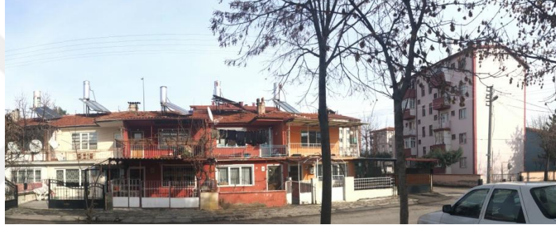
Şekil 5.35. Davraz Evleri ve yeni yapılaşma farkı 3 (Damla Balcı, 2021)
