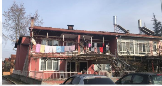
Şekil 5.48. Davraz Evi 3 (Damla Balcı, 2021)
