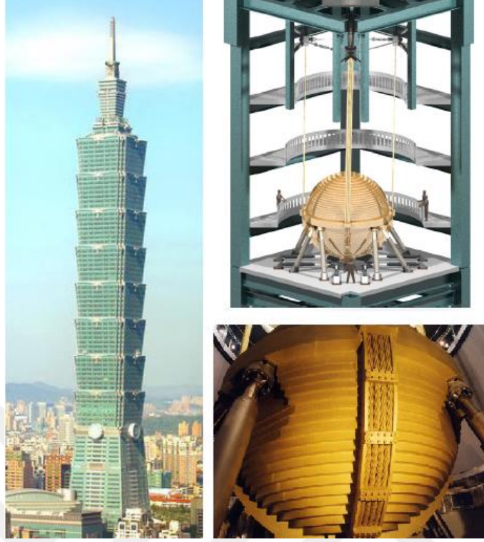
Şekil 2.5: Taipei 101 binası ve kullanılan kütle sönümleyicisi (Bekdaş ve Nigdeli, 2011).
