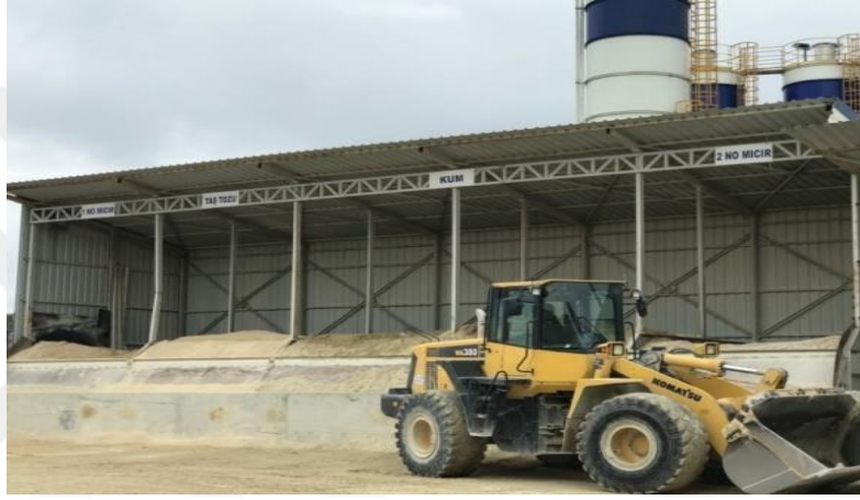
Şekil 2.3: Agregat Stok Sahasındaki Depolama Alanı
