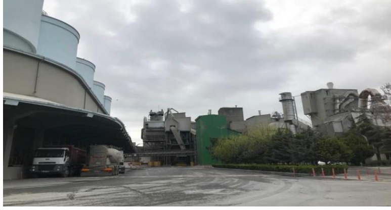
Şekil 2.2: Betonsa Büyükçekmece Teknolojik Merkezi
