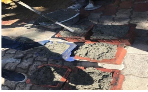
Şekil 5.20: Numune Kalıbının Kalan Kısımında Beton İle Doldurulur Ve Şişleme İşlemi Gerçekleştirilir
