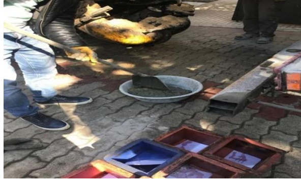
Şekil 5.17: Dökümü Yapılan Taze Beton Harmanı Numune Alımı İçin Başka Bir Yerde Homejen Hale Getirilir
