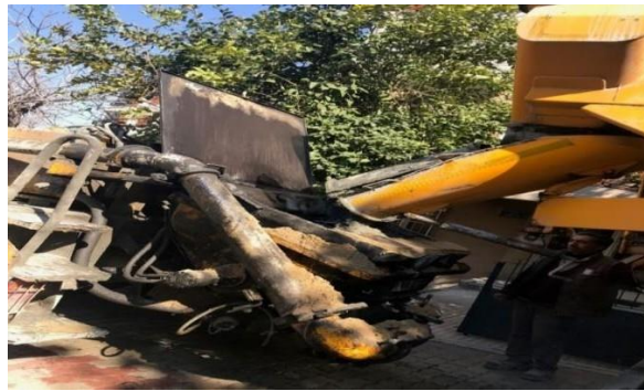
Şekil 5.16: Santrallerde Hazırlanan Taze Beton Harmanı Nakliye Aracıyla Şantiye Alanına Getirilir Ve Döküm Noktasında Transmikserden Boşaltılır
