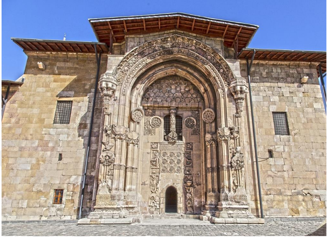
R. 15: Şifahane Taçkapısı
