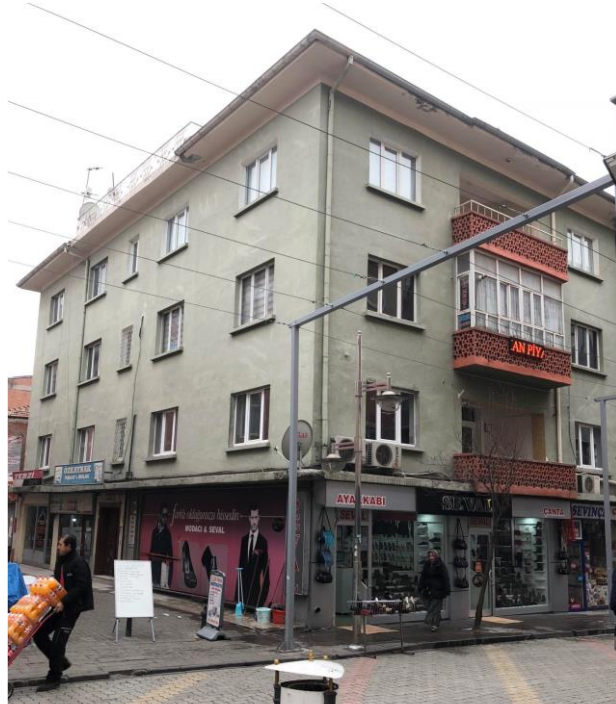
Şekil 2.78: Tapan Apartmanı, Aksaray (Yıldırım, 2018)
