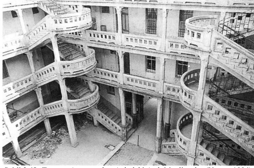
Şekil 2.48: Tayyare Apartmanları Avludaki Açık Merdivenler (Yavuz, 1994)
