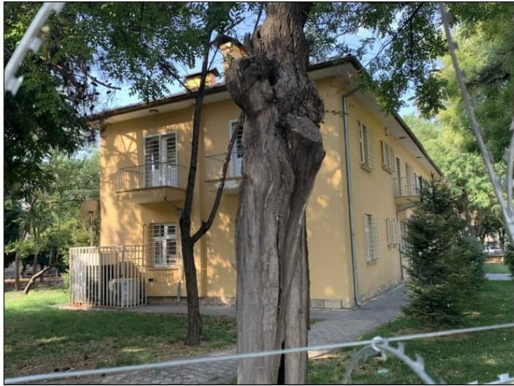
İstasyon Evleri 5787 Ada 1 Parsel (A Blok) (Foto: Erbalcı, 2021)
