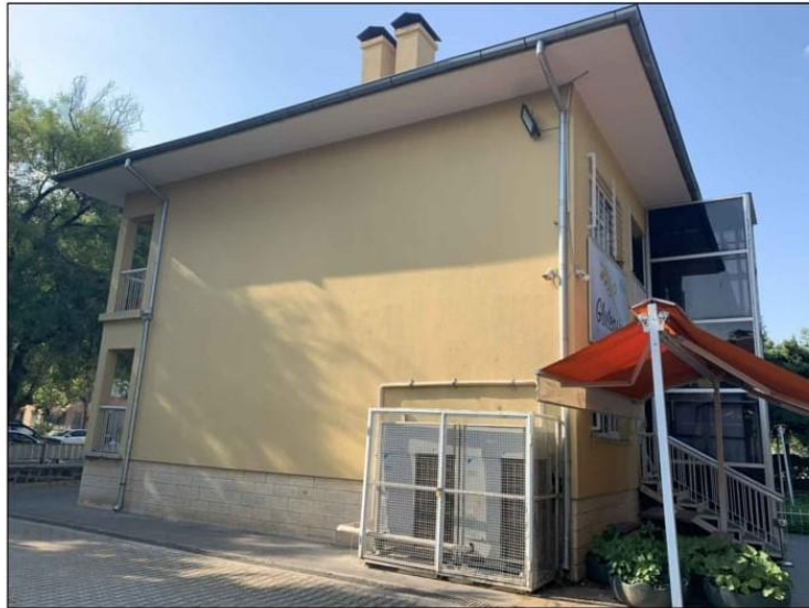
İstasyon Evleri 5792 Ada 3 Parsel (C Blok) (Foto: Erbalcı, 2021)
