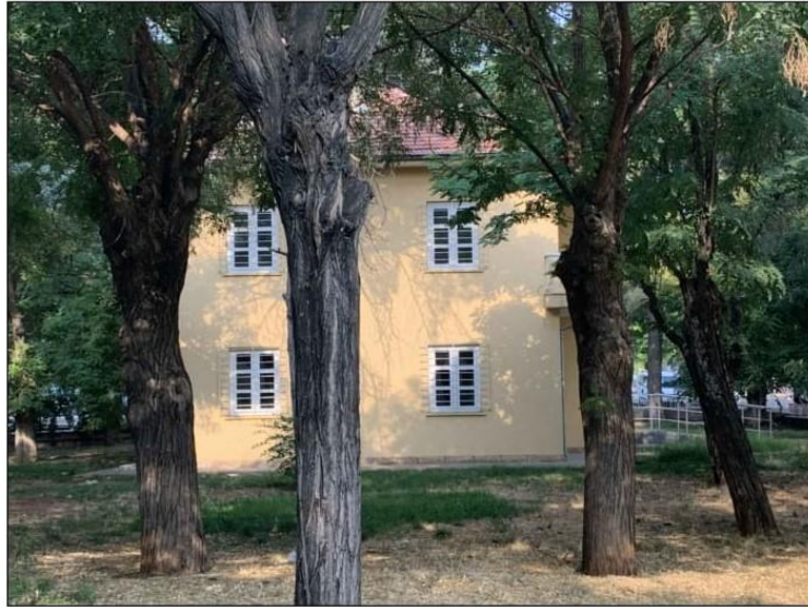
İstasyon Evleri 5792 Ada 3 Parsel (A Blok) (Foto: Erbalcı, 2021)
