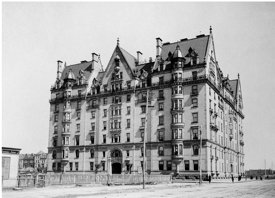
Şekil 2.10: Dakota Apartman Binası, Amerika (URL-3)
