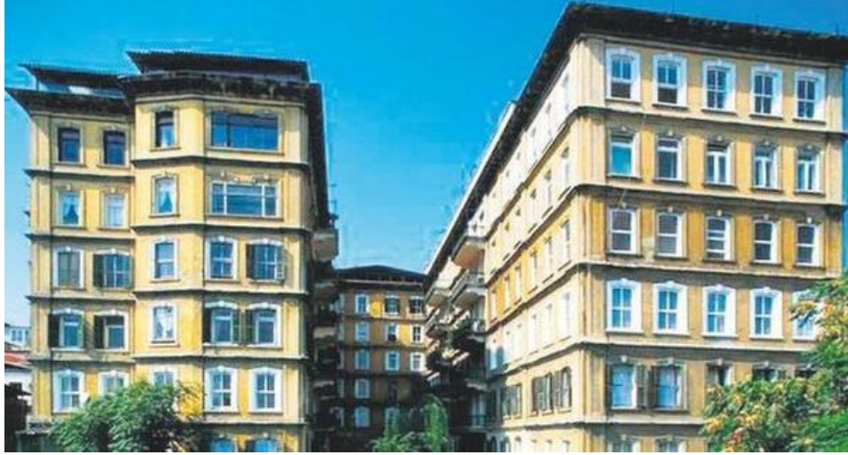
Şekil 2.34: Naib Bey Apartmanı Günümüz (URL-16)
