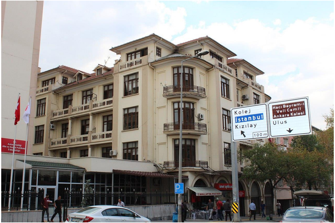
Şekil 2.61: Çocuk Esirgeme Kurumu Kira Apartmanı Günümüz (URL-27)
