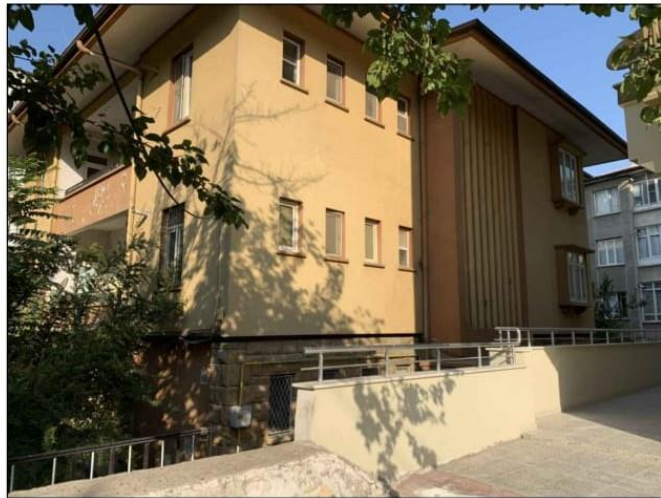
Bahçelievlerde Bulunan Bir Apartman Örneği (Foto: Erbalcı, 2021)
