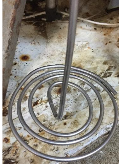
Şekil 3.2 Havalandırma için kullanılan difüzör
