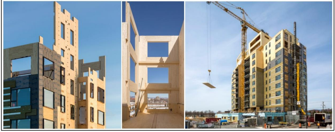
Resim 4-9: Origine, Yapım Aşaması (Cecobois, 2018).
