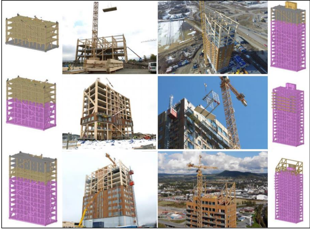
Şekil 4-18: Mjøstårnet Yapım Aşamaları (Abrahamsen, 2018).
