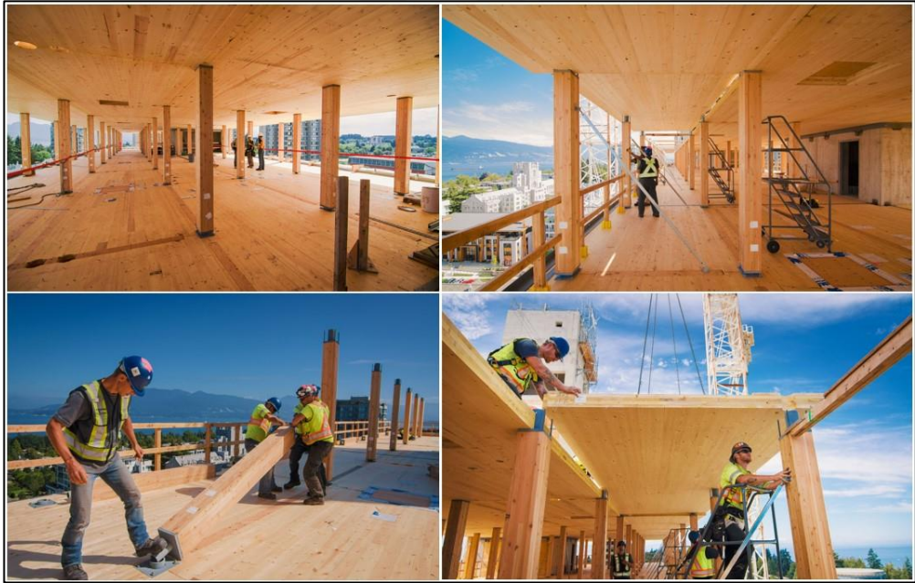
Resim 4-13: Brock Commons, CLT Döşeme ve Glulam-PSL Kolonlar (Url- 49).
