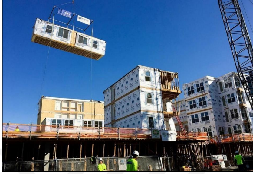
Resim 2-6: Şantiye Sahasında Bir Modülün İstiflenmesi (Littman, 2017).
