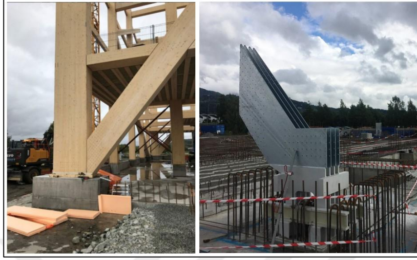
Resim 4-22: Mjøstårnet Yapısı Çelik Bağlantıları (Url- 45), (Url- 46).
