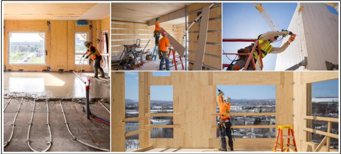
Resim 4-10: Isıtma, elektrik ve tesisat bağlantıları montajları (Cecobois, 2018).
