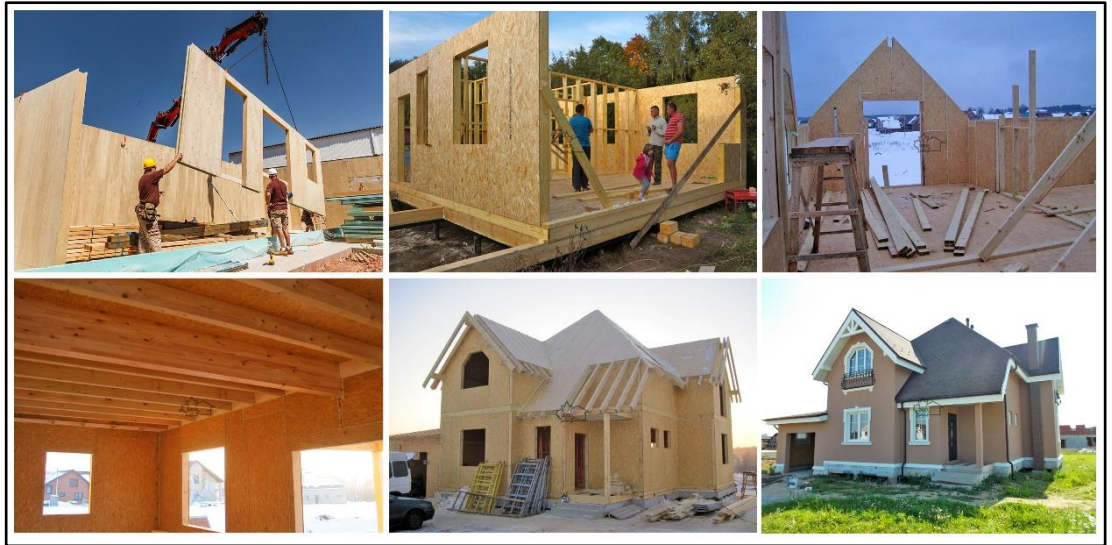
Resim 2-4: Ahşap Panel Sistem Yapımı Örneği (Url- 6).
