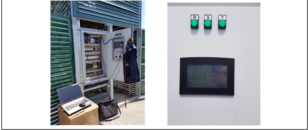
Şekil 4.2: Gazlaştırma reaktörü PLC sistemi.
