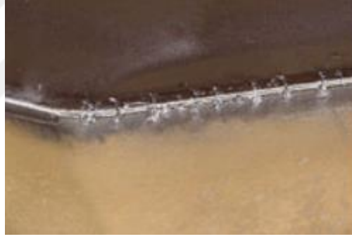
Şekil 2.25. Termal çatlaklar (Anonim 1990b)
