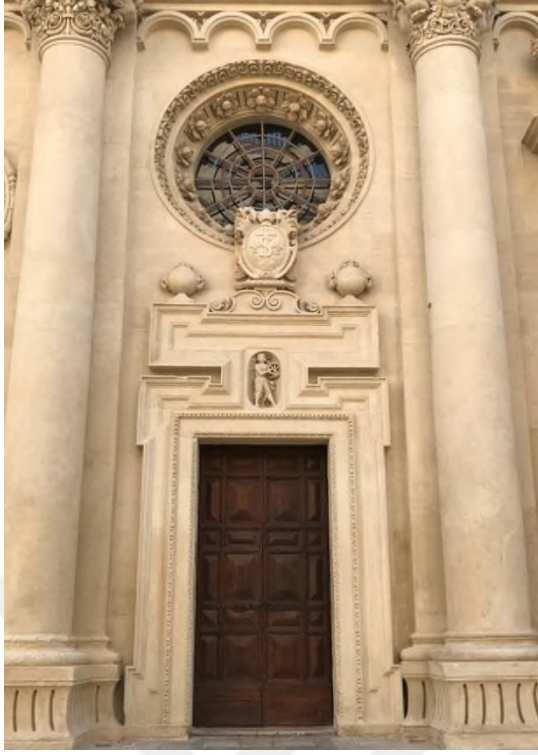
Şekil 7.19. Basilica di Santa Croce ( Kutsal Haç Bazilikası), Eksenin Kuzeyindeki Portal.
