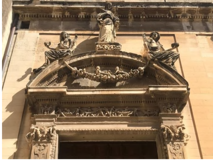
Şekil 7.132. Duomo di Lecce (Lecce Katedrali), Güney Cephe, Portal Detayı.
