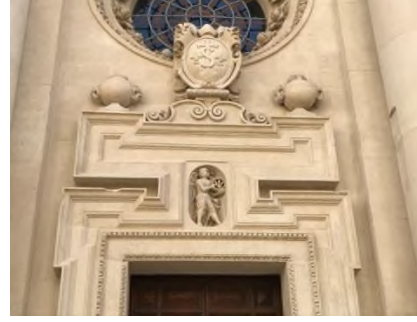
Şekil 7.20. Basilica di Santa Croce ( Kutsal Haç Bazilikası), Sol Kanat, Portal Detayı.
