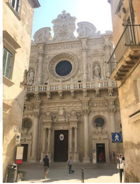
Şekil 7.7. Basilica di Santa Croce ( Kutsal Haç Bazilikası), Batı Cephe.
