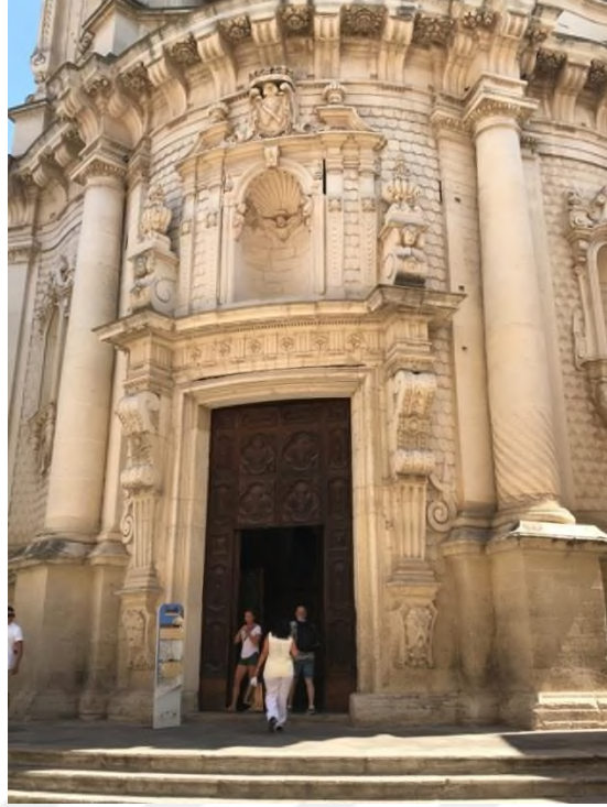
Şekil 7.205. Chiesa di San Matteo (Aziz Matta Kilisesi), Batı Cephe, Portal.
