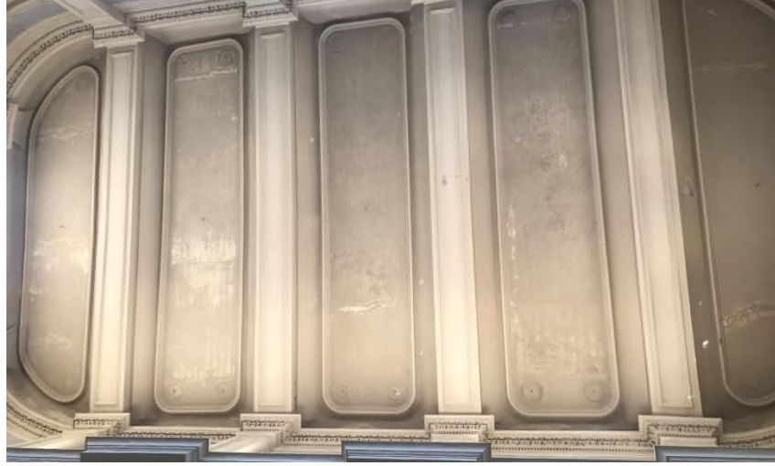
Şekil 7.227. Chiesa di San Matteo (Aziz Matta Kilisesi), Tavan Örtüsü.
