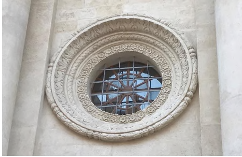
Şekil 7.22. Basilica di Santa Croce ( Kutsal Haç Bazilikası), Batı Cephe, Gül Pencere.
