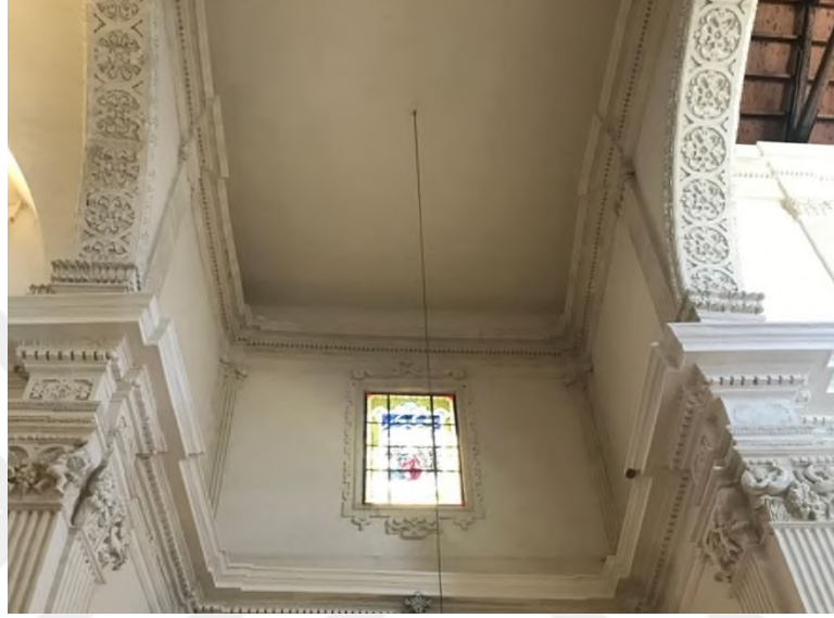
Şekil 7.177. Chiesa di Sant'Angelo o di Santa Maria di Costantinopoli (Aziz Angelo ya da İstanbul'un Kutsal Meryem'i Kilisesi), Güney Transept Kolu Pencere ve Tavanı.
