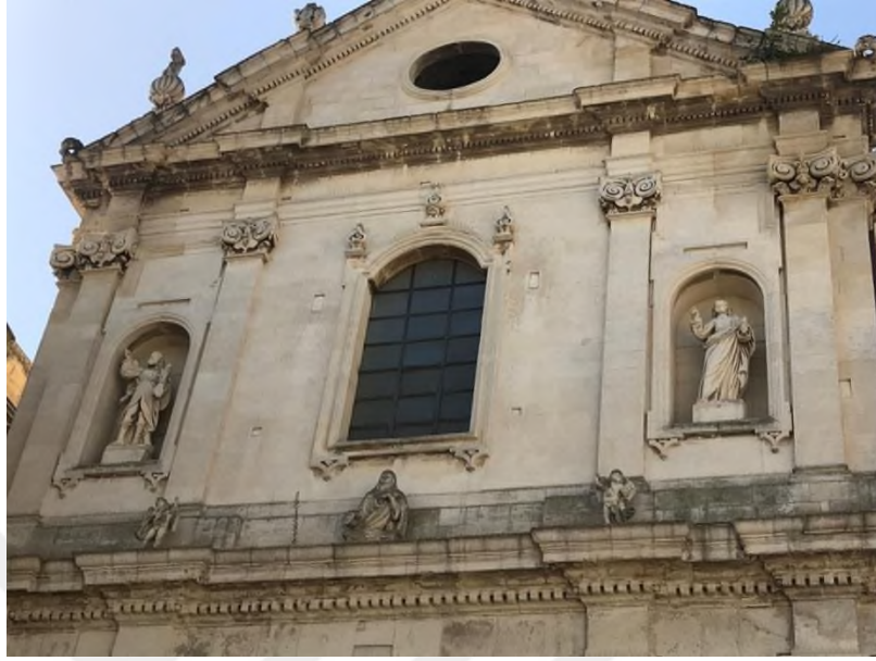
Şekil 7.250. Chiesa di Sant'Anna (Azize Anna Kilisesi), Batı Cephe, İkinci Kat.
