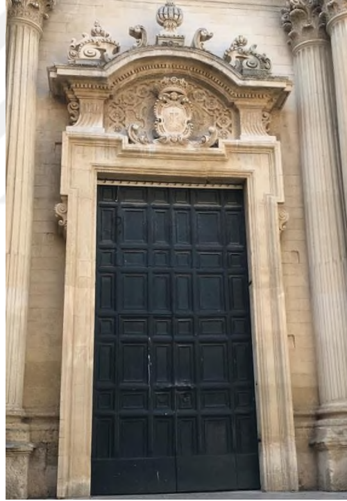
Şekil 7.78. Chiesa Di Santa Teresa (Azize Teresa Kilisesi), Batı Cephe, Portal.
