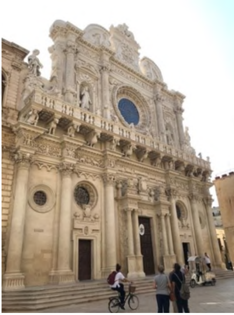
Şekil 7.6. Basilica di Santa Croce ( Kutsal Haç Bazilikası), Batı Cephe.
