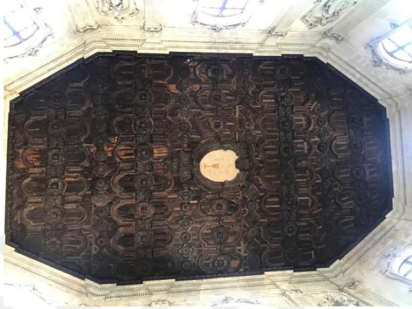
Şekil 7.252. Chiesa di Santa Chiara (Azize Chiara Kilisesi), İç Mekân Tavan Örtüsü.
