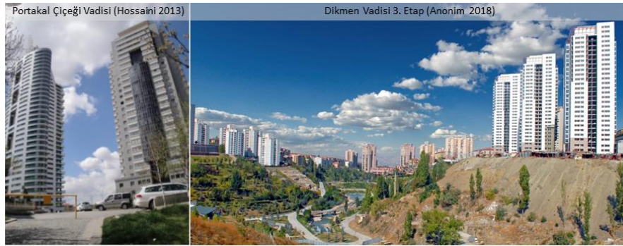
Şekil 4.6 Portakal Çiçeği Vadisi ve Dikmen Vadisi’ndeki Kentsel Dönüşüm Uygulamaları
