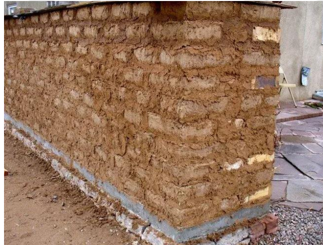
Resim 2. 34: Kerpiç bloklarla oluşturulmuş duvar (URL 44).
