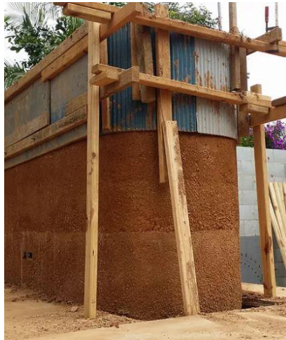
Resim 2. 28: Dökme toprak tekniği yapılış aşaması (URL 39).
