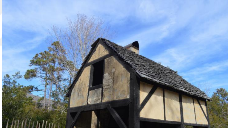
Resim 2. 20: Omurgalı kerpiç tekniğiyle yapılmış bir yapı (URL 29).
