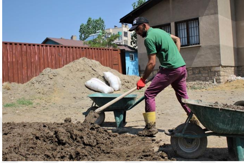
Resim 2. 1: Kerpiç harcının kol kuvvetiyle karıştırılması (URL 15).
