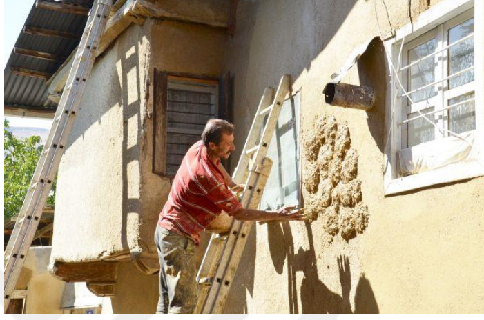
Resim 2. 35: Kerpiç yapıda duvara sıva çekme işlemi (URL 45).
