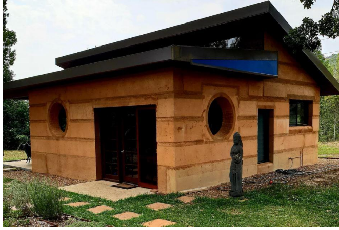
Resim 2. 29: Dökme toprak tekniği ile inşa edilmiş bir ev (URL 39).
