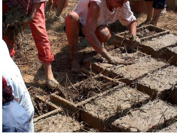
Resim 2. 32: Samanın kerpiç harcında kullanılması (URL 42).
