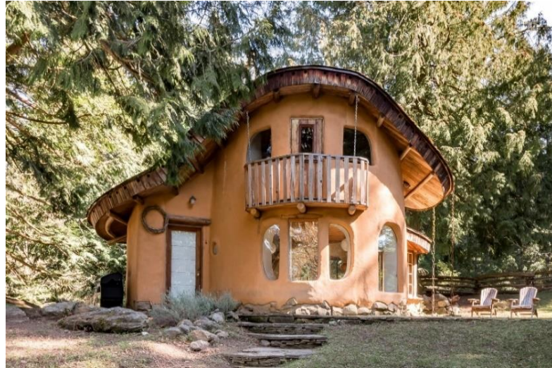
Resim 2. 26: Dökme toprak tekniđiyle inřa edilmiř bir ev(İngiltere) (URL 37).
