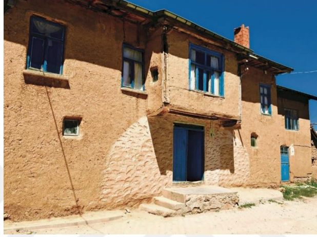
Resim 2. 16: Bezeli yığma kerpiç yapı (URL 25).
