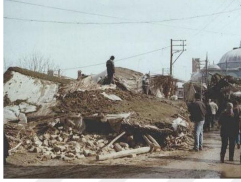
Resim 4. 3: Konya'da kerpiç malzemeli, ağır toprak damlı yapının yıkıntısı (Koçu ve Korkmaz, 2004).
