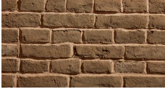
Resim 2. 33: Kerpiç tuğlaların oluşturduğu bir duvar görüntüsü (URL 43).
