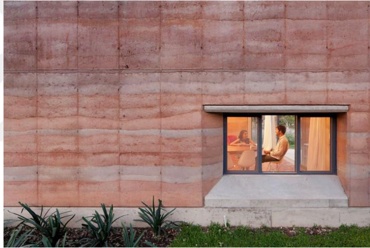
Resim 2. 24: Dövme duvar tekniğiyle yapılmış bir yapının duvarı (URL 35).
