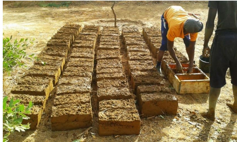
Resim 2. 2: Kerpicein kalıplara dökülüp sıkıştırılması (URL 16).
