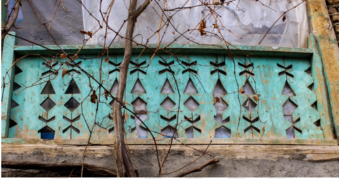
Şekil 4.51 : Geleneksel açık çıkmalı bir yapıda olan ahşap korkuluk örneği (E-27).
