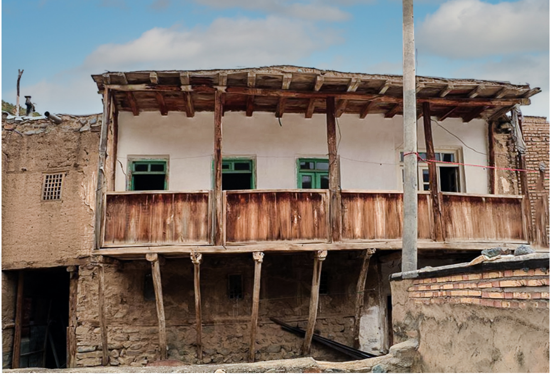
Şekil 4.56 : Baba Kishi Zadeh evinin güney cephesi (E-22).
