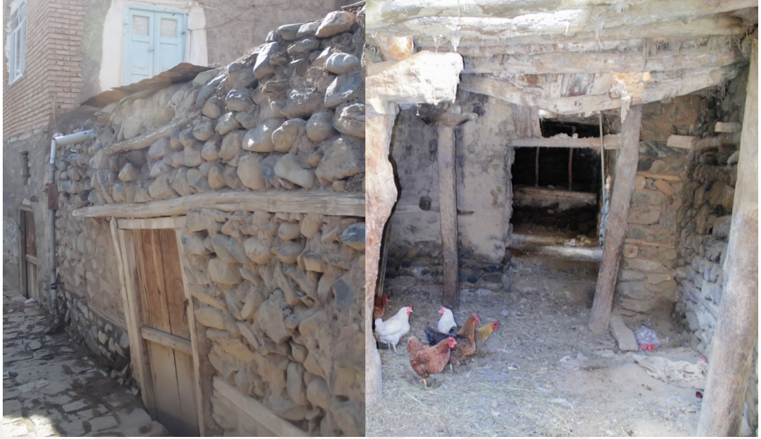
Şekil 4.28: Yerleşimdeki konutlardan bağımsız ahır ve depo örnekleri
