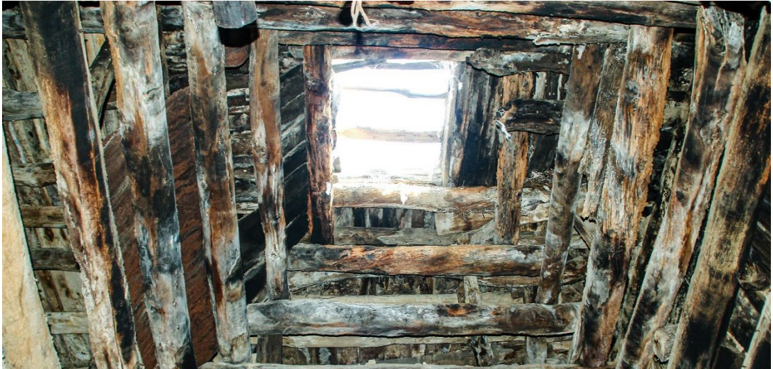
Şekil 4.26 : Buneğe yapısının dumanlık baca ve tavan detayı (E-11).
