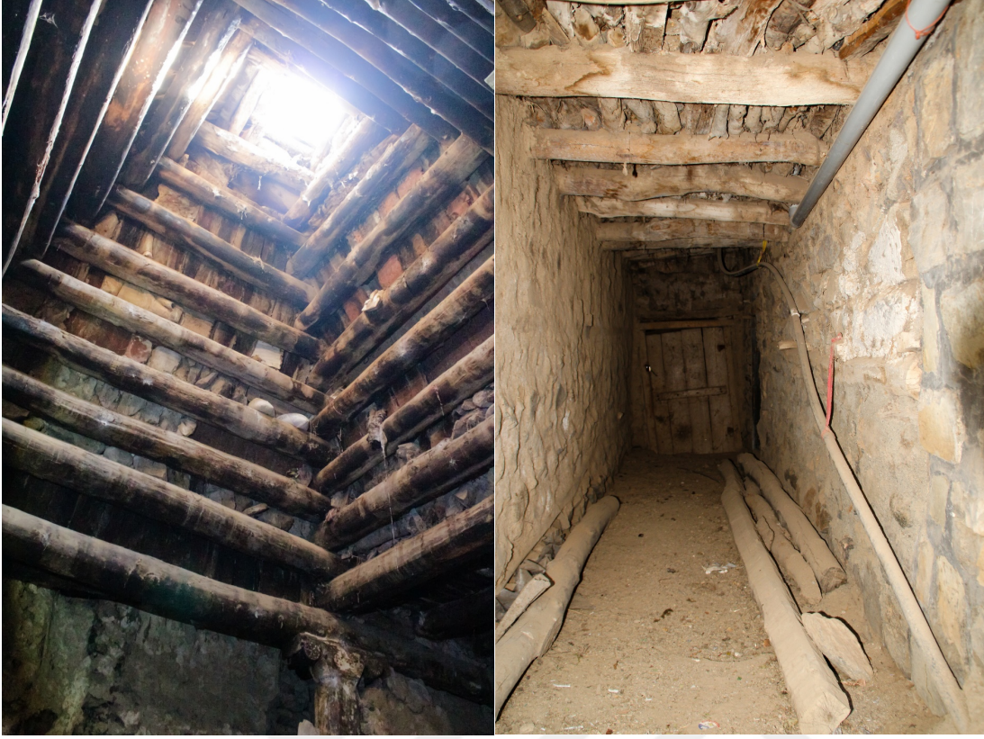
Şekil 4.66 : Anbar Nabatı Buneğe yapısının piramit kubbesi ve kabaltı üzerinden girişi (E-32).
