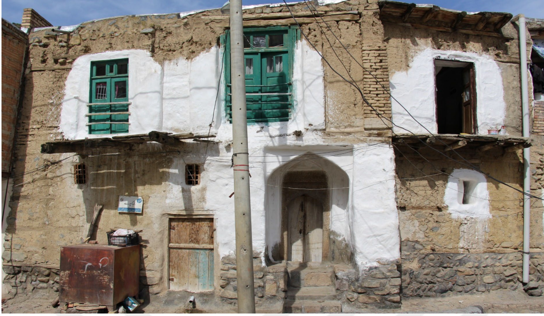
Şekil 4.59 : Yelesimdeki Sorkhayı evinin güney cephesi (E-13).
