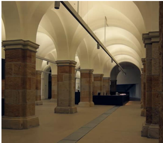
Şekil 60: Cephanelik yapısı zemin kat iç görünüm
