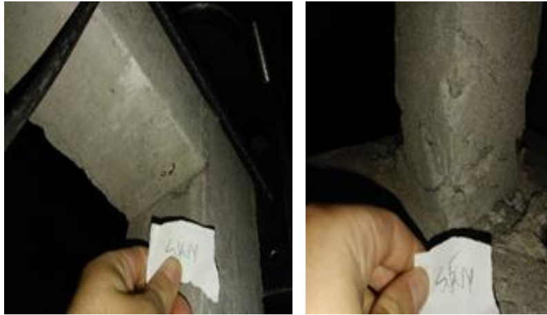
Şekil 3.37. Duvarsız çerçeve 45kN yüklemesinde hasarlar
