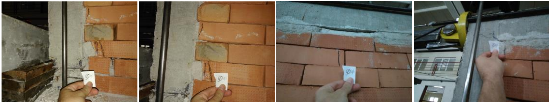
Şekil 3.30. Harçsız duvarlı harçlı birleşimli çerçevede 50kN’da oluşan hasarlar
