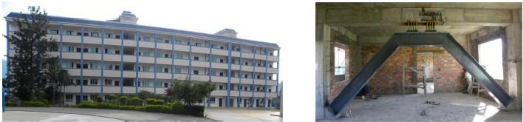
Şekil 1.2. Metalik akmaya dayalı sönümleyicinin uygulanması [4]
