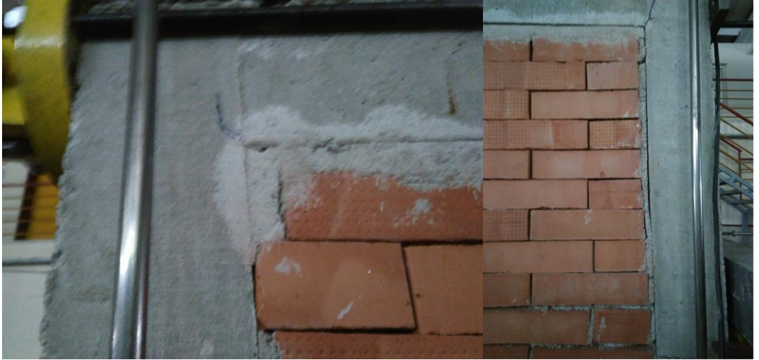
Şekil 3.28. Harçsız duvarlı harçlı birleşimli çerçevede 40kN’da oluşan çatlaklar
