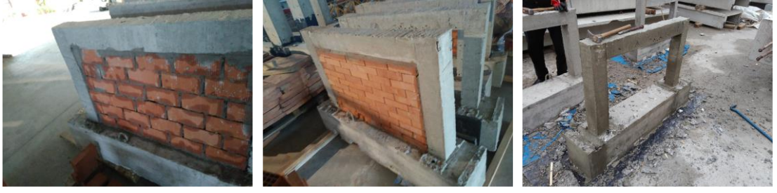
Şekil 3.25. İmalatı tamamlanmış ve duvar örülmüş çerçeveler
