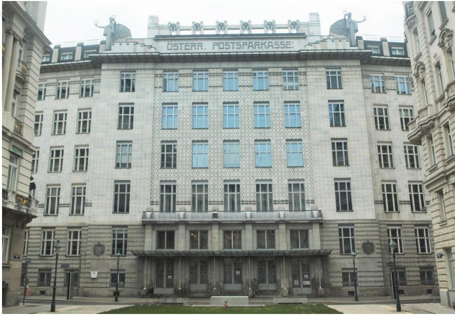
Resim 23. Postsparkasse Doğu Cephesi (Rabia Temel, 2019)
