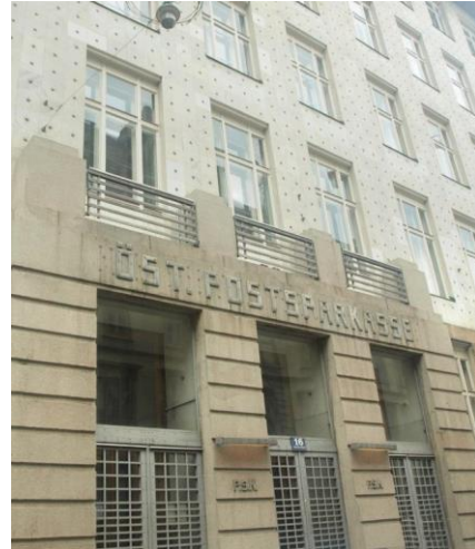
Resim 39. Batı Cephesi Giriş Bölümü (Rabia Temel, 2019)
