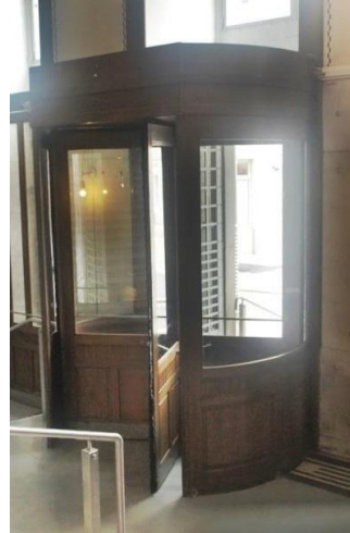
Resim 56. Giriş Bölümü Döner Kapı a) Dış Kapıdan Görünüş b) Dış Gövde Ayrıntı c) Holden Görünüş (Rabia Temel, 2019)
