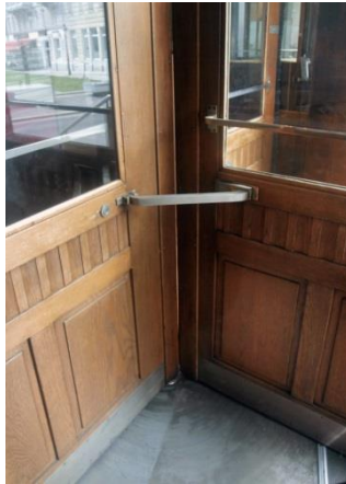
Resim 57. Giriş Bölümü Döner Kapı a) Kapı Kanat Ayrıntısı b) Kapı Kanatları Birleşim Ayrıntısı c) Kapı Üst Kapaması (Rabia Temel, 2019)
