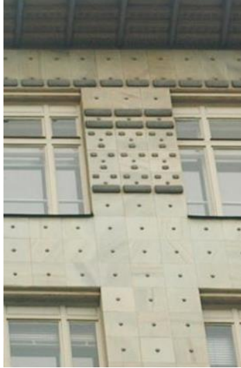
Resim 35. Dördüncü Kat Cephe Ayrıntı (Rabia Temel, 2019)
