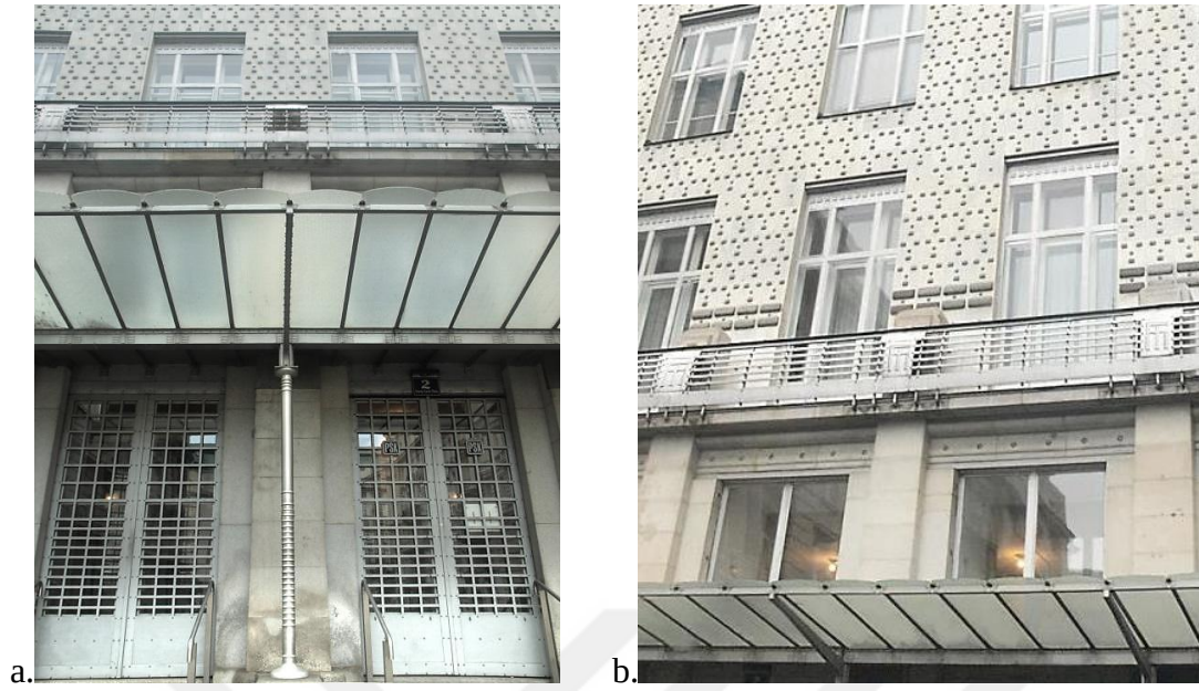
Resim 27. Doğu Cephesi a) Cam Saçak Ayrıntısı b) Alüminyum Korkuluk Ayrıntısı (Rabia Temel, 2019)
