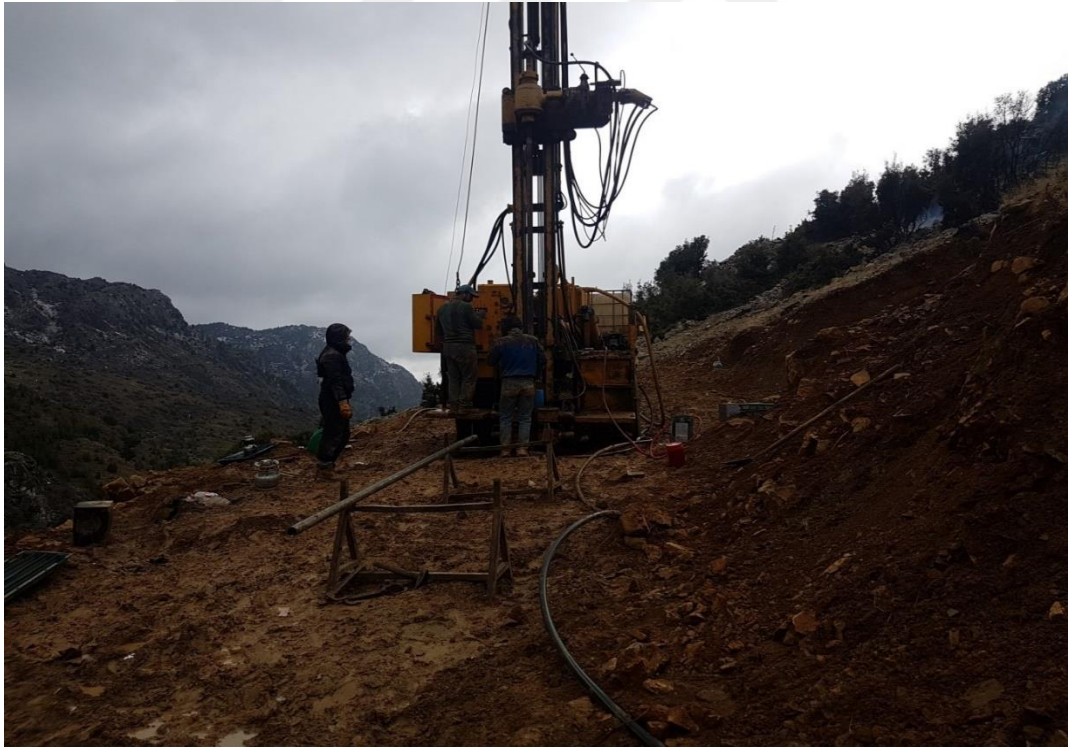
Şekil 4.2. Sk-1 nolu kuyu (sağ sahil) sondaj çalışması
