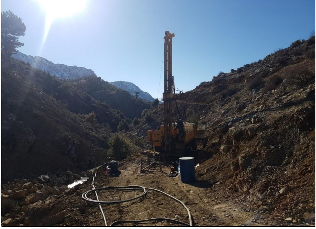
Şekil 4.4. Sk-3 nolu (talveg) sondaj kuyusundan bir görünüm
