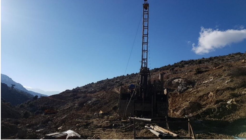
Şekil 3.1. Karotlu Sondaj Çalışması
