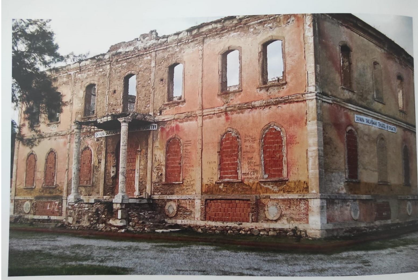
EK-82: Aydın 1. Jandarma Eğitim Komutanlığı Arazisinde Metruk Halde Bulunan Redif Deposu 380
