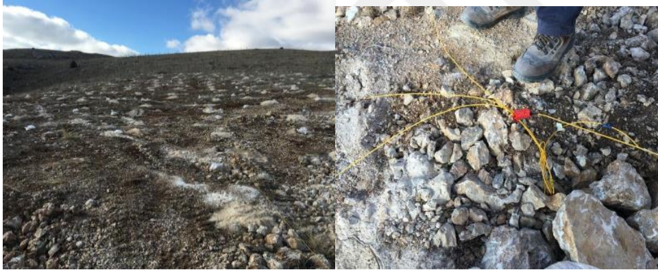
Şekil 4. Patlatma Delikleri ve Ateşleme Kabloları
