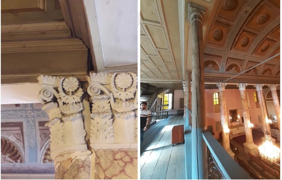
Şekil 5.9 : Naos başlangıcında galeri katının oturduğu sütun ve narteks sütunu hasarı.
