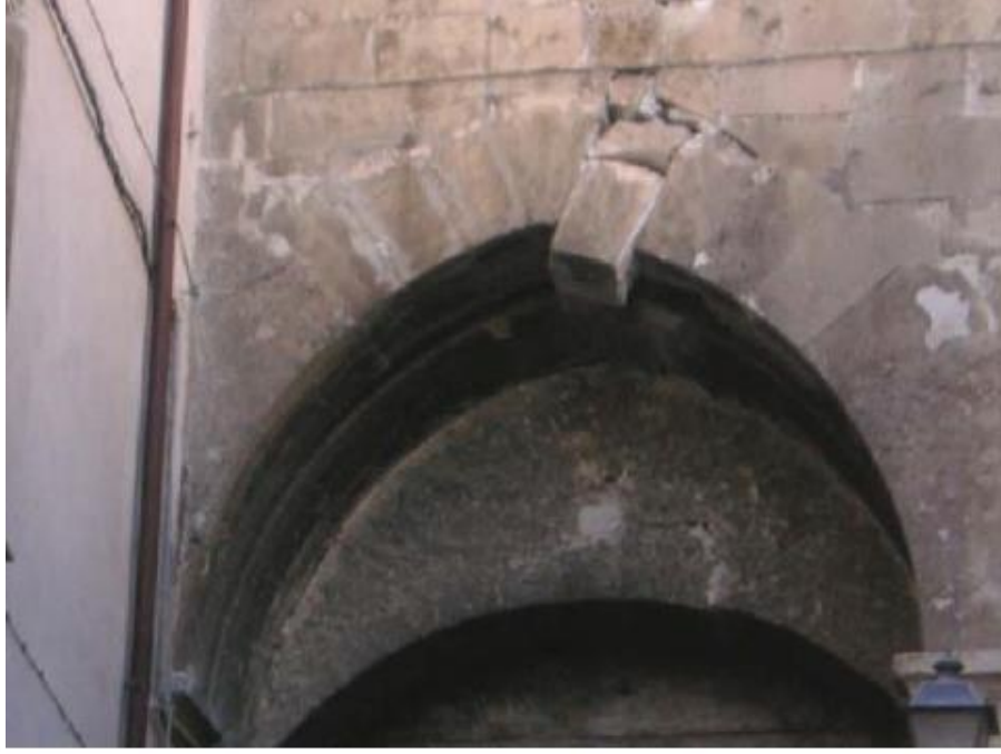
Şekil 3.3 : Kemer hasarı (Castelvecchio Subequo, İtalya) (Indirli ve diğ., 2013).
