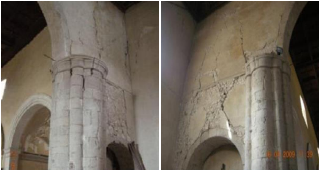
Şekil 3.16 : Zafer takı hasarları (Brandonisio ve diğ., 2013).
