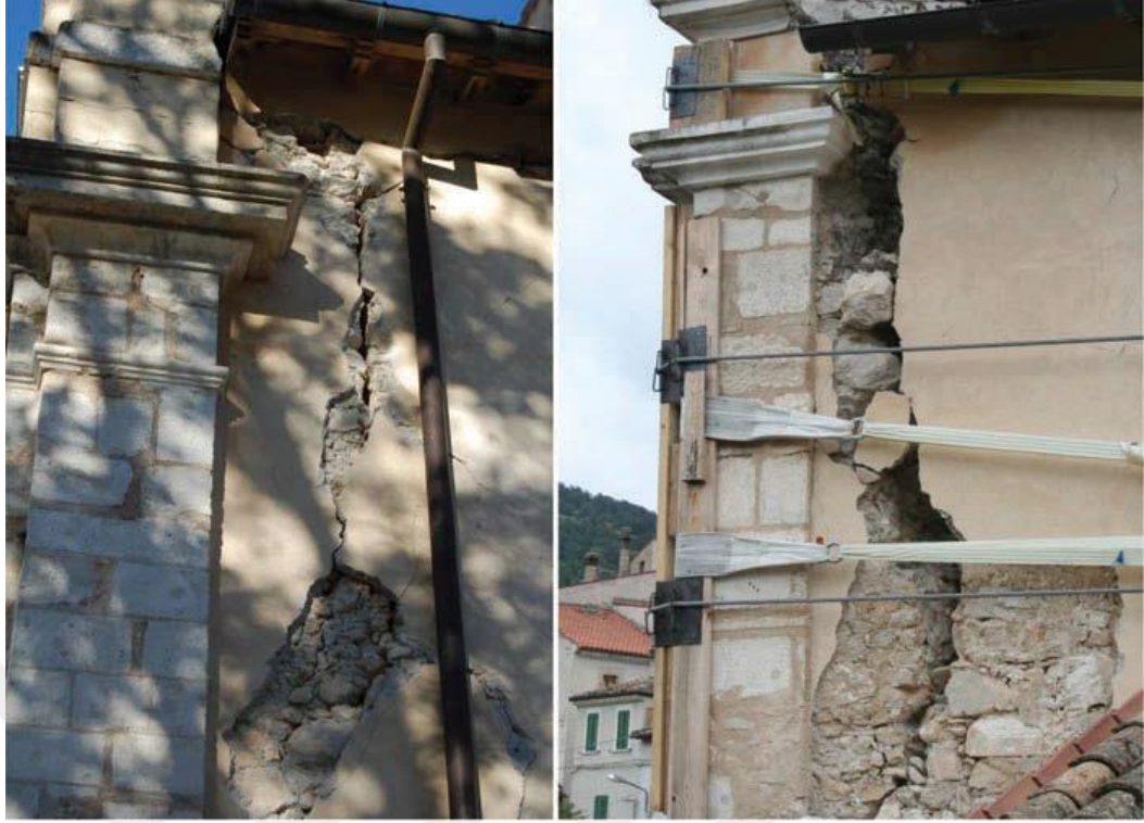
Şekil 3.12 : Cephe ayrılması – St. Gemma Kilisesi, Goriano Sicoli (De Matteis ve diğ., 2016).
