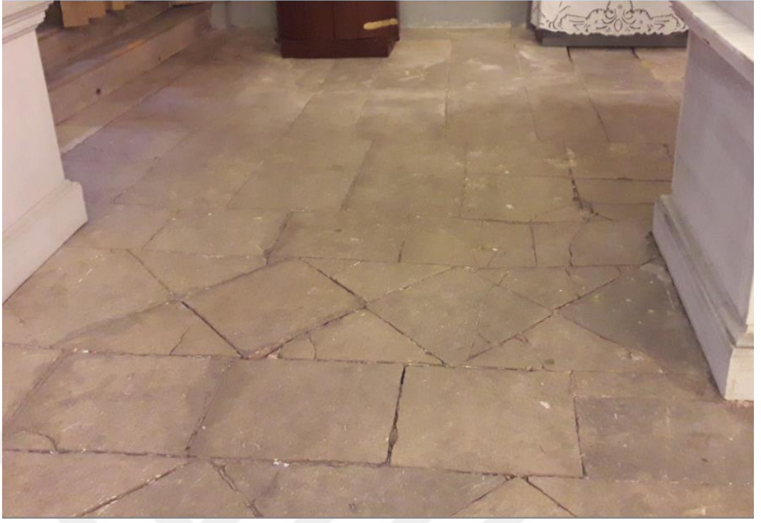
Şekil 5.8 : Zemin oturması.
