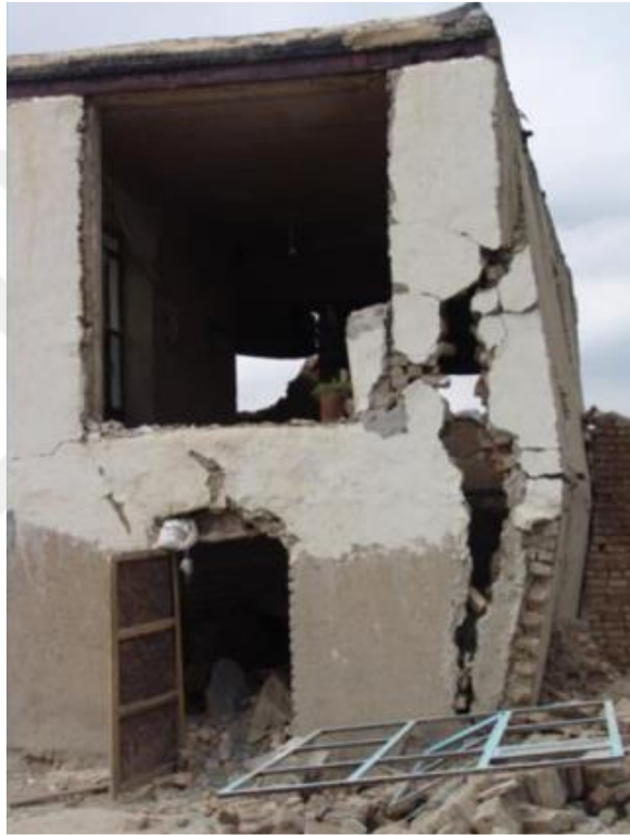
Şekil 3.5 : Düzlem dışı yüklerin oluşturduğu devrilme (Arun, 2005).
