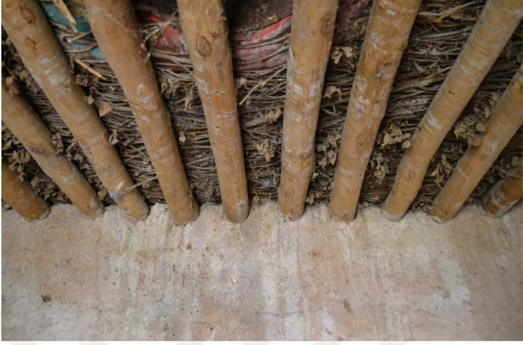
Şekil 5.104 Ahşap “direk”ler üzerine serilen çalı-çırpı, 2019
