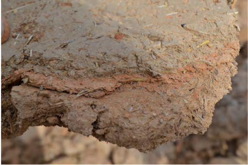
Şekil 5.110 Düz damda yenilenen çamur sıva katmanları, 2019
