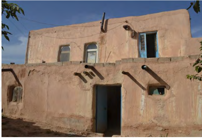
Şekil 6.48 Niteliksiz eklemelere örnek olarak soba boruları, 2020
