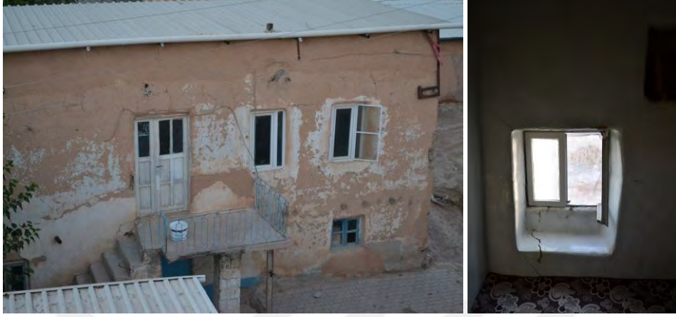
Şekil 6.41 Muhdes PVC doğramalar, 2020
