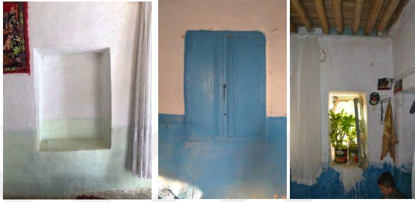
Şekil 6.35 Kireç sıva üstüne renkli yağlı boya yapılmış kerpiç duvarlar, 2020
