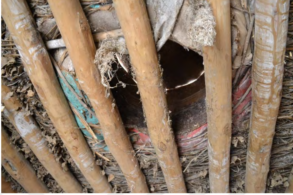
Şekil 5.34 Samanlık biriminin tavanında (düz toprak damda) açılmış saç kaplı delik, 2019
