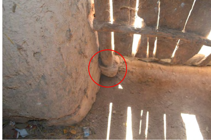
Şekil 5.46 Zeminde ahşap direğin hareket edebilmesi için koyulan taş, 2020
