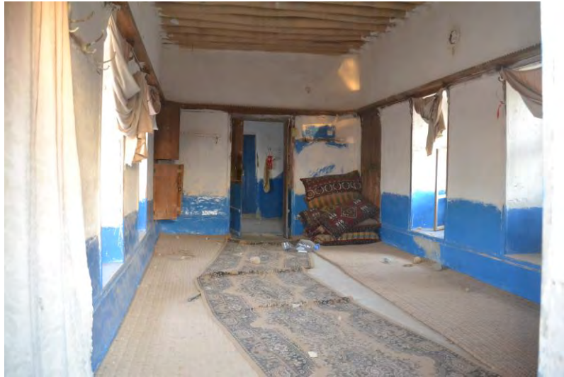
Şekil 5.116 Batı yönündeki odanın görünüşü, 2020
