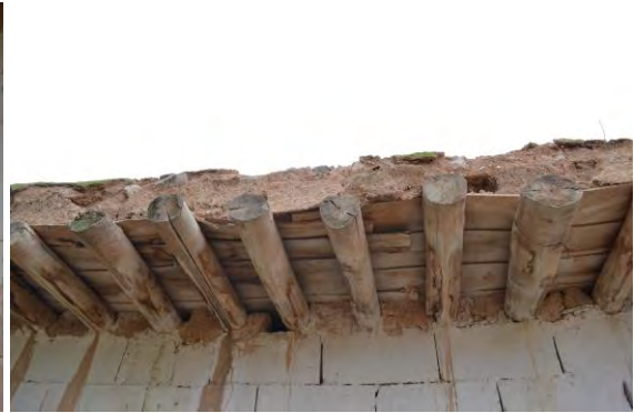
Şekil 5.85 Üstü "tap"larla kaplanan "direkler"den oluşan saçaklar, 2019,2020
