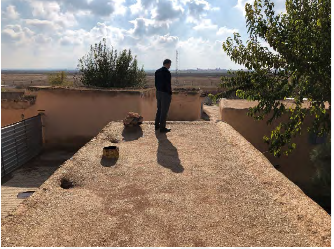
Şekil 5.109 Düz damda çamur sıvalı son katman, 2019
