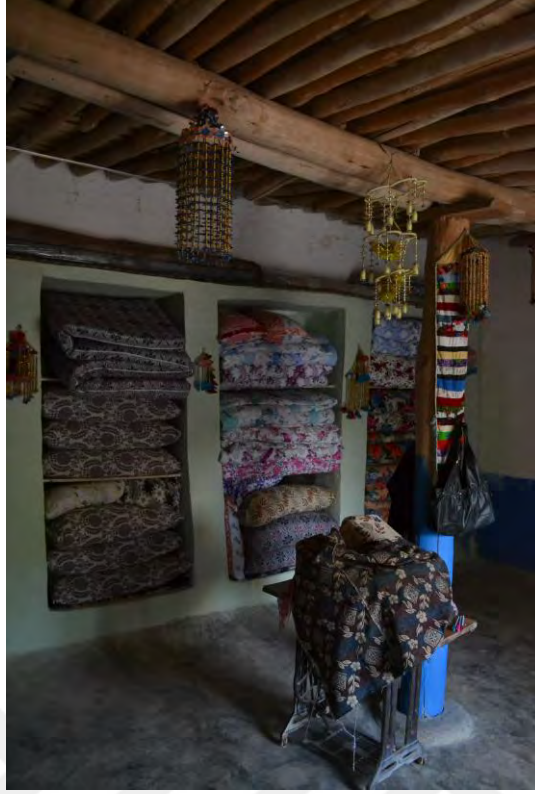
Şekil 6.29 Beton tabanlıklı ahşap taşıyıcı eleman, 2020
