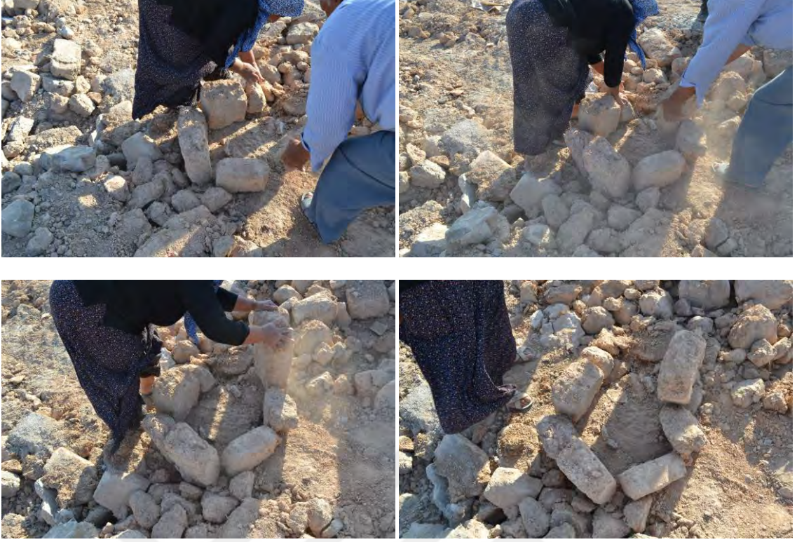
Şekil 5.64 Naise Demir ve Mustafa Demir tarafından gösterilen kerpiç bloklarla tandır yapımı, 2020
