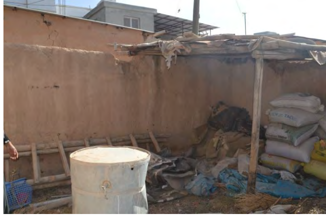
Şekil 6.17 Kullanılmadığı için üst örtüsü yıkılan oda birimi, 2020
