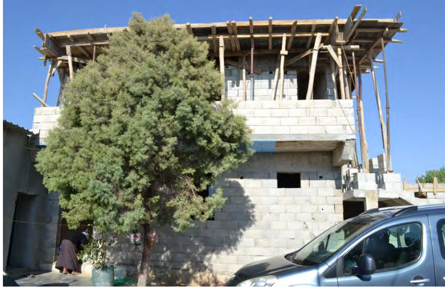
Şekil 6.14 Avlu içine yeni inşaat malzemeleriyle yapılmış yeni yapı, 2020
