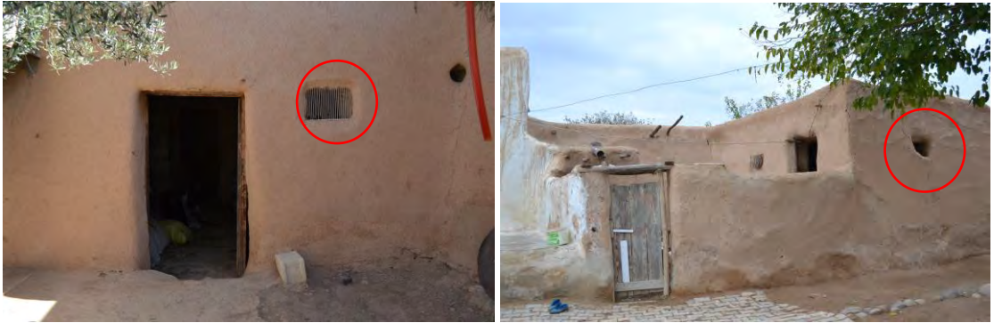
Şekil 5.59 Özgün parmaklıkları yok olmuş tepe pencereleri, 2020
