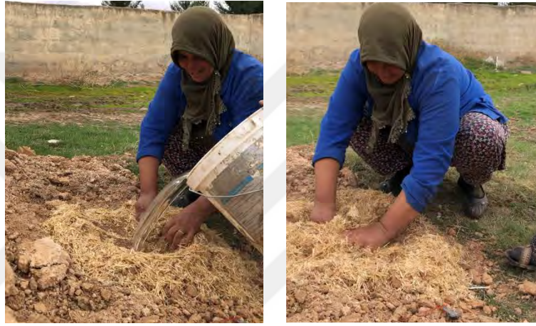
1-Toprak, su ve saman birleştirilir. 2- İyice özleşmesi için elle yoğrulur.
