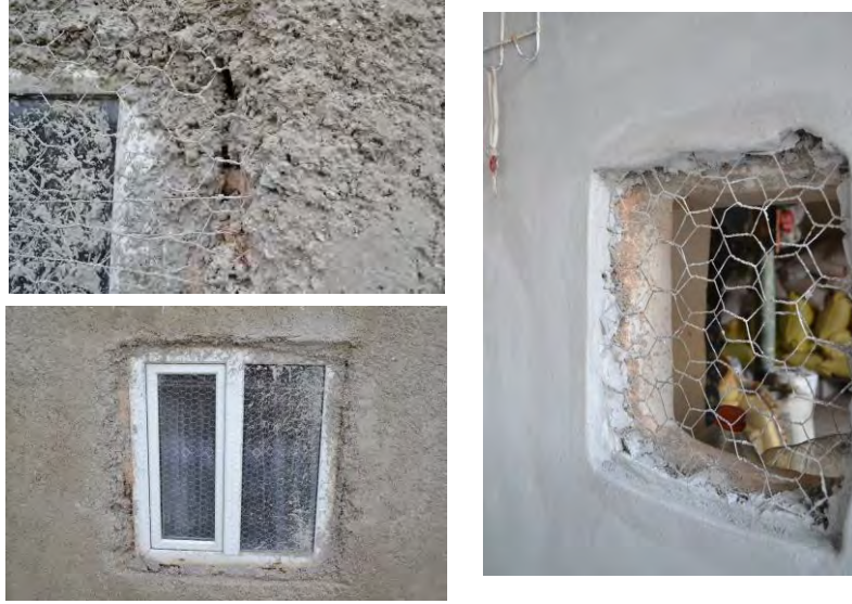
Şekil 6.30 Metal tel üstü çimento ile sıvanmış kerpiç duvar, 2019,2020
