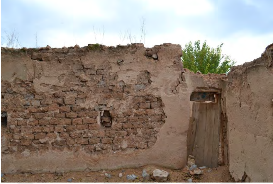
Şekil 5.93 Bindirmeli duvar örgüsü, “hel kesme”, 2019
