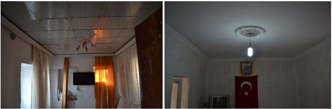
Şekil 6.34 Ahşap kirişler kapatılarak oluşturulan düz tavanlar, 2019
