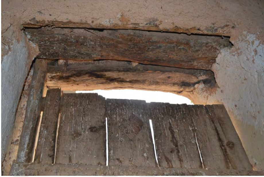
Şekil 5.47 Kapı üstü “şapta”ları arasına yerleştirilen ahşap direk, 2020
