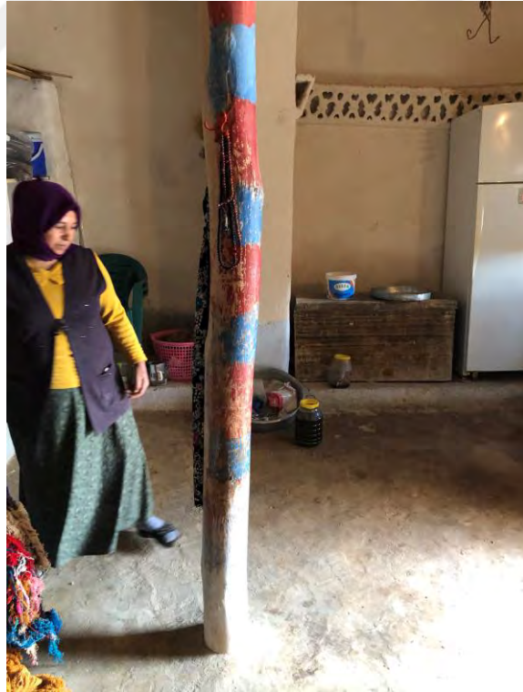
Şekil 6.28 Tabanlığı olmayan ahşap taşıyıcı eleman, 2020
