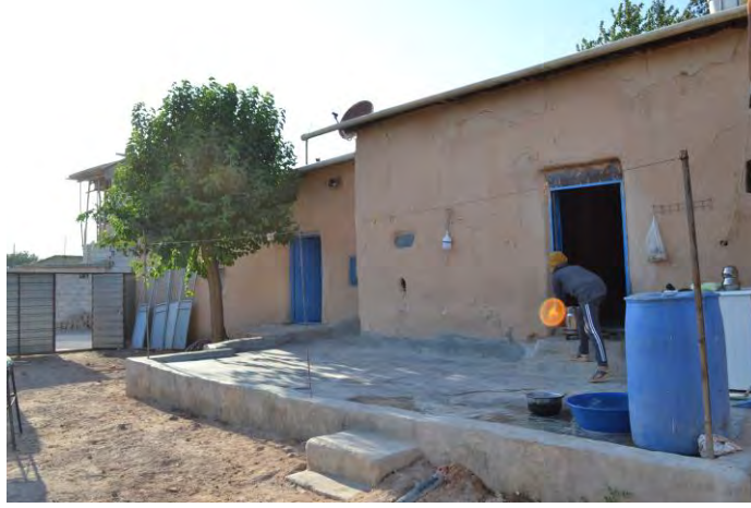
Şekil 5.83 Odaların önünde betonla yenilenmiş seki, 2019
