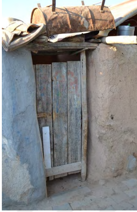
Şekil 5.49 Kilitsiz özgün ahşap çakma kapı, 2020
