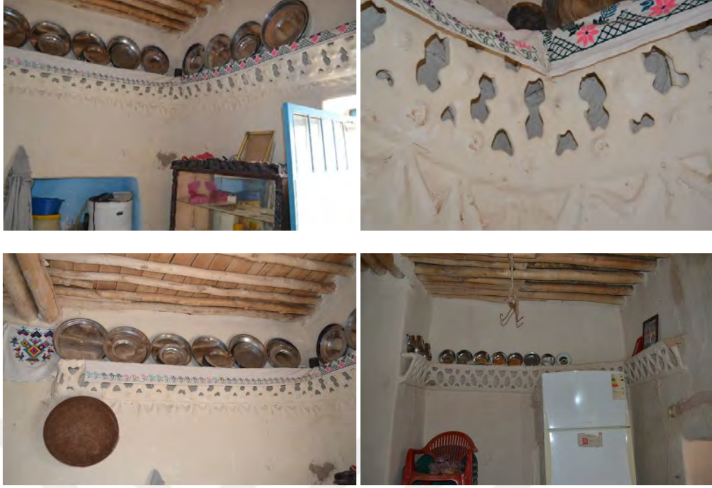
Şekil 5.77 Kadınlar tarafından beyaz toprak ve buğday sapıyla yapılan özgün raf süslemeleri, 2019
