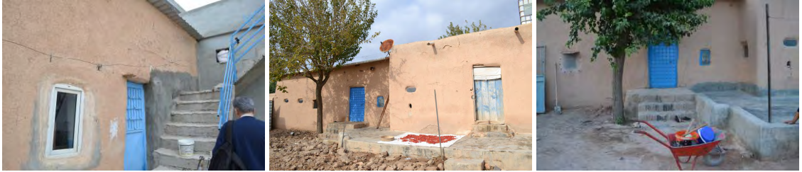
Şekil 6.39 Özgünde ahşap iken metal ile değiştirilen kapılar, 2019
