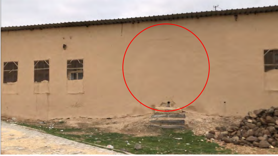
Şekil 5.121 Kerpiç bloklarla örölüp kapatılan güney kapı, 2020
