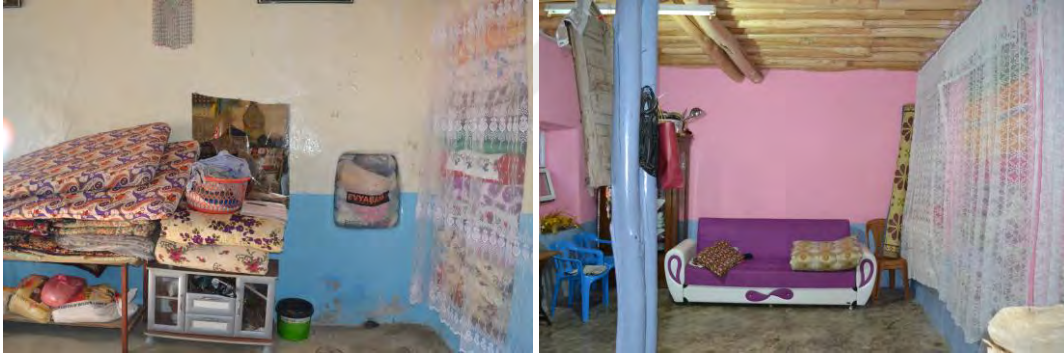
Şekil 6.36 Renkli yağlı boya ile boyanmış kerpiç duvarlar, 2020
