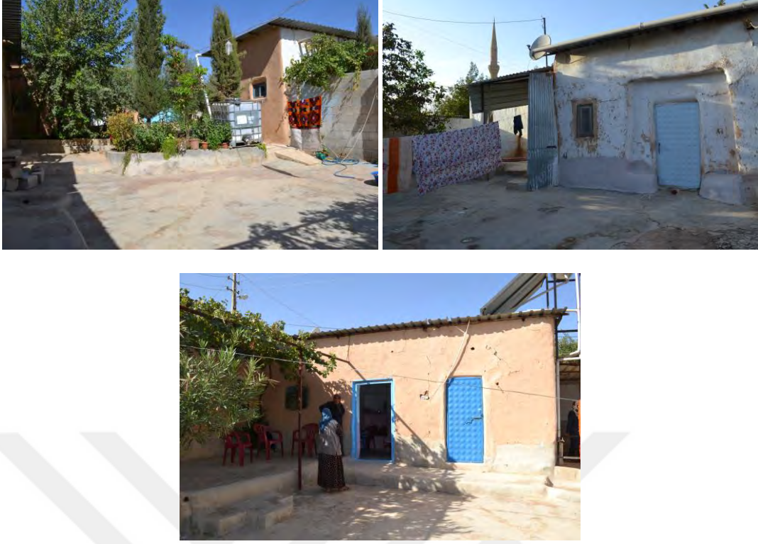
Şekil 6.50 Beton ile kaplanan avlular, 2020
