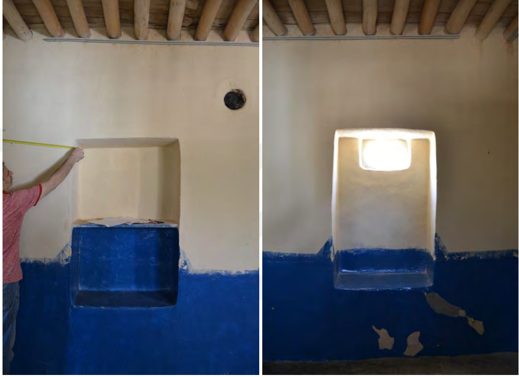
Şekil 5.53 Oda birimlerindeki sokak cephesinde sağır niş (solda), avlu cephesinde oval açıklıklı niş (sağda), 2020
