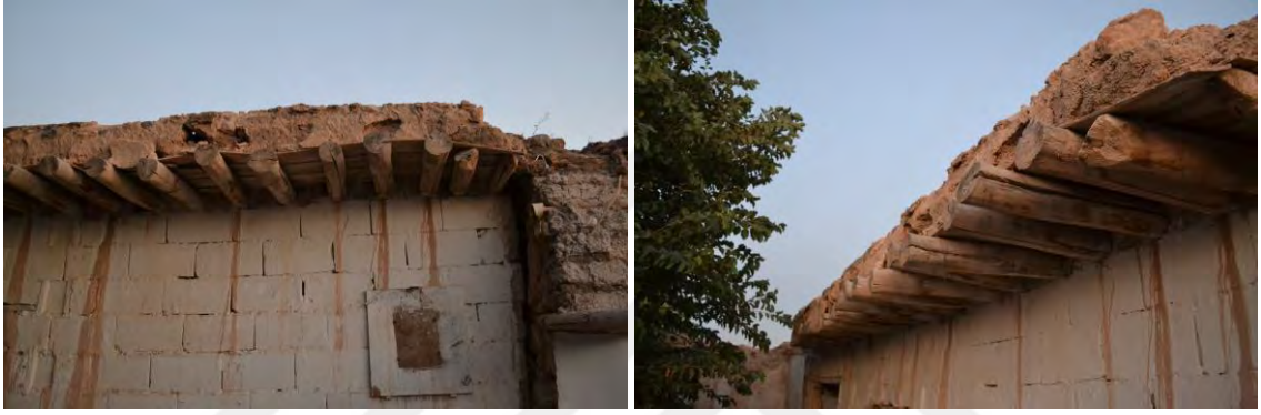
Şekil 5.103 Saçak kotunda üstü ahşaplarla (“tap”larla) örtülen ahşap “direk”ler, 2020
