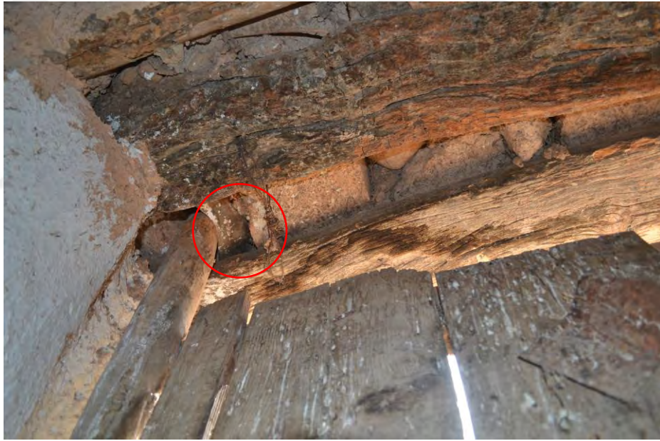
Şekil 5.48 Direğin kaymaması için “şapta”lara dik koyulan tahta parçası, 2020
