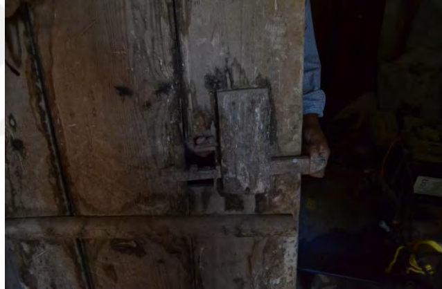
Şekil 5.50 Özgün ahşap kilit, 2020
