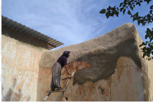
Şekil 6.31 Özgün sıvalı kerpiç duvar üzerine çimento katkılı çamur sıva işlemi, 2020
