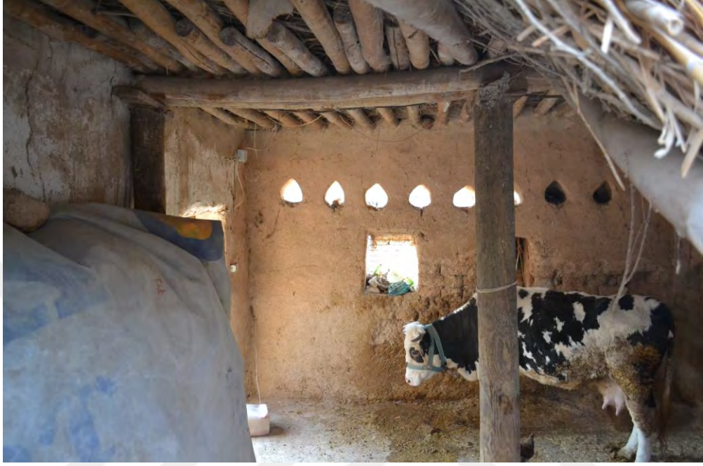
Şekil 5.28 Kerpiclerin “çatılması”yla oluşturulan tepe pencereleri, “tağa”, 2019
