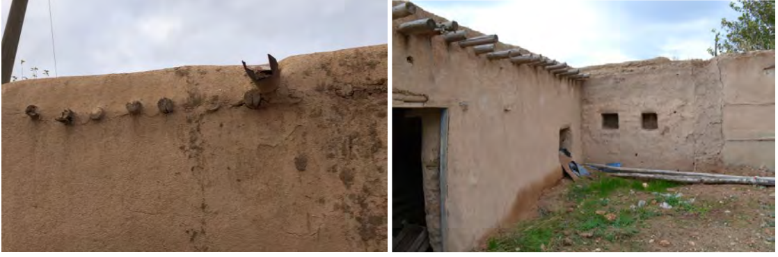
Şekil 5.102 Cephede dışarıya taşan ahşap “direk”lerden, solda kesilmiş, sağda kesilmemiş örnekler, 2019
