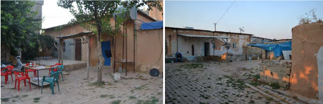
Şekil 6.49 Kilit taşı ile kaplanan avlular, 2020
