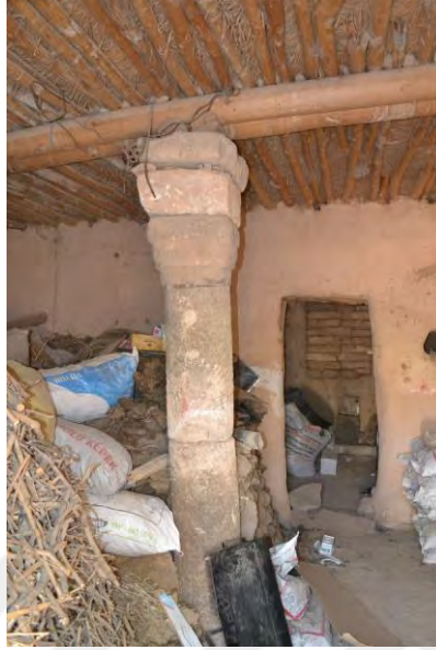
Şekil 5.113 Ahır biriminde taşıyıcı eleman, devşirme sütun, 2020
