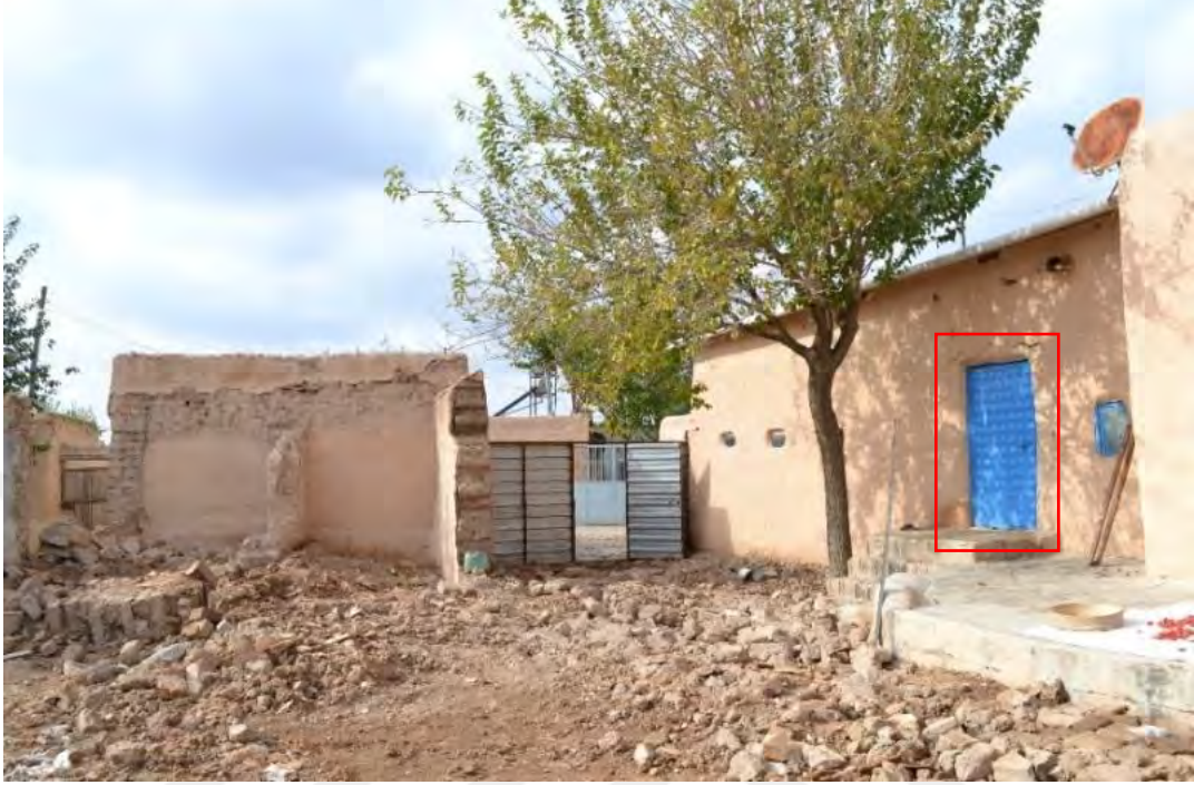
Şekil 5.52 Özgün ahşap kapısı metal malzemeye değiştirilmiş oda kapısı, 2019
