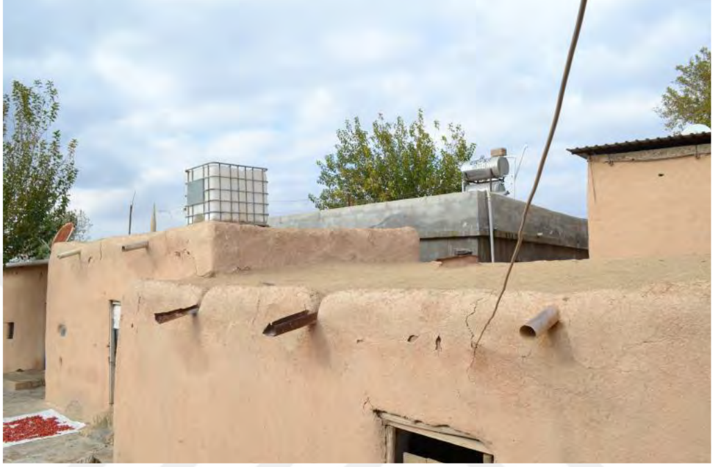
Şekil 5.111 Teneke ve plastik borulardan yapılan muhdes çörtenler, 2019
