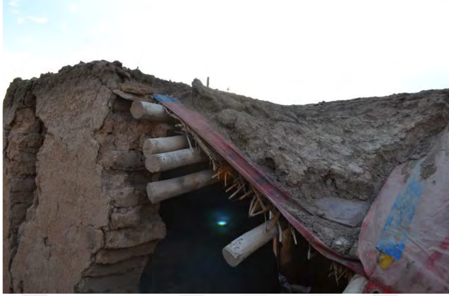
Şekil 5.108 Ara katmana muşamba serilmiş toprak dam, 2019
