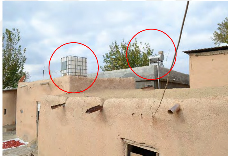
Şekil 6.46 Düz damlara yerleştirilen su depoları ve güneş enerjisi panelleri, 2019 Yapıların çörtenleri eskiden ahşap malzemelerden yapılırken günümüzde plastik borularla, teneke malzemelerle değiştirilmişlerdir (Şekil 6.47).
