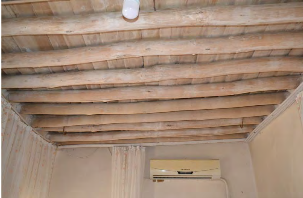
Şekil 5.107 Ahşap “direk”ler üzerine dizilen tahtalar (“tap”) , 2019
