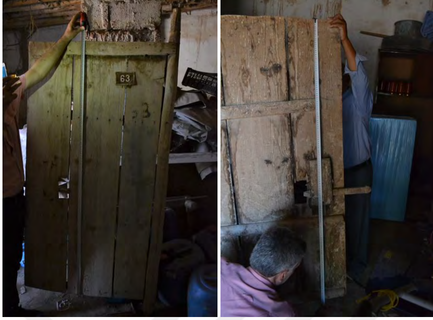
Şekil 5.43 Özgün ahşap çakma kapı, 2020
