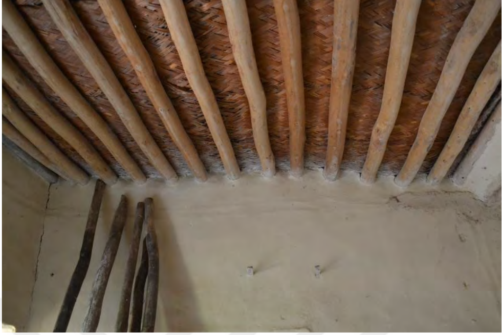
Şekil 5.99 Düz dam tavanında ahşap kirişler ("direk"ler) ve hasır örgü katmanı, 2019
