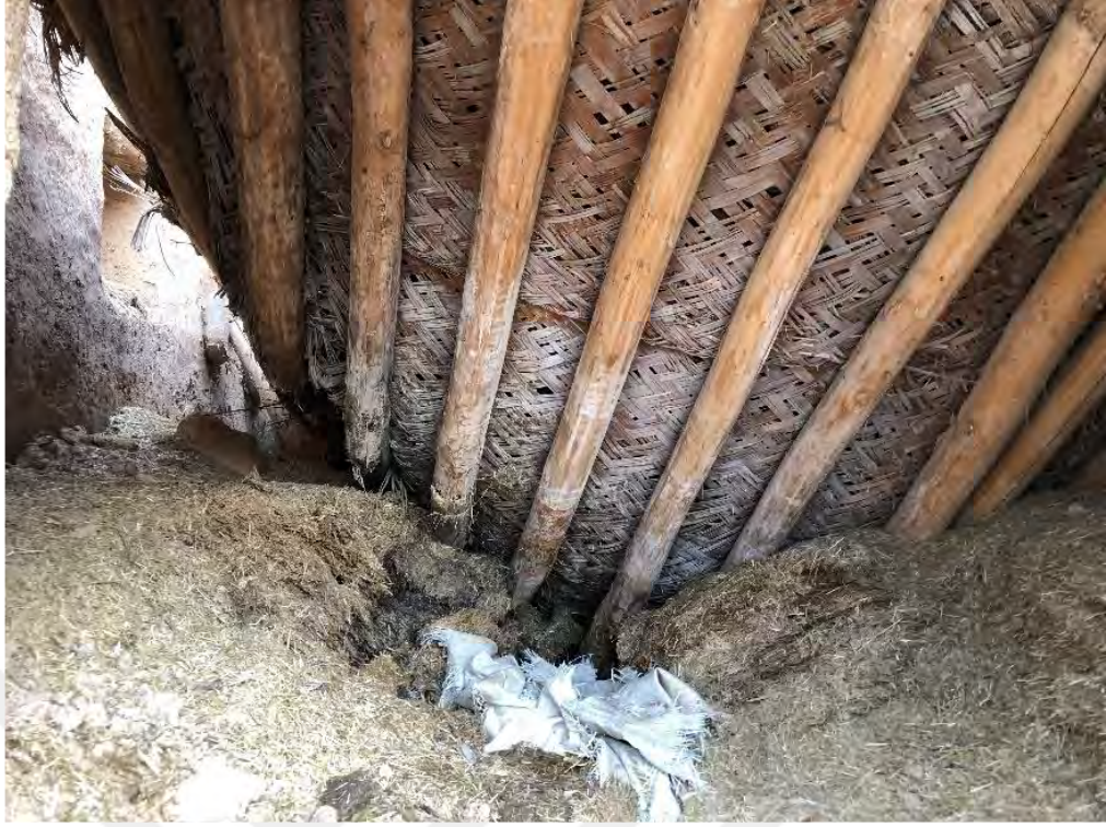
Şekil 5.106 Ahşap “direk”ler üzerine serilen özgün hasır örgüler, 2019
