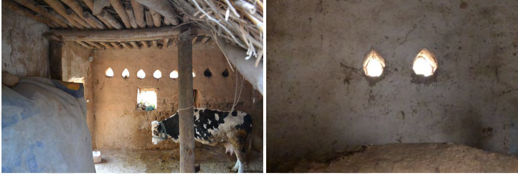
Şekil 5.56 İki kerpicin “çatılması”yla oluşturulan “tağa”lar (pencereler), 2019
