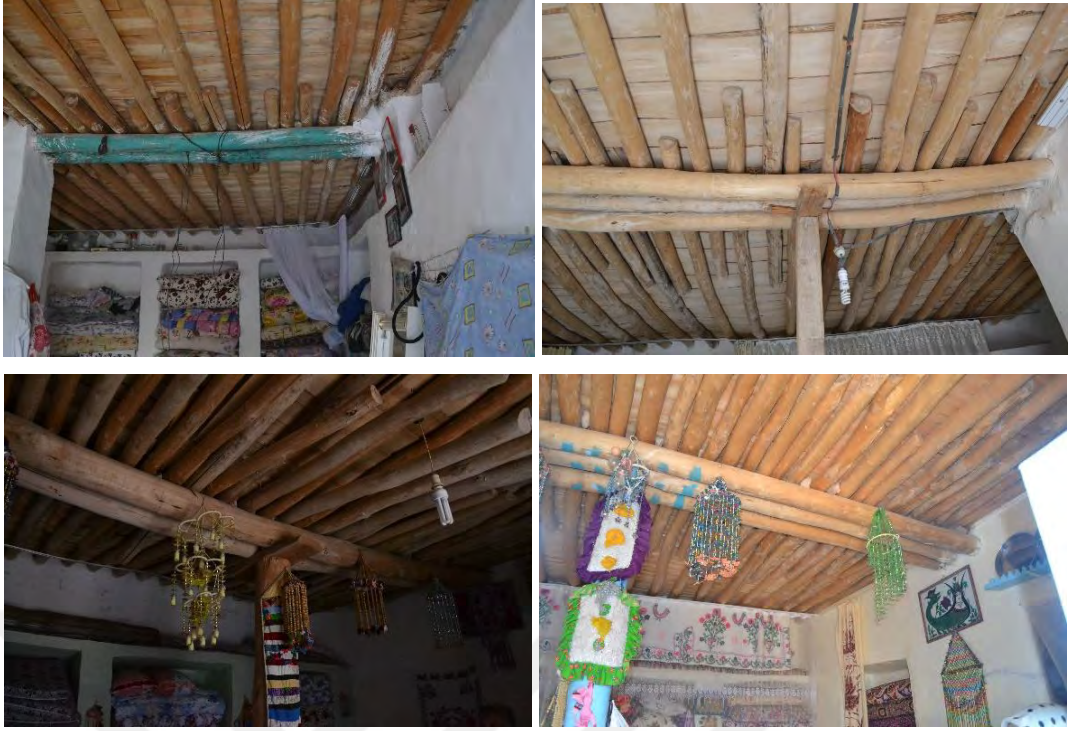
Şekil 5.3 Yatak odası mekânının tavanında çift kiriş kullanımı, 2020
