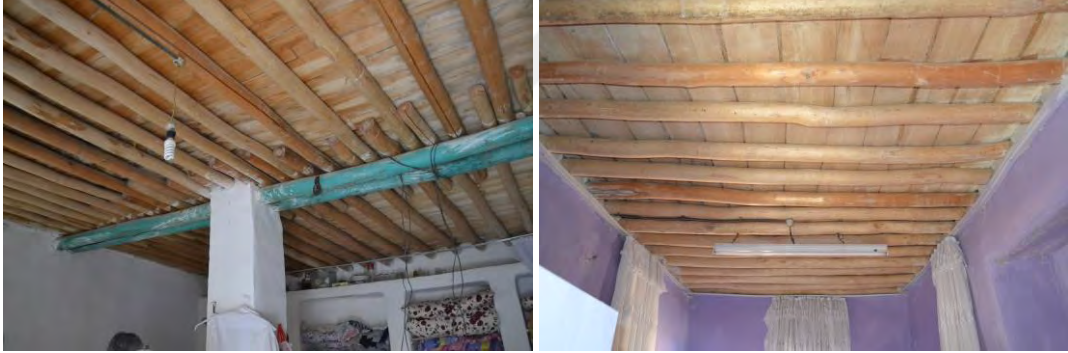
Şekil 6.33 Ahşap “direk”lerin üstüne yerleştirilen ahşap kaplama malzemesi, “tap”, 2020
