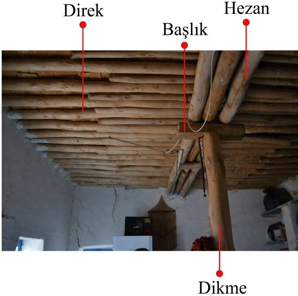
Şekil 5.101 “Hezan” ve altında dut ağacından yapılan ahşap “başlık”, “direk” ve “dikme” 2019
