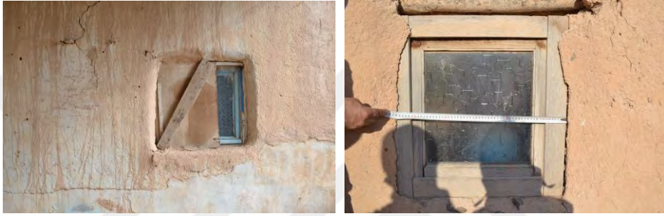
Şekil 5.54 Ahşap doğramalı muhdes pencereler, 2020
