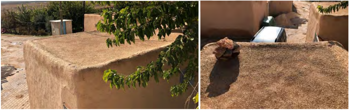
Şekil 5.87 Duvarlarda ve toprak damda yuvarlatılarak sıvanmış köşeler ve kenarlar, 2019
