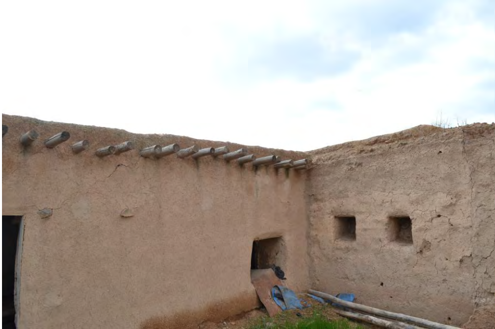
Şekil 5.29 Dörtgen ahır pencereleri, 2019
