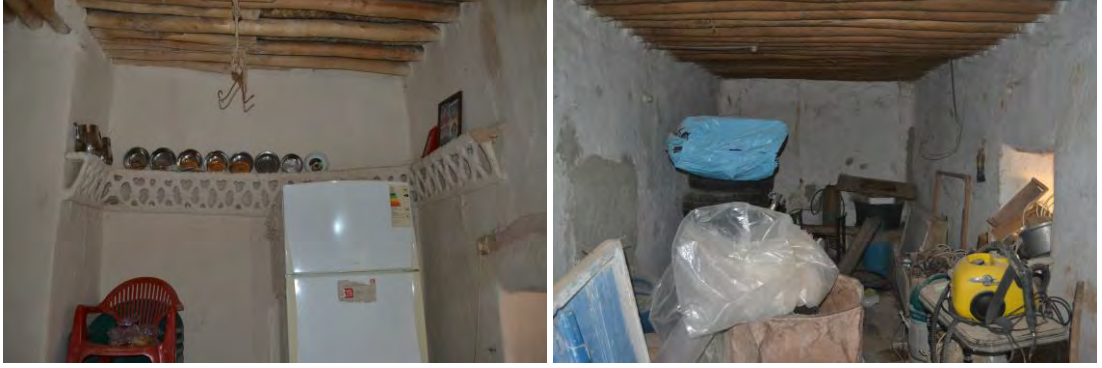
Şekil 6.38 Ahşap kirişlerin duvarla birleşim yerlerinde boyanması, 2020
