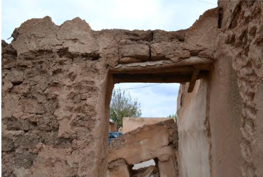
Şekil 5.94 Pencere üzerinde ahşap taşıyıcı elemanlar “şapta”, 2019
