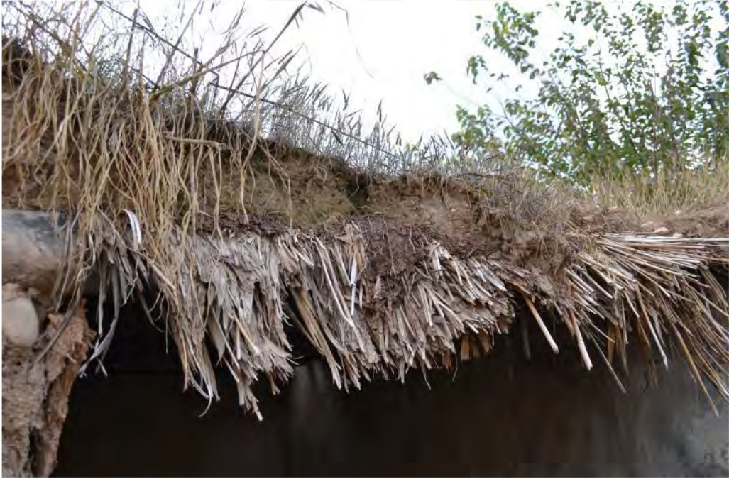
Şekil 5.105 Ahşap “direk”ler üzerine serilen kamışlar, 2019
