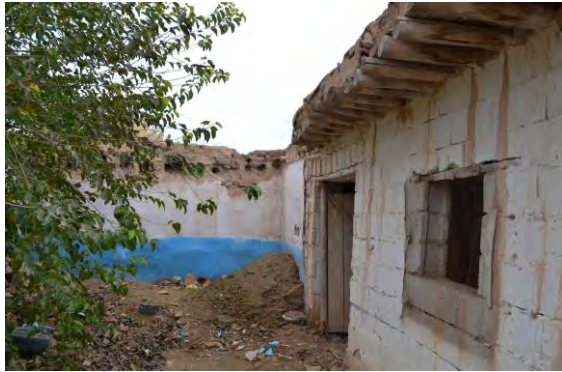
Şekil 5.85 Üstü "tap"larla kaplanan "direkler"den oluşan saçaklar, 2019,2020
