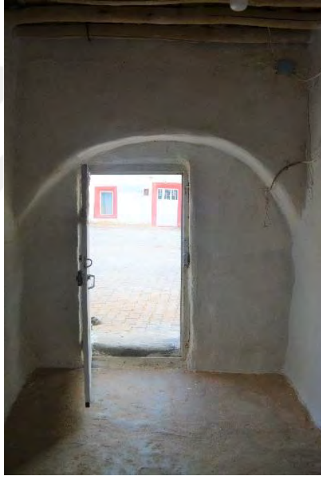
řekil 5.96 Kemerli giriře sonradan eklenen kapı, 2019
