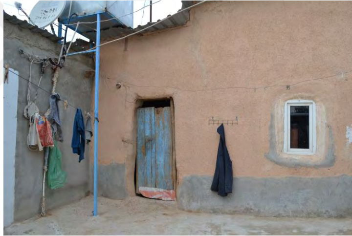
Şekil 6.26 Yalıtım için zemin kotuna yakın kısmen çimento sıvanmış kerpiç duvar,2019
