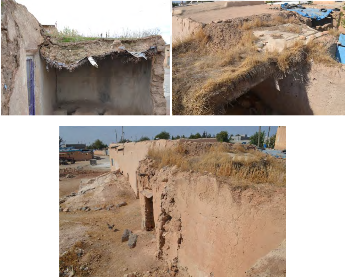
Şekil 6.20 Temizlenmeyen ve büyüyen otlar sebebiyle fazla su alıp çöken toprak dam, 2019
