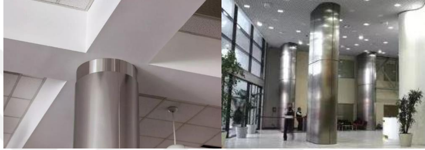
Şekil 10 Metal malzeme ile kaplaması tamamlanmış kolon ve beton malzemeli kiriş görünüm. (URL 7)
