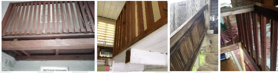
Şekil 167 Ahşap merdiven ve korkulukları görünümü.(Hasan, Hızır Atıla Evi: Hanedar Arşivi, 2021)
