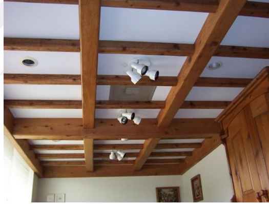
Şekil 85 Geleneksel Karadeniz evi ahşap giriş görünümü verilen dekoratif kalaslar (Hanedar Arşivi, 2020)
