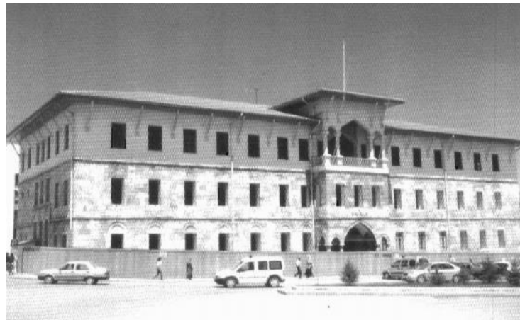
Şekil 12 Sivas Valilik Binası-Hükümet Konağı, (Aktemur, Arslan, 2010; 32)
