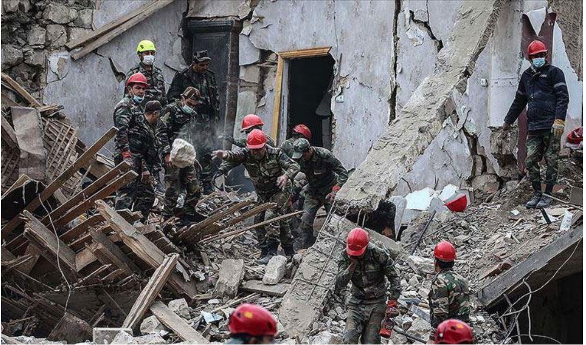
Şekil 3.13 Gence'ye Atılan Füze Sonrası Betonarme Binada Oluşan Hasarlar
