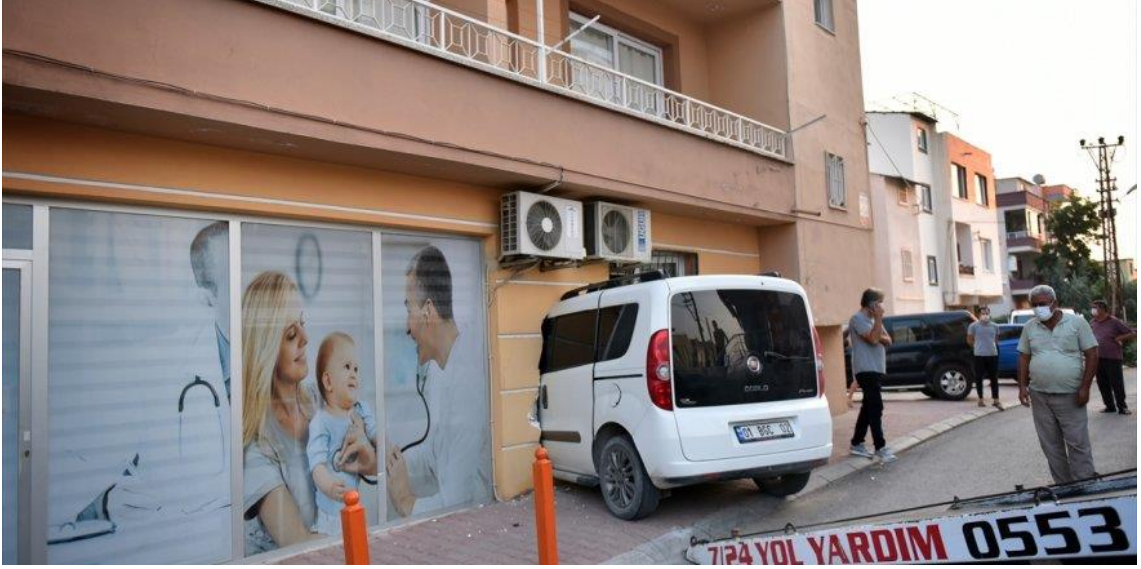
Şekil 3.11 Betonarme Binaya Çarpan Araç
