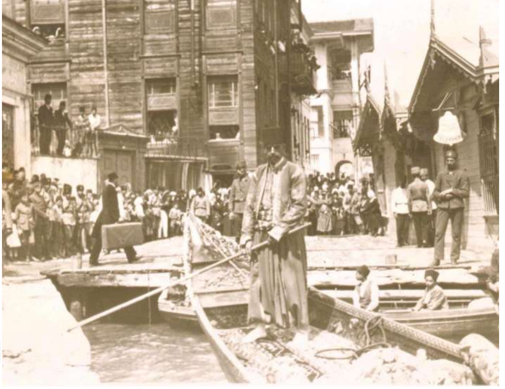
Şekil 1.69 Emirgân Camii hizasındaki iskele, 1923 (Bayram, t.y).
