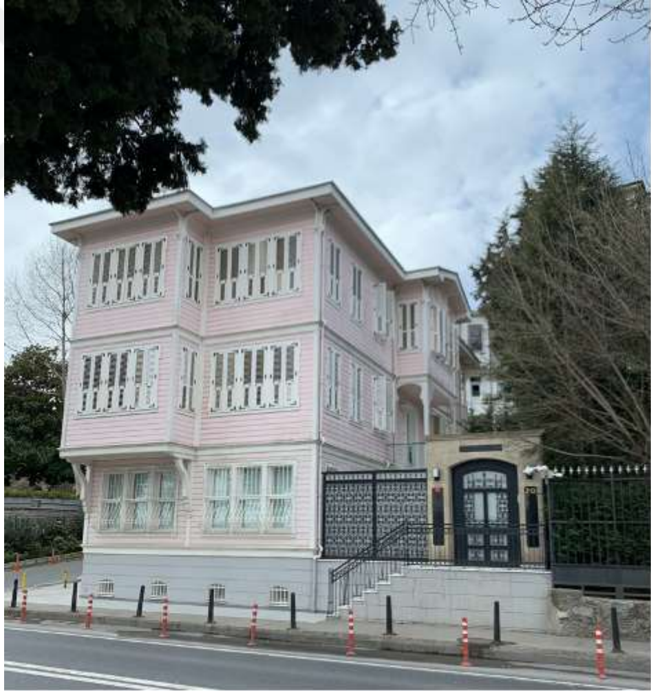
Şekil 1.99 86 Ada 10 Parsel 'deki Pembe Yalı
