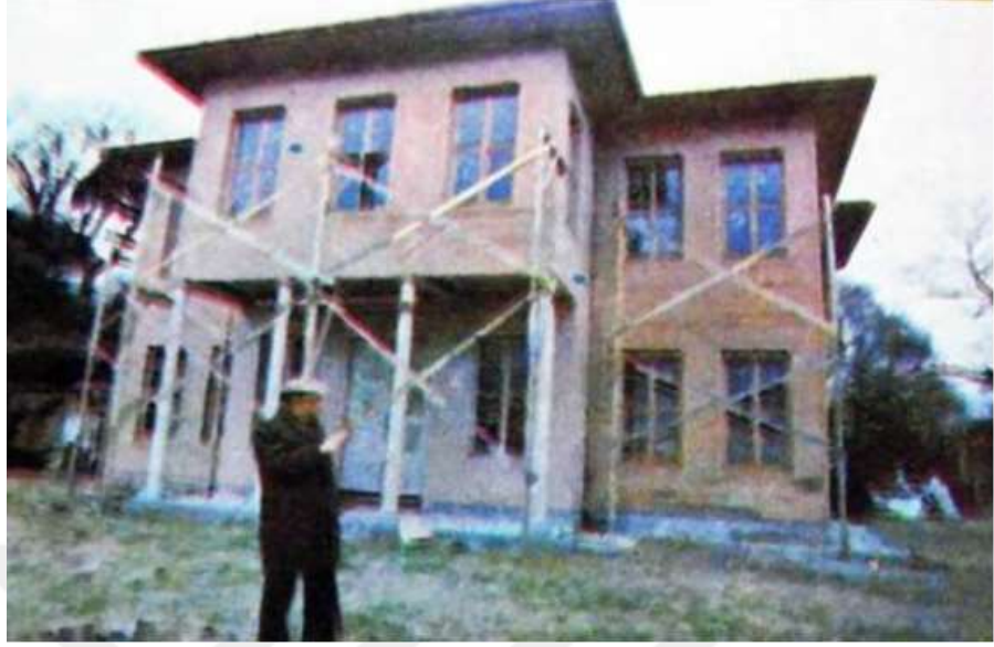
Şekil 1.78 Pembe Köşk Restorasyonu (emlakkulisi.com)
