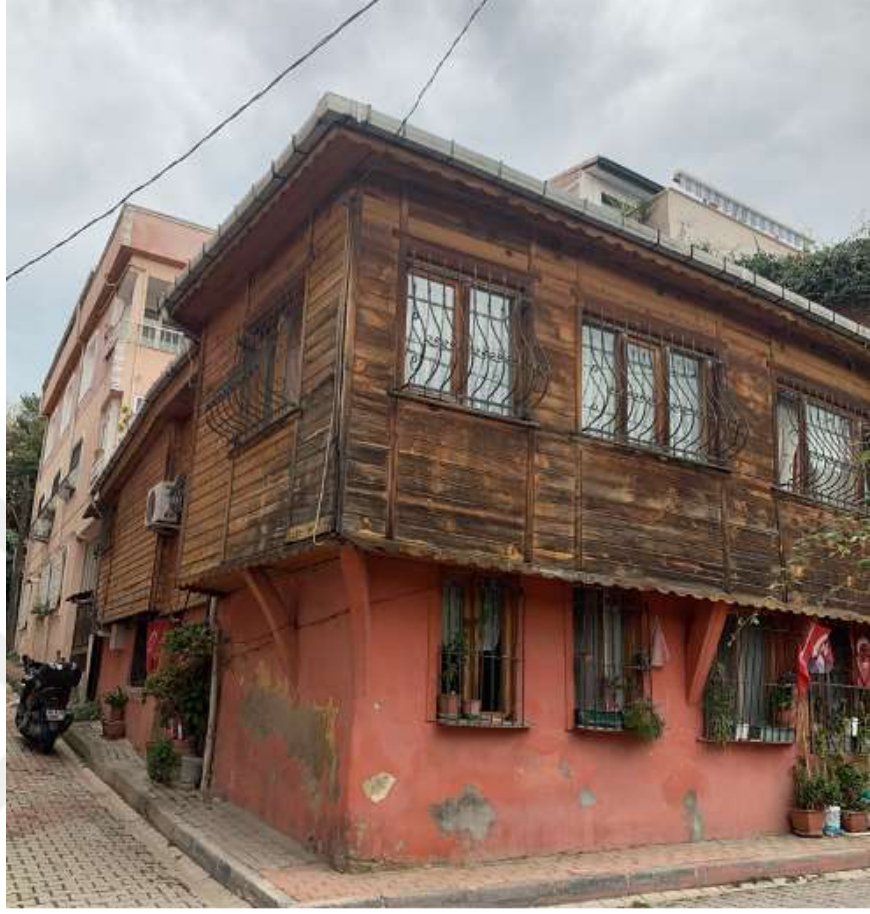
Şekil 1.103 Muhdes Eklmelerle Özgünlüğünü Yitirmek Üzere Olan Yapı
