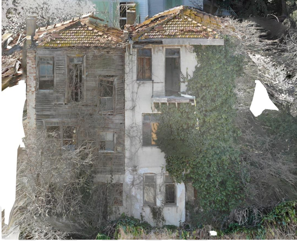
Şekil D.3: Drone Fotoğraflarından Oluşturulmuş Doğu Cephesi Ortofotosu (Mart 2020).
