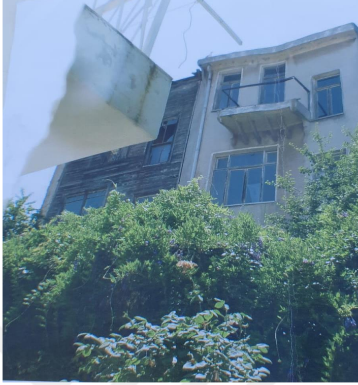
Şekil B.10 : Doğu cephesi, ~2000 (Aile arşivi).
