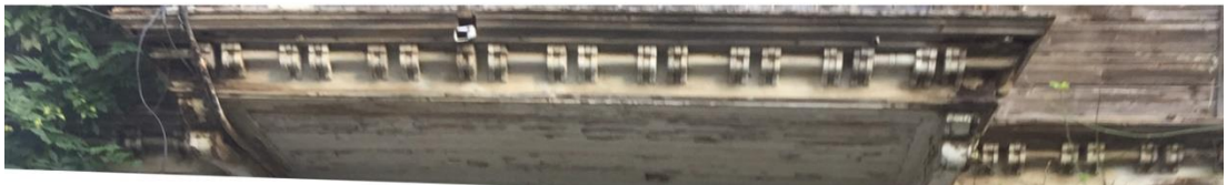
Şekil 3.22 : Ahşap kat silmesi ve üzerindeki süslemeler.
