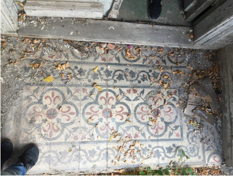
Şekil E.42: Giriş bölümünde bulunan karosiman döşeme kaplamaları.
