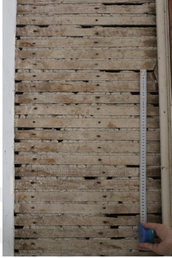
Şekil E.37: 102 Oda mekânında bulunan ahşap bağdadi çıtaları.
