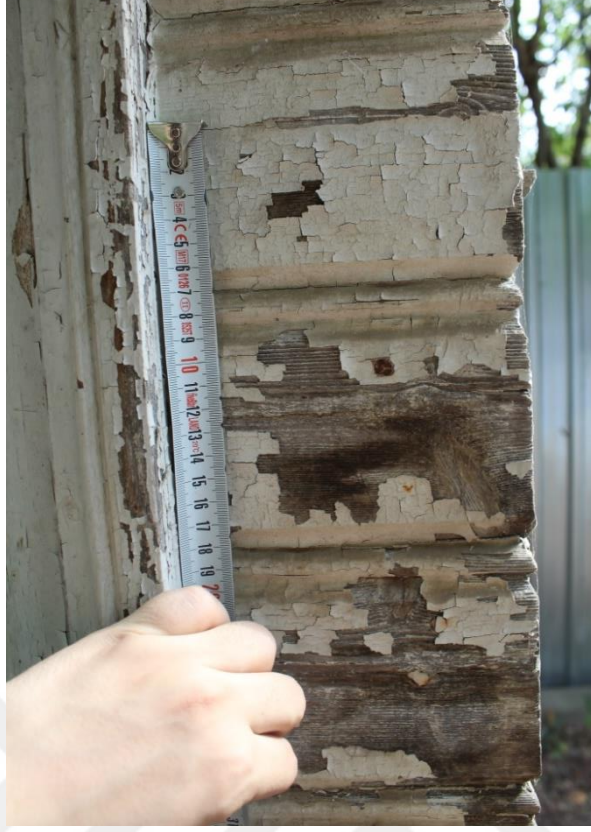
Şekil E.39: Ahşap lambalı cephe kaplaması.
