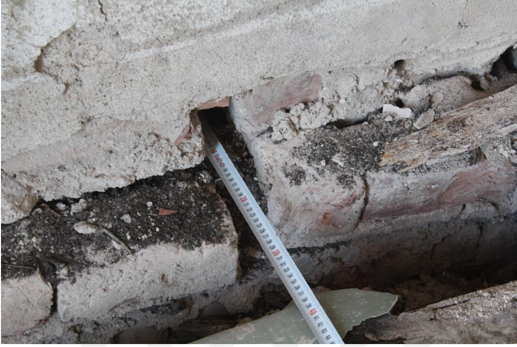
Şekil E.33: 106 Oda mekânı tuğla yangın duvarındaki döşeme yuvası.
