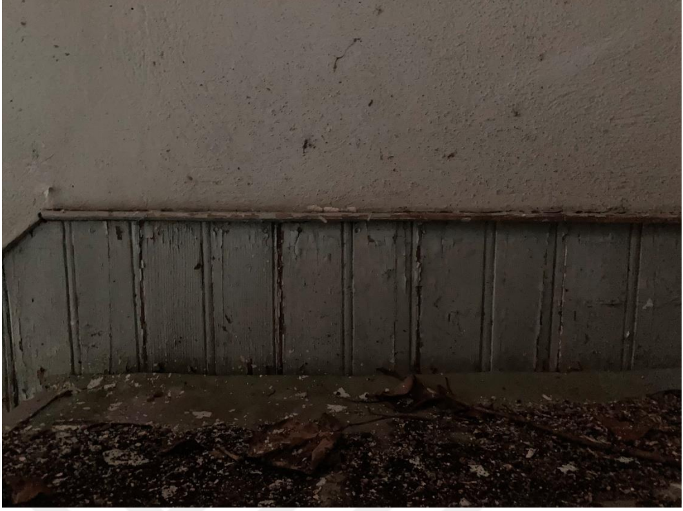
Şekil E.47: Ahşap süpürgelik.
