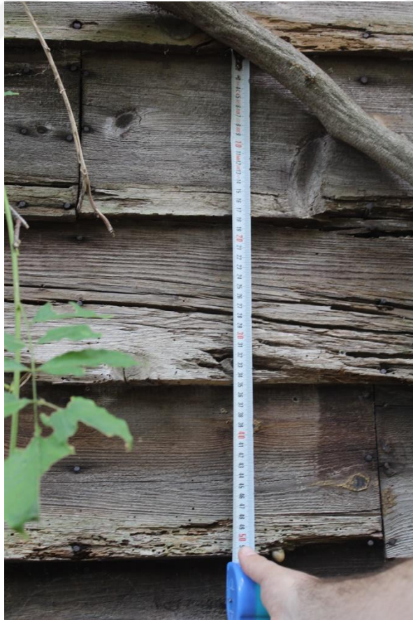
Şekil E.40: Ahşap yalıbaskı cephe kaplaması.
