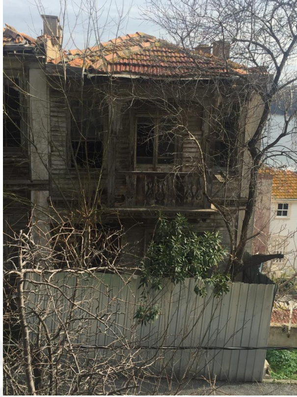
Şekil E.67: 11 parseldeki yapının batı cephesi.
