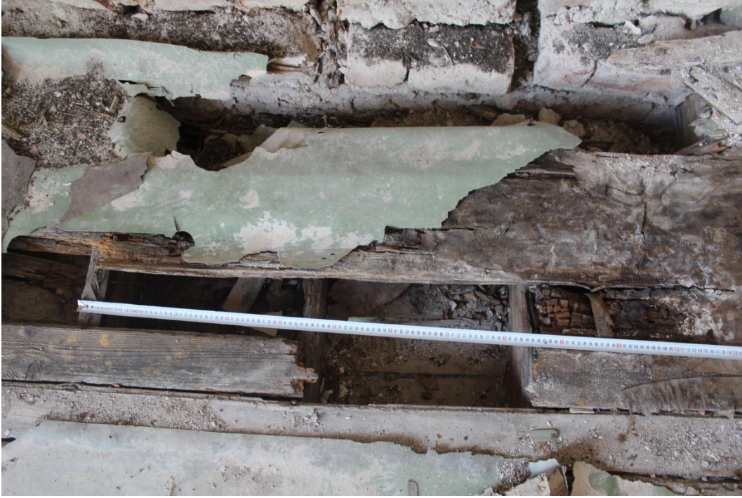
Şekil E.34: Ahşap döşeme kirişleri.
