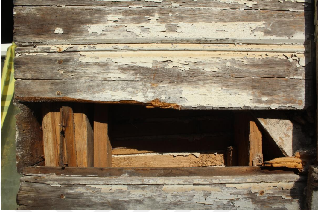
Şekil E.35: Ahşap karkas dikmeleri.
