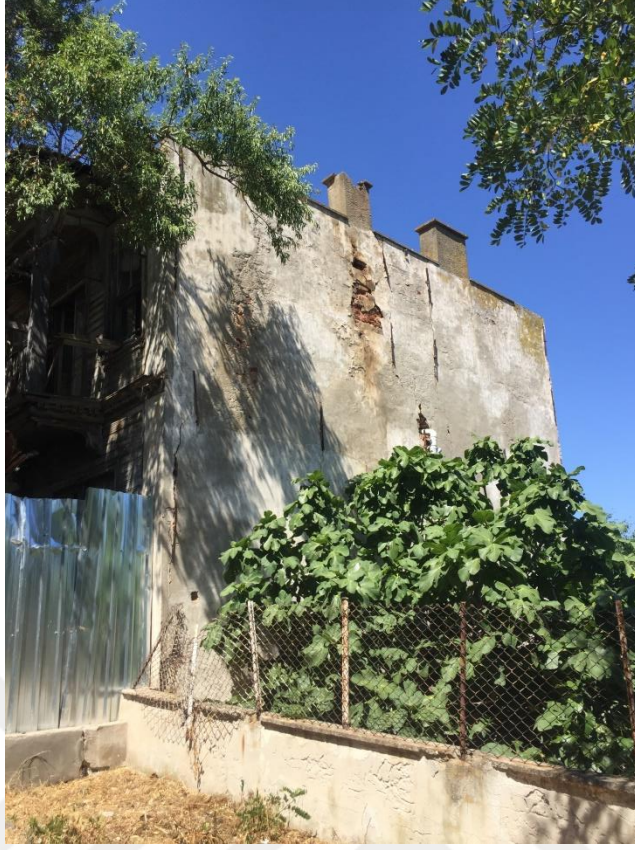
Şekil E.31: Güney cephesi.
