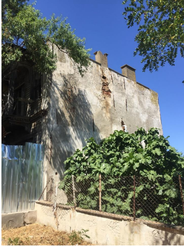
Şekil E.66: 11 parseldeki yapının güney cephesi.
