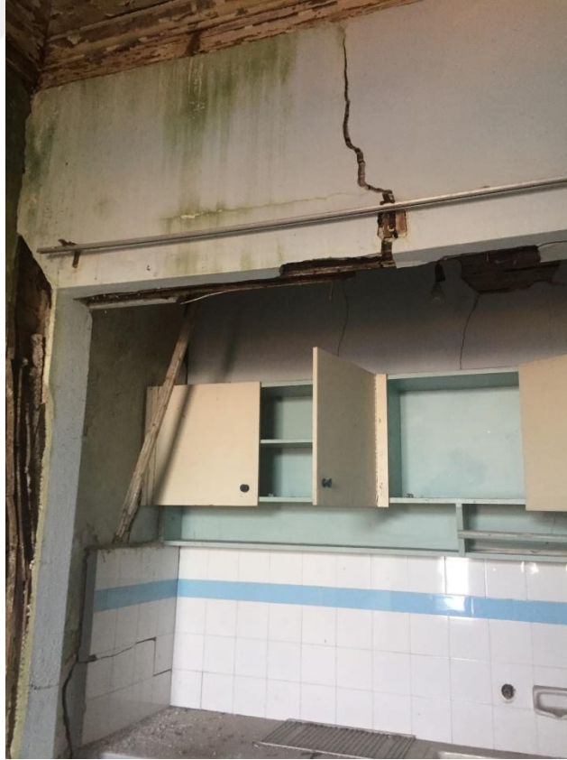
Şekil E.50: Ahşap dikmede çürüme ve malzeme kaybı.
