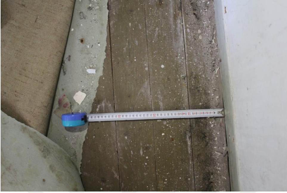
Şekil E.41: Ahşap döşeme kaplamaları.
