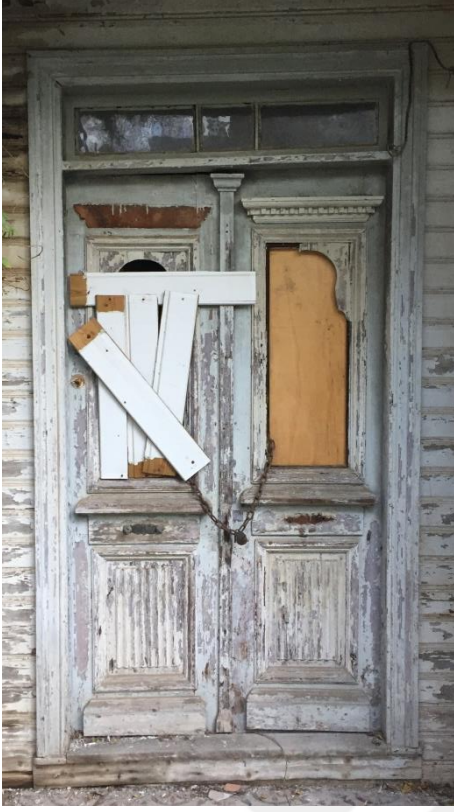
Şekil E.45: Ahşap çift kanatlı giriş kapısı.
