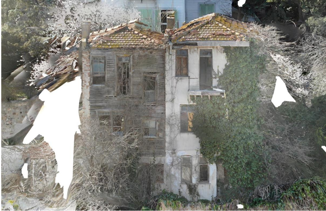
Şekil E.30: Doğu cephesi.
