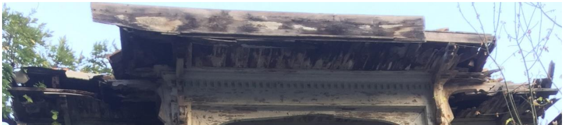
Şekil 3.23 : Ahşap koltuk silmesi ve üzerindeki süslemeler.
