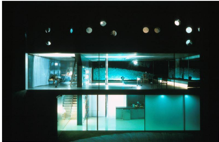
Şekil 2.18. Bordeaux Evi Dış Görünüş (Kayım, 2008)
