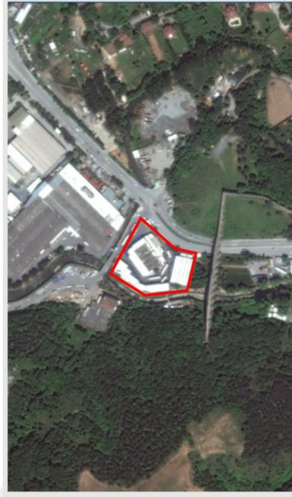
Şekil 4.13 : Hamidiye Kaynak Suyu Tesisi uydu görüntüsü.
