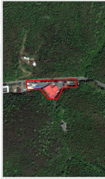
Şekil 4.39 : Sırmakeş Kaynak Suyu Tesisi uydu görüntüsü.
