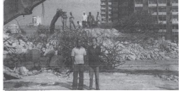
Foto 4.34: Çadırcı ile yıkım operasyonundan sorumlu çalışan (Çadırcı, 1991, s. 133).
