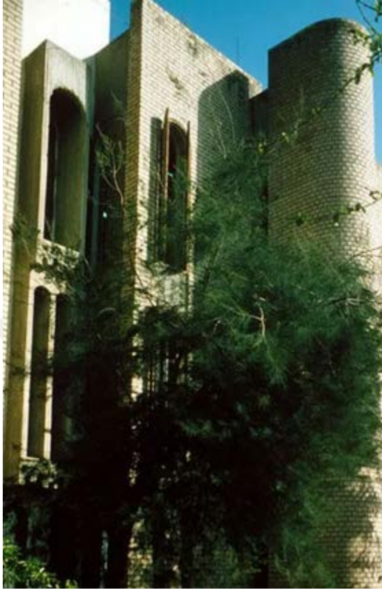
Foto 4.26: Hsır el-Tabiğ binası (1967) (Al-Mallak, 2021).
