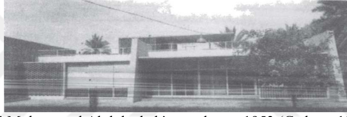
Foto 4.27: Muhammed Abdülvahab'ın ev duvarı 1953 (Çadırcı, 1991, s. 68).
