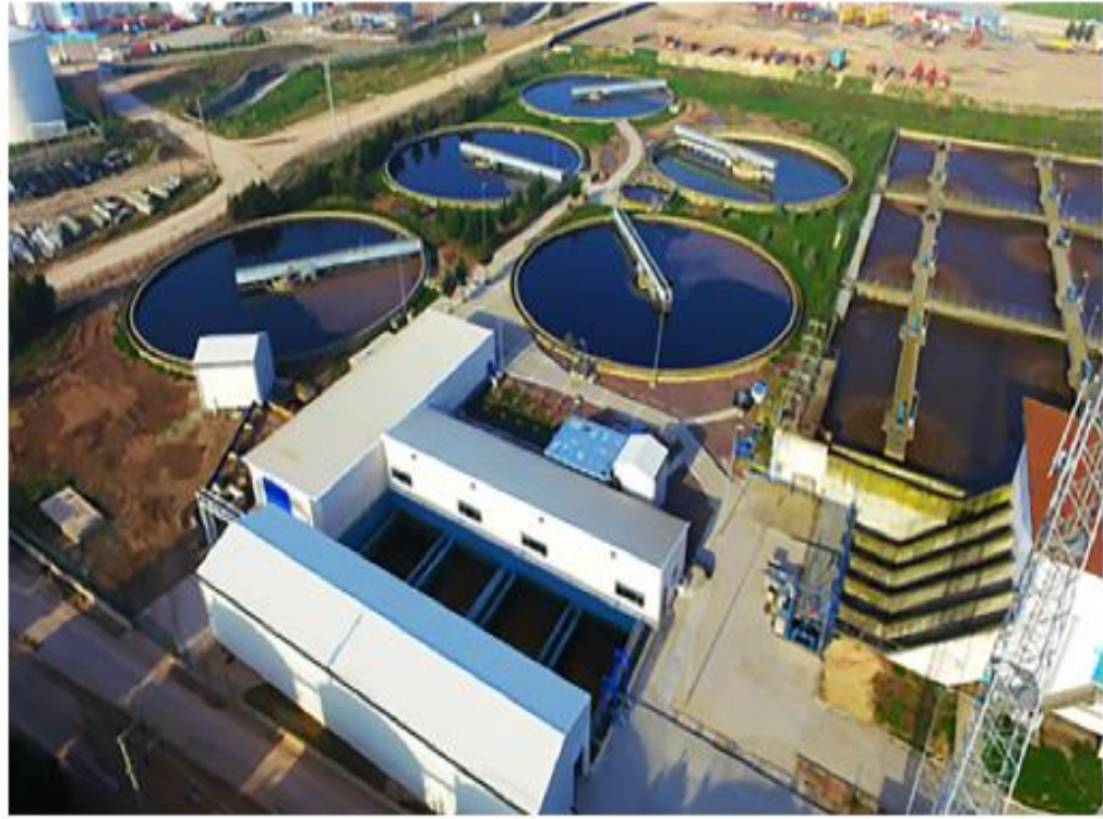
Şekil 3. 3. Atıksu arıtma tesisinin genel görünümü
