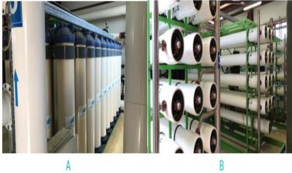
Şekil 3. 2. UF ünitesi (A) ve RO ünitesinin (B) genel görünümü
