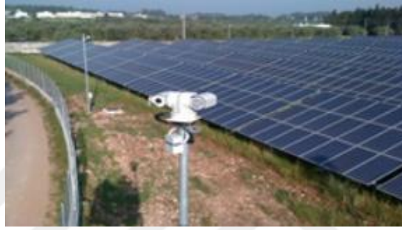
Resim 3.40 Güneş enerji santrallerinde kamera sistemi
