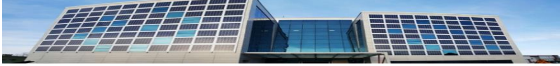
Resim 2.5 Binaya entegre fotovoltaik güneş enerjisi sistemi 110 KW [26]
