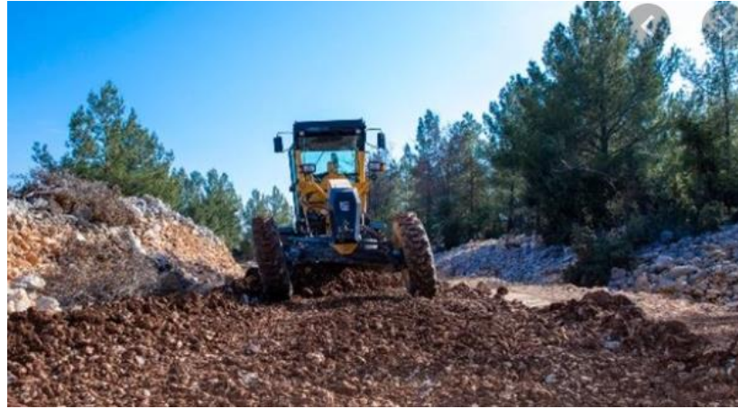
Resim 5.7 Yol yapım çalışması
