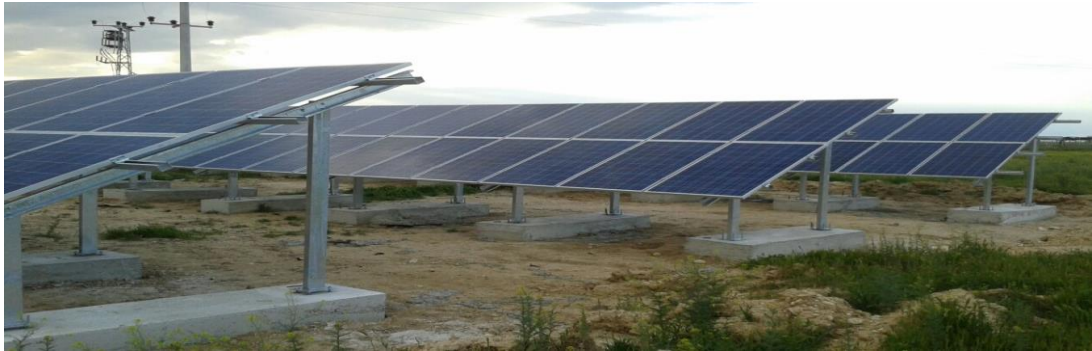
Resim 3.16 Beton blok yöntemi
