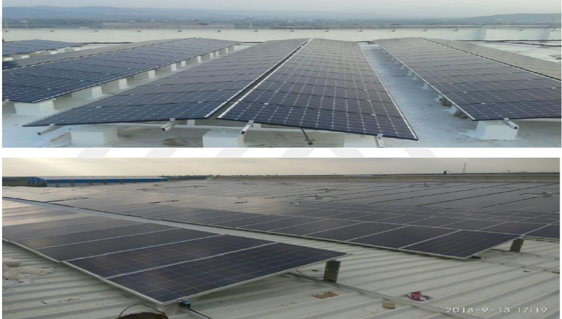
Resim 3.20 2 Farklı tipte çatı montajı sistemi örneği
