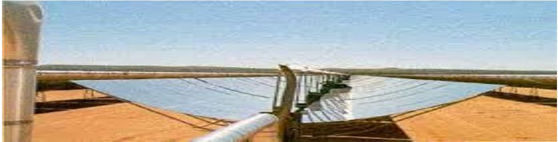
Resim 1.5 Parabolik Oluk Kolektörler [13]
