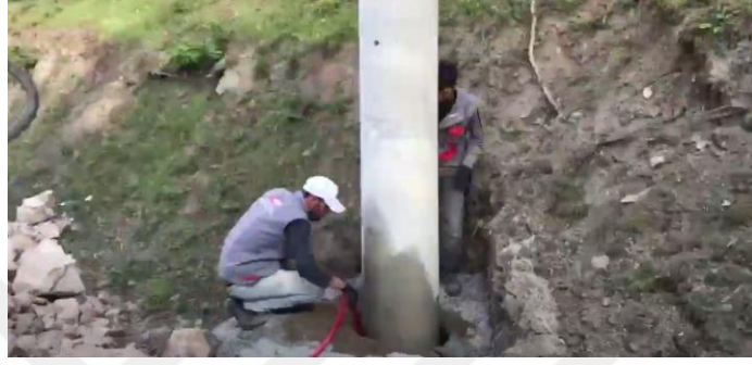
Resim 5.9 Enerji Nakil Hattı direği Dikme İşlemi [108]
